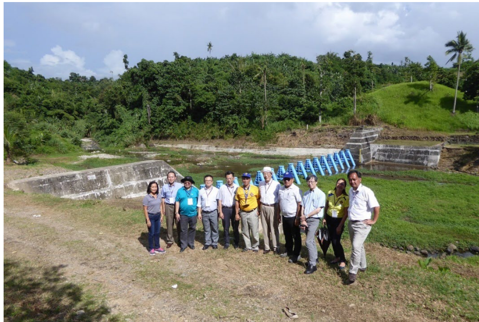
オルモック市のスリットダム現地調査
