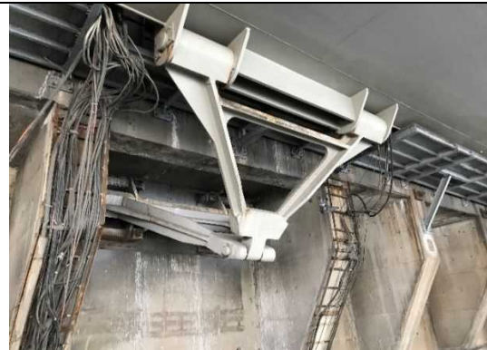
移動制限装置（橋軸方向）
