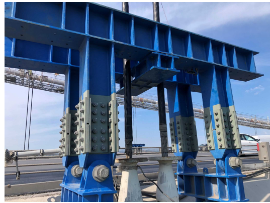
同左（仮ハンガー・ジャッキ用架台）
