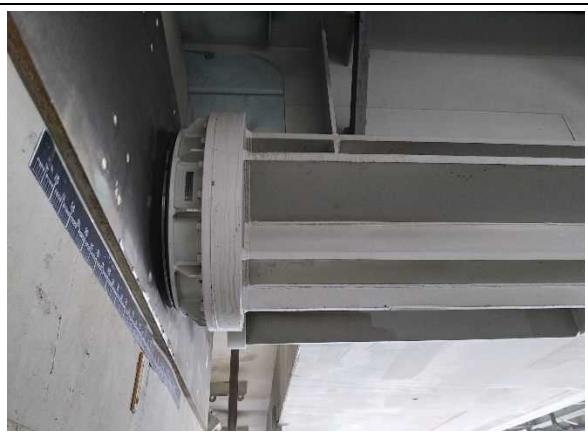
固定装置（橋軸直角方向）
