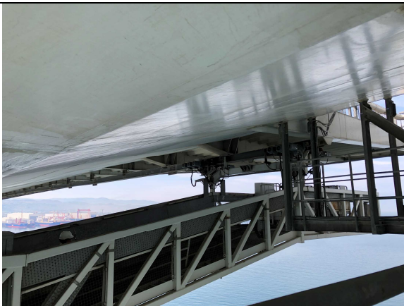
移動式桁下検査足場
