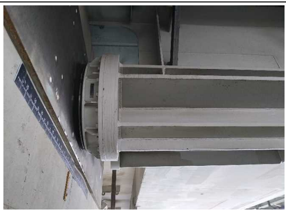
固定装置（橋軸直角方向）
