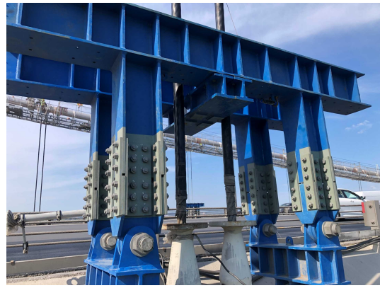
同左（仮ハンガー・ジャッキ用架台）
