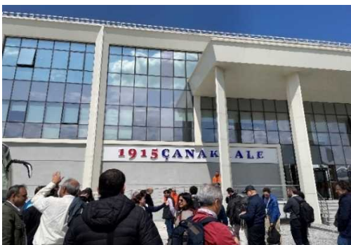
コントロールセンター
