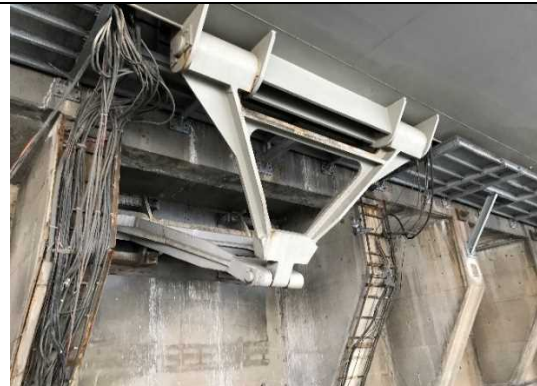
移動制限装置（橋軸方向）
