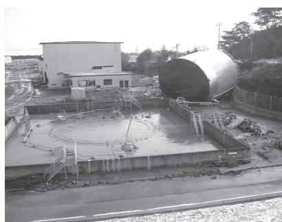
(a) 1号機重油タンク 暖房等の燃料となる重油を貯蔵している1号機重油タンクは、O.P.+3.5m盤に設置されていたため、津波により浮き上がり転倒した
