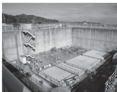
(c) 2号機海水ポンプ室(除塵機エリア) 地中ピット構造の海水ポンプ室には、軽微なひび割れが発生した程度だった
