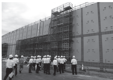
(a) 建設中の防波壁 T.P.+18mの高さで設計されている。基礎は深さ10～30mに到達しており、岩盤部に根入れされている
