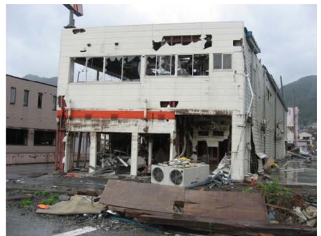
写真-⑥ 津波による建物被害
