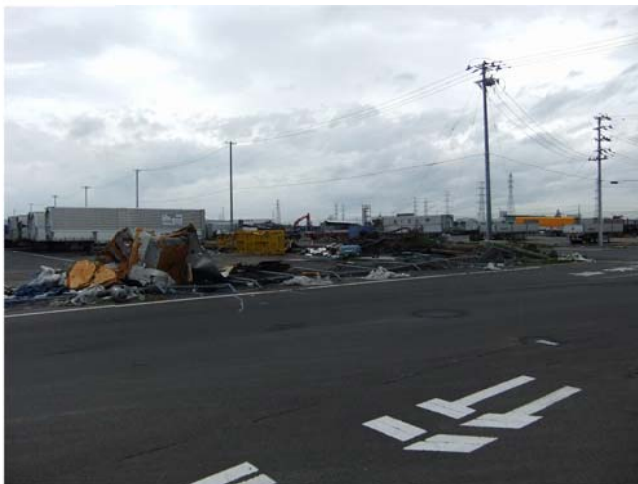
写真-① 津波で転倒したフェンスと漂流物
