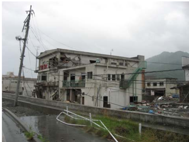
写真-⑤ 建物被害（ビル 3 階 まで津波が到達）
