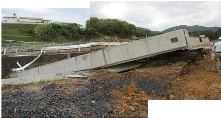
⑦RC 床版橋（平面道路の河川橋）近影
