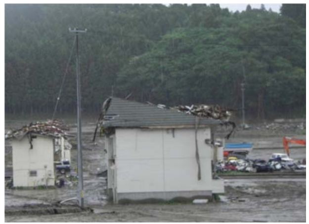
⑨-2 内陸部の家屋 屋根に瓦礫が堆積
