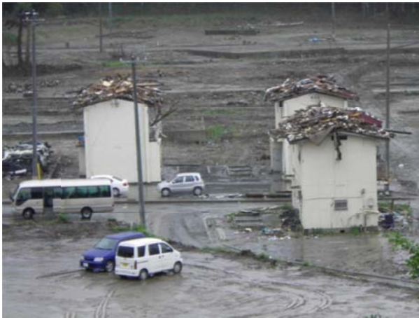
⑨-1 内陸部の家屋 屋根に瓦礫が堆積
