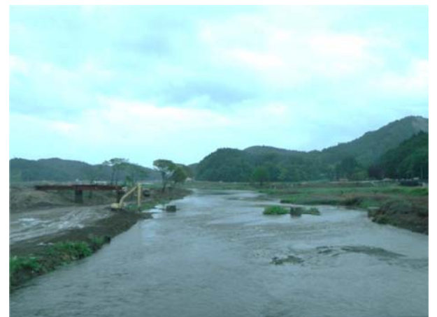
⑩-2 廻館橋下流の鉄道橋の落橋
