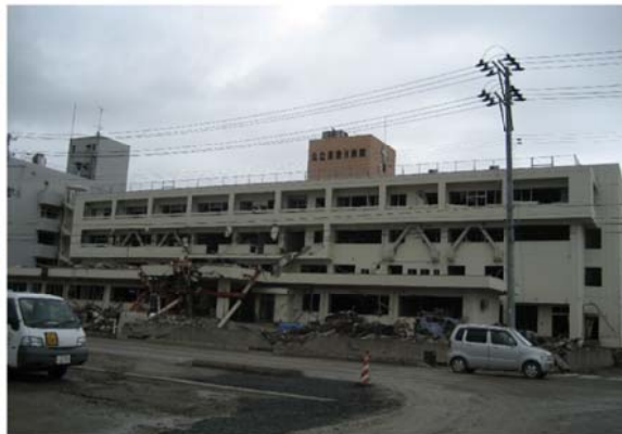
④志津川病院（4階まで津波が遡上？）
