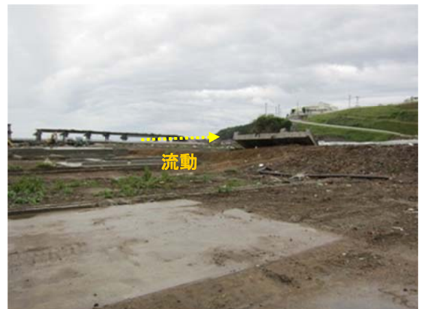
⑥RC 床版橋（平面道路の河川橋）の流動
