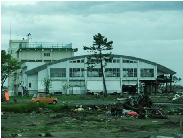
写真-⑦ 荒浜小学校体育館の1階部分が大破
