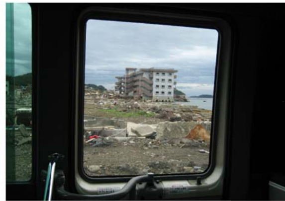
⑧沿岸部のマンションが沈下（地盤沈下）
