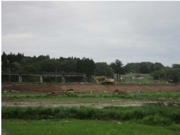
①気仙沼線の高架部の寸断
