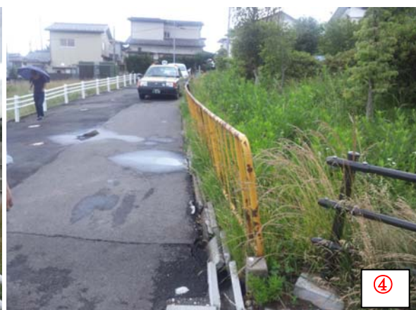
側溝が押しつぶされている。
