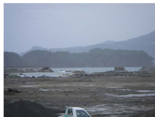
④-2 防波堤が洗掘により転倒・移動している
