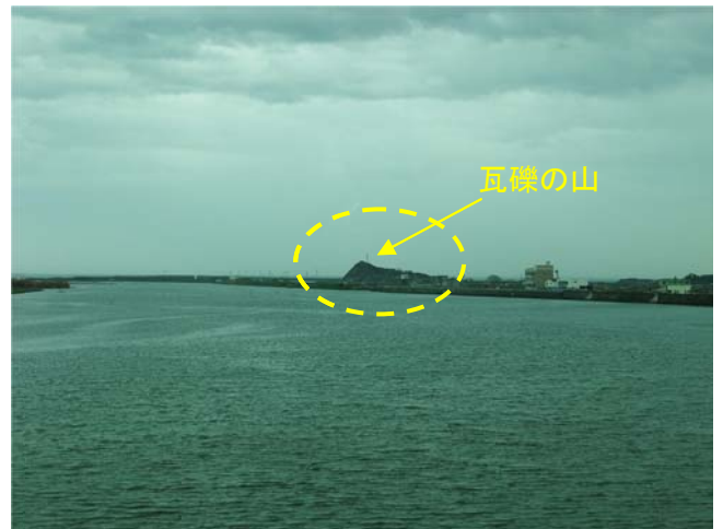
写真-⑩ 名取川下流右岸での瓦礫集積場
