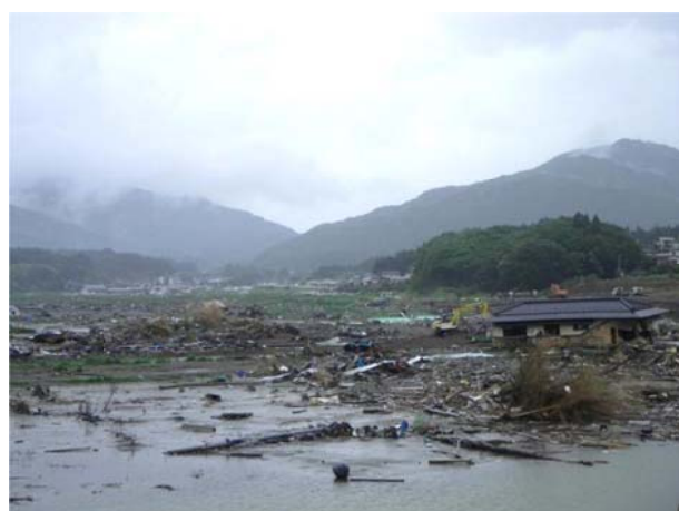
⑤ 津波による住宅被害と地盤沈下による滞水状況
