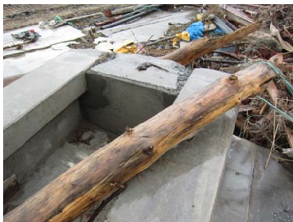
⑩PCT 桁(気仙沼線)の支承アンカーの切断
