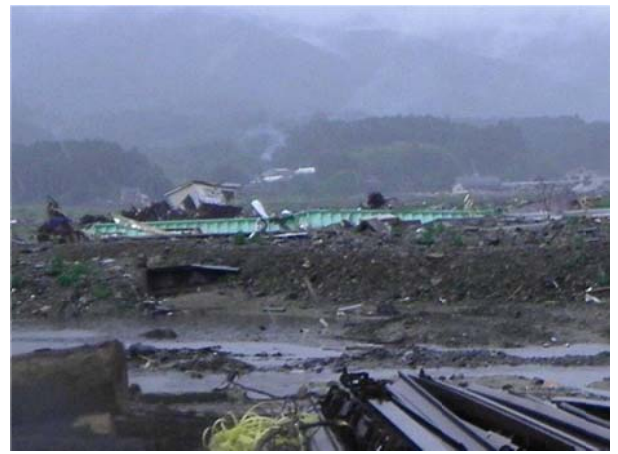
⑥-3 流された歩道橋の階段部
