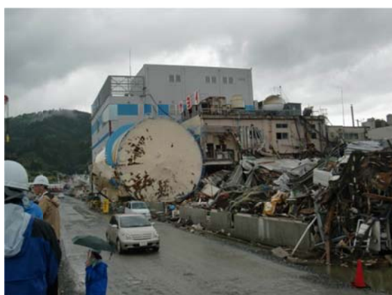
⑤ 流出した重油タンク
