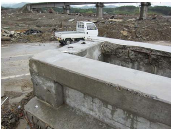
⑧PCT 桁(気仙沼線)の支承アンカーの切断
