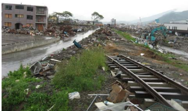
写真-⑪ 鉄道被害（ドラゴンレール大船渡）
