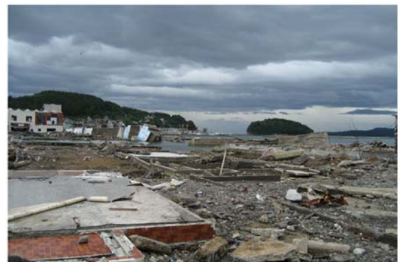
②防波堤の被害
