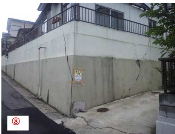
擁壁の損傷
