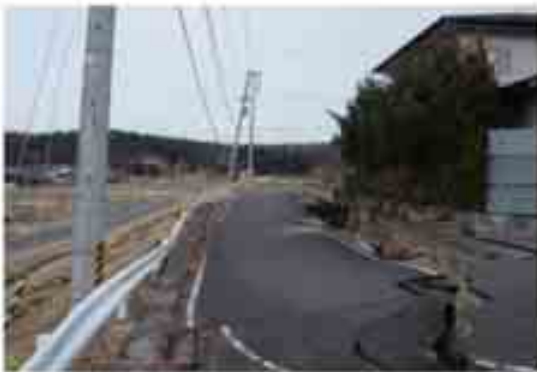
17 盛土天端の状況
