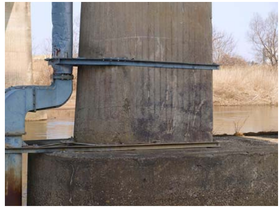
写真-36 橋脚基部の様子
