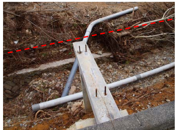
写真-30 下部構造の橋座付近
