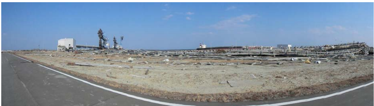
写真 78 揚炭埠頭からベルトコンベアーまでの全景（写真右側に相馬共同火力発電所が立地している）
