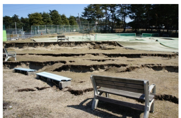
写真 26 テニスコートに生じた段差
