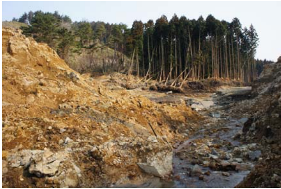
写真 91 決壊箇所から見た下流側
