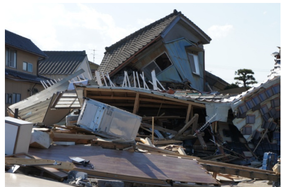
写真 42 護岸近くの全壊家屋
