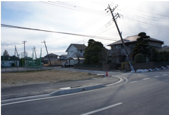
写真 13 町のいたる所で傾斜している電柱
