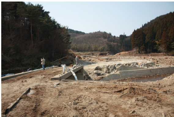
写真 95 奥から手前に決壊した泥流が押し寄せた
