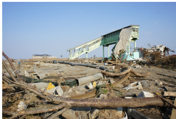
写真 82 階段が崩れた新地駅の跨線橋
