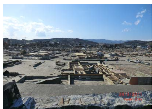
写真 40 護岸近くの流失家屋跡
