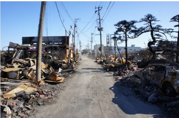
写真 37 津波後火災現場(1)
