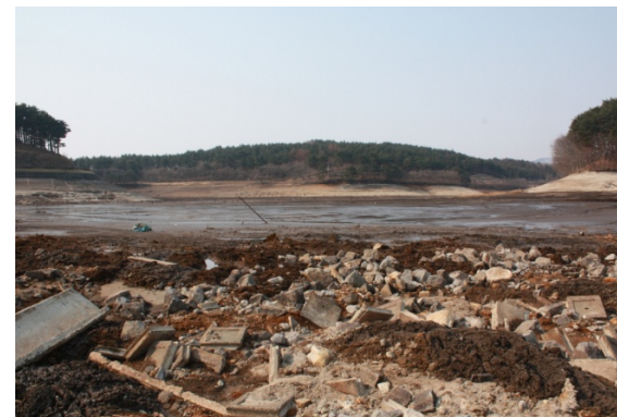
写真 90 決壊場所から見たため池
