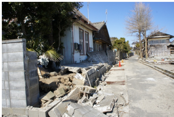
写真 34 津波に押し倒されたブロック塀
