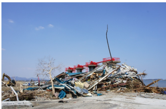
写真 56 漂流物が引っ掛かった松川浦の水門
