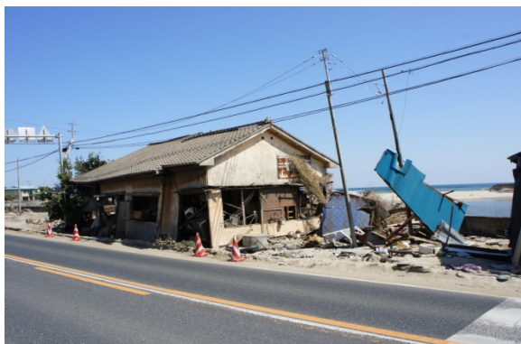
写真 29 国道 245 号線沿いの護岸近くの民家
