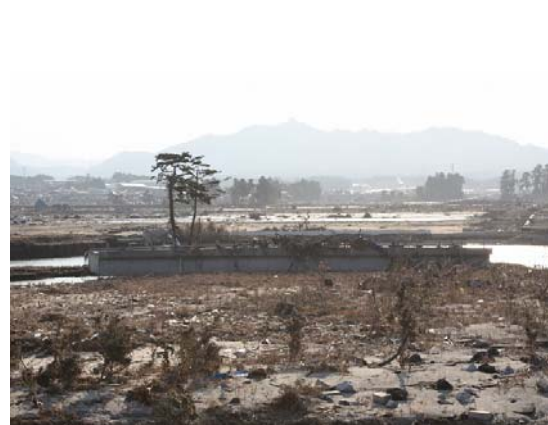
写真 73 流出した橋桁
