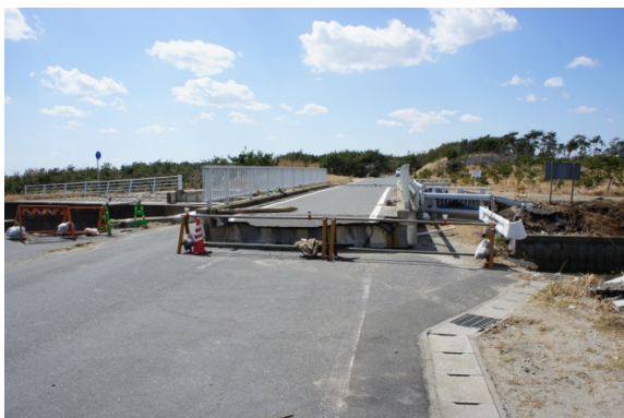
写真9 下流海岸側(左)の橋が隣接道路橋の上に移動
