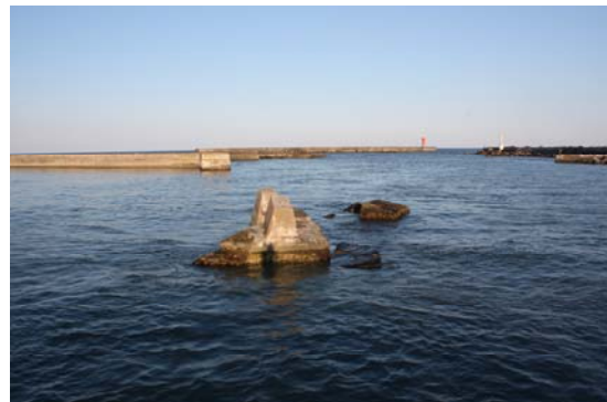
写真 47 約 180m 流されたケーソン
