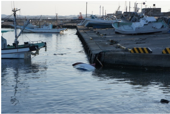
写真 48 打ち上げられたり沈没したりした漁船 (1)
