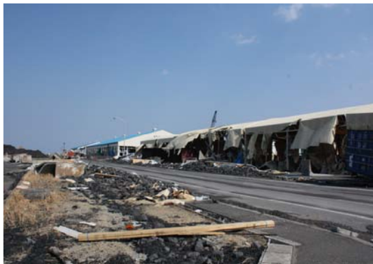
写真 68 埠頭倉庫群の被害
