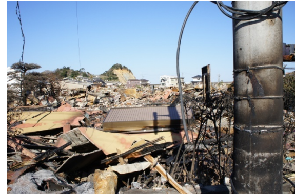
写真 38 津波後火災現場(2)
