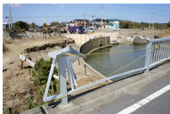
写真10 水路を遡上した津波が橋・護岸・民家を破壊
