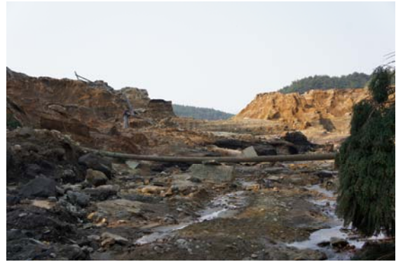
写真 92 下流側から見た決壊場所
