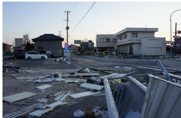
写真 51 国道 6 号線沿線の家屋被害
