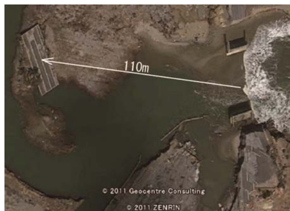
写真 88 元の位置から 110m 運ばれた橋桁
