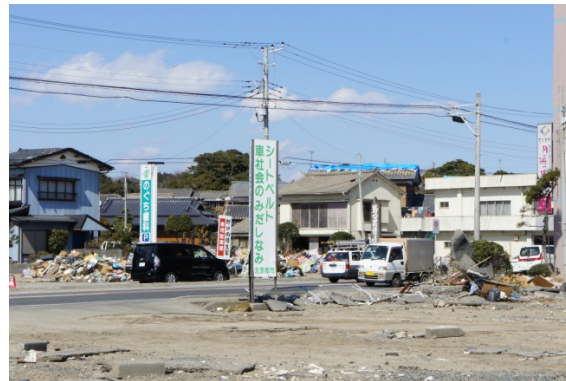
写真 30 国道 245 号線を挟んだ両側の津波被害
