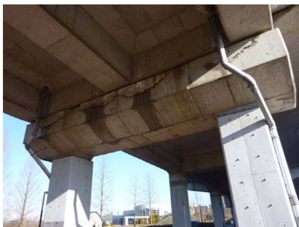
図 2 桁受部損傷
