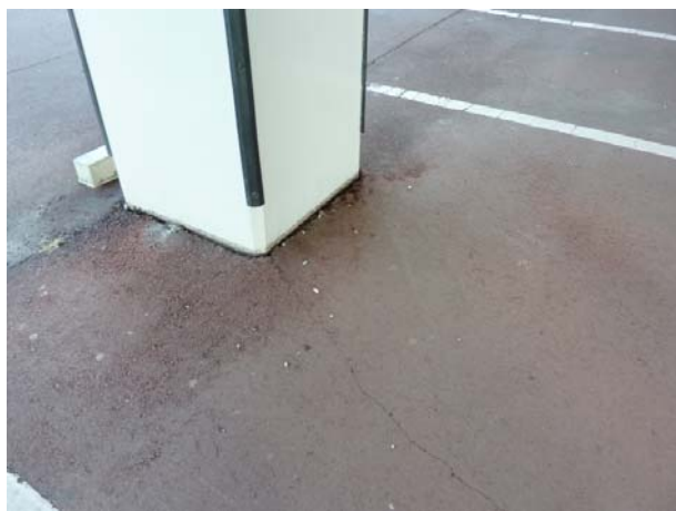
図 3.2 ラーメン高架橋基部
