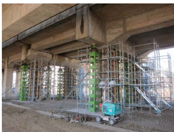
図 2 応急復旧の様子
