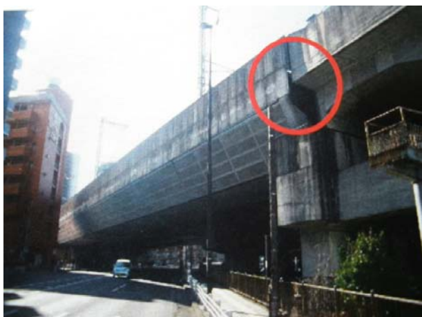
図 1 橋梁全景（JR 東日本撮影）
