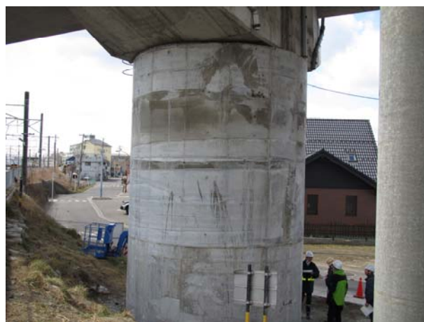
図 2 岩切高架橋 補修後
