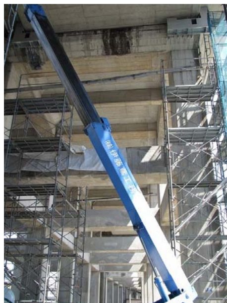
図 2 補修後の状況および横ずれストッパーの設置
