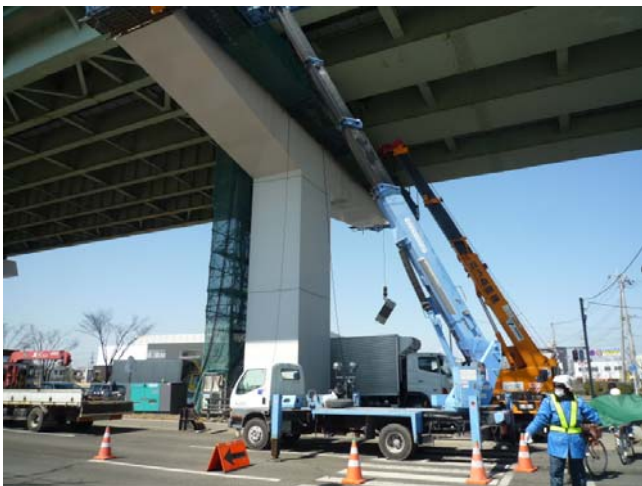
図7 復旧作業① (P52 橋脚)
