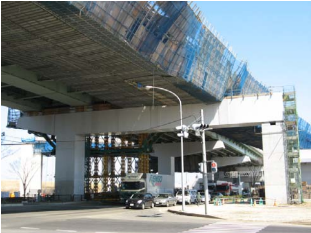
図10 P56橋脚の外観
