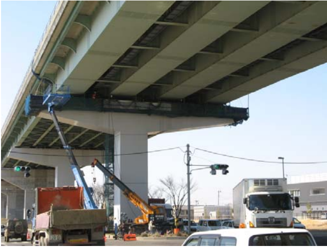
図3 P52 橋脚の外観
