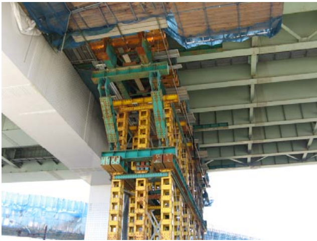
図 16 復旧作業② (P56 橋脚)
