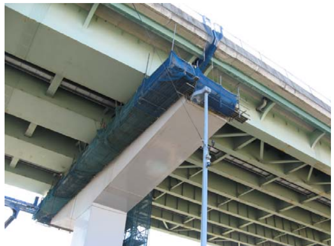
図8 復旧作業② (P52 橋脚)
