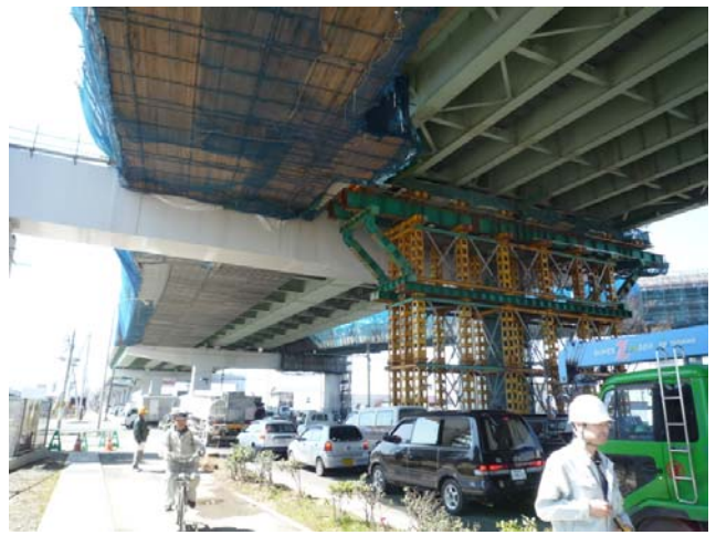
図 15 復旧作業① (P56 橋脚)
