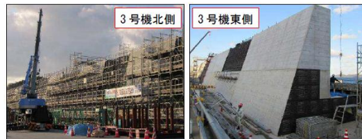
3号機北側 3号機東側 3号機エリアの防波壁工事状況
