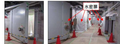
建物外壁への水密扉設置工事状況
