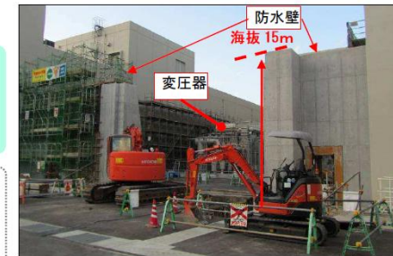
変圧器設置エリアへの防水壁設置工事状況
