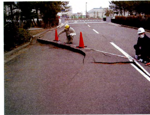
TB北側(路面のひび割れ、沈下)
