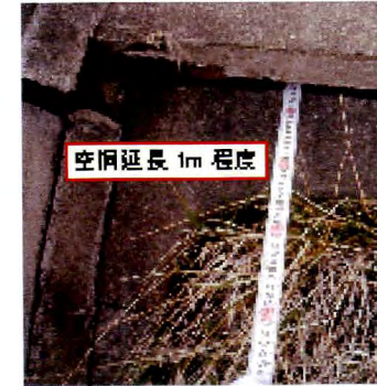
協力会社駐車場南側 (路面の沈下(沈下量20cm)、ひび割れ)
