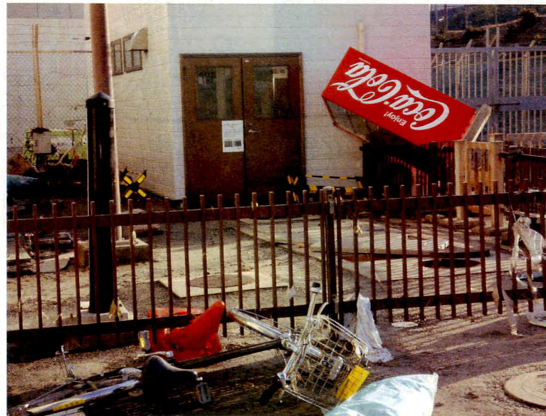
メンテナンスセンター（S造）自動販売機転倒
