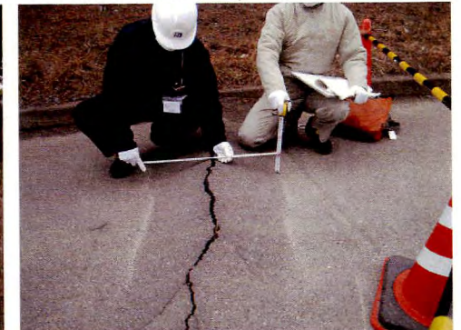
協力会社駐車場南側 (路面の沈下(沈下量20cm)、ひび割れ)
