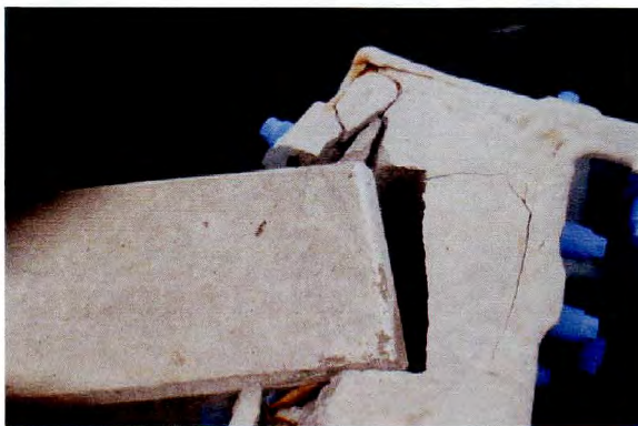
写真③ 躯体変形(カーテンウォール端部)
