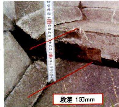
ドライキャスク背後斜面(法枠の段差、き裂)
