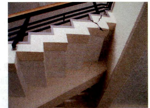
旧PR館(エキスパンション部)、内部階段の割れ(一般建物)
