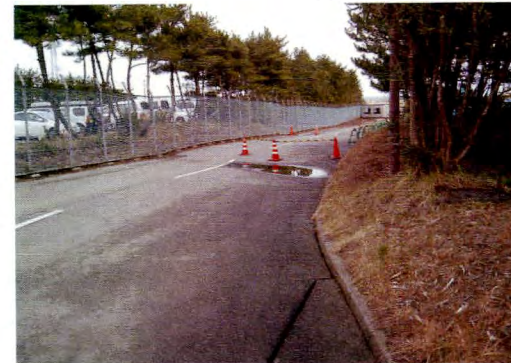
協力会社駐車場南側 (路面の沈下(沈下量20cm)、ひび割れ)
