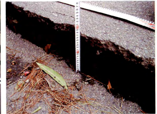
TB北側(路面のひび割れ、沈下)
