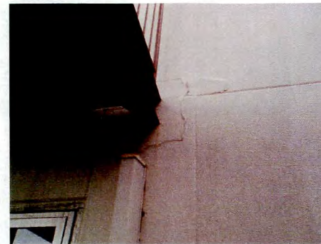
協力会B棟外部階段接続部コンクリートの割れ(一般建物)
