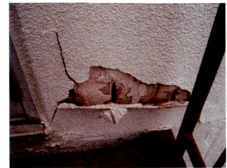
協力会B棟外部階段接続部コンクリートの割れ(一般建物)
