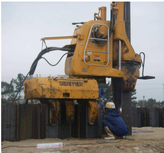
圧入装置(100~150トン級): 引拔を交え周面摩擦を切りながら圧入, 最初の3枚だけは振動利用で打設
