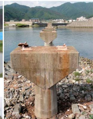
図 3.40 鋼桁の流失
