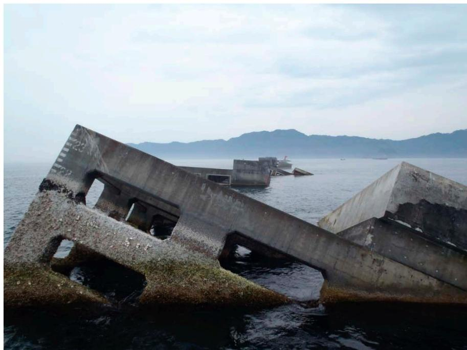
写真 1.3 釜石湾口防波堤が津波により破壊された様子 (2011年6月20日撮影)
