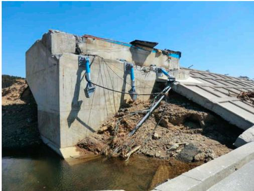
図 3.26 鋼桁の落橋防止装置
