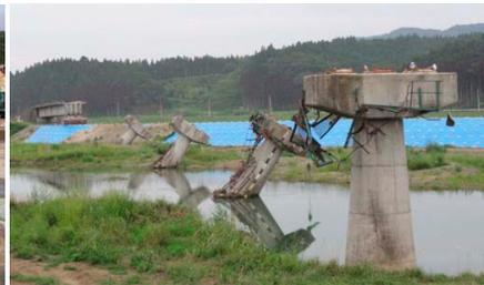
図 3.41 PC 桁の流失 (気仙沼線津谷川橋梁)
