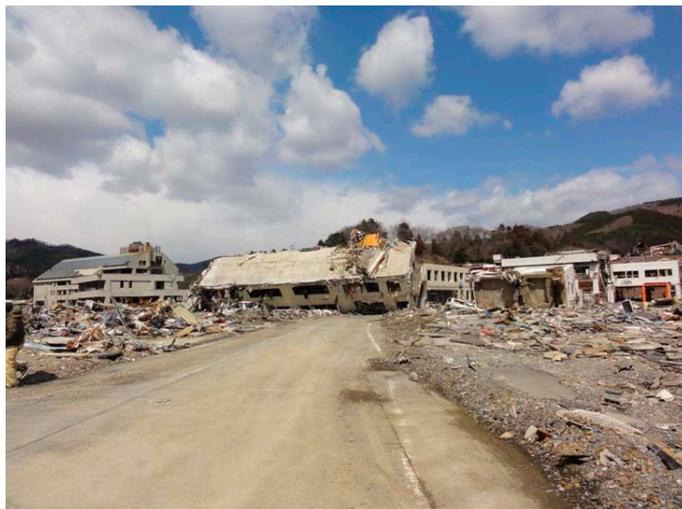
写真 1.6 3階建ておよび2階建て鉄筋コンクリート建物の被害 (2011年3月27日撮影)
