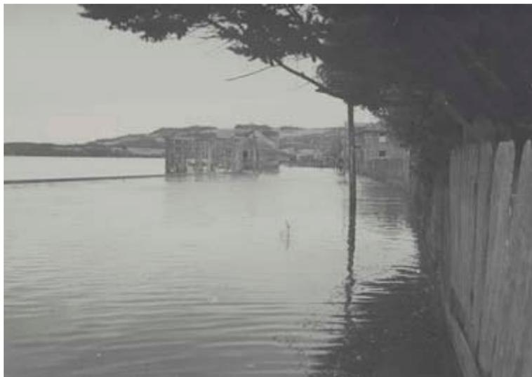
**図 3.7** チロエ島（Isla Chiloe）東海岸のケション（Quellon）の海岸通（写真：Pierre St. Amand, National Geophysical Data Center, NOAA）<sup>14)</sup>：写真にある半ば取り壊された建物は市役所庁舎である。チロエ島のこの付近は2mほど沈降したとされる。
