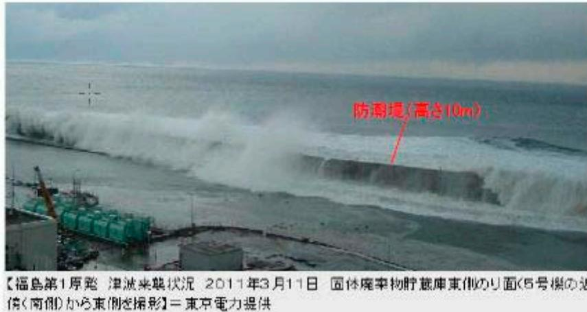
図 3.22 福島第一原子力発電所の防波堤を越流する津波の状況<sup>35)</sup>
