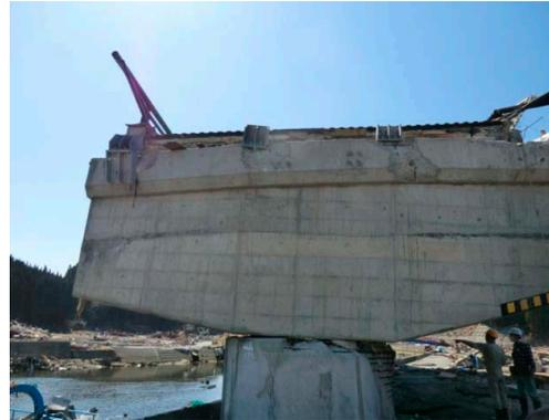
図 3.27 PC 桁の落橋防止装置
