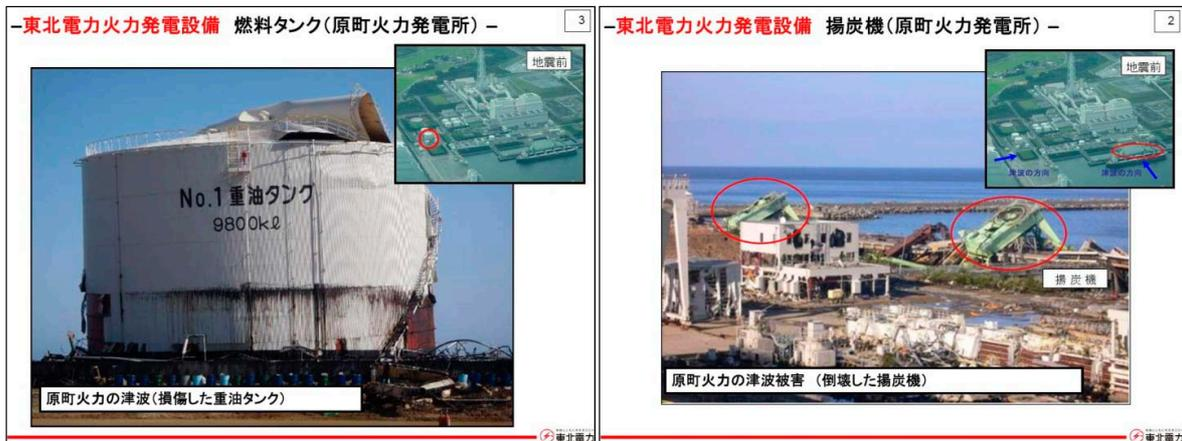
図 3.19 津波による重油タンクの損壊<sup>32)</sup>
