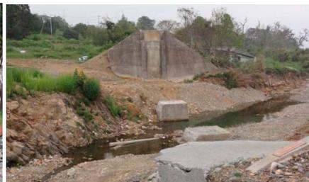
図 3.42 無筋コンクリート橋脚の流失
