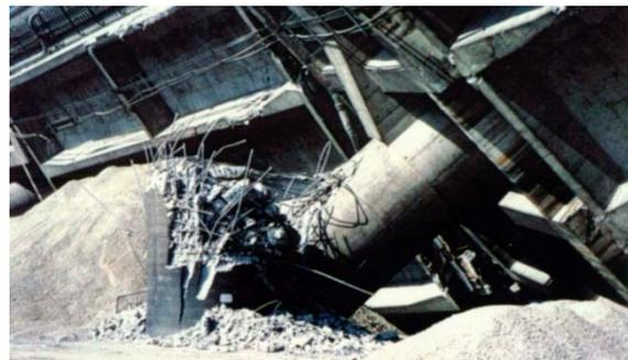
図 3.24 コンクリート橋脚のせん断破壊 (by K. Maruyama)
