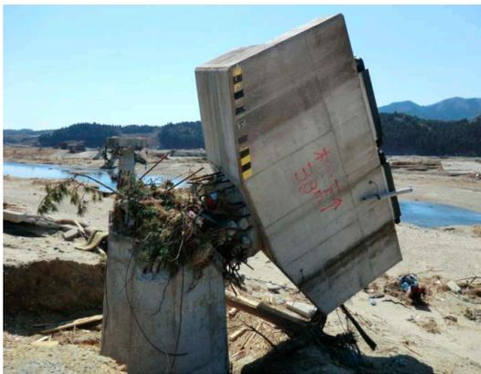
図 3.28 橋脚頭部の破壊
