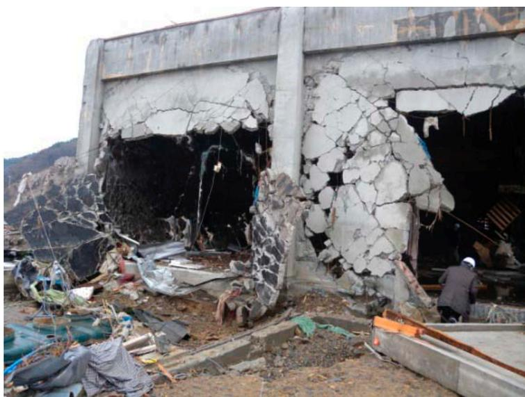
写真 1.5 コンクリート壁の被害 (2011年4月9日撮影)
