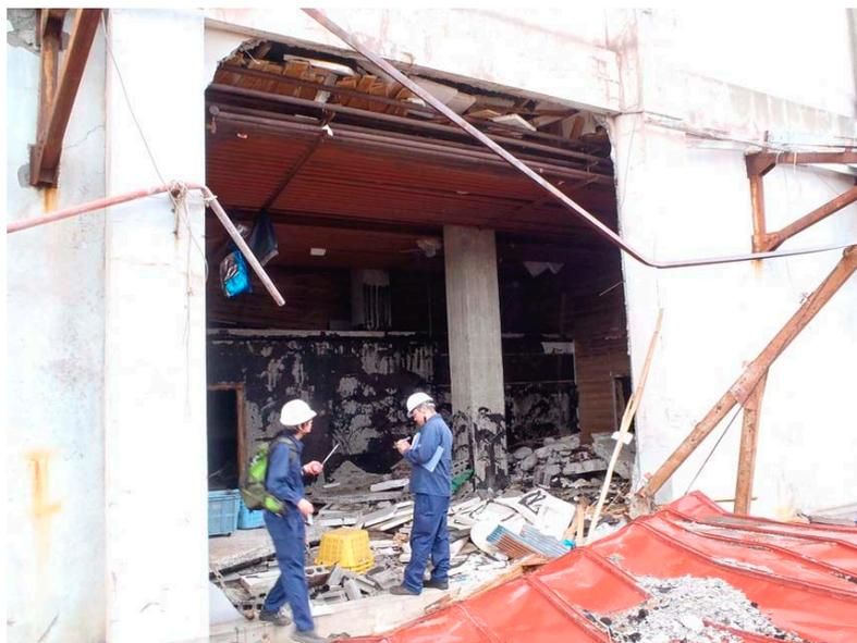
写真 1.4 冷凍工場でコンクリート壁が抜けた様子 (2011年6月21日撮影)
