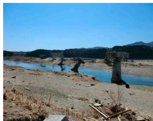
図 3.29 橋脚の傾倒
