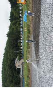
Step2: 固化剤を農地に吹き付け
