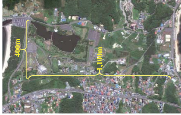
震災前の仮置場
