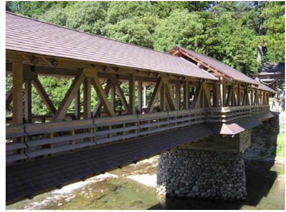
写真-3 御幸橋（高知県）
