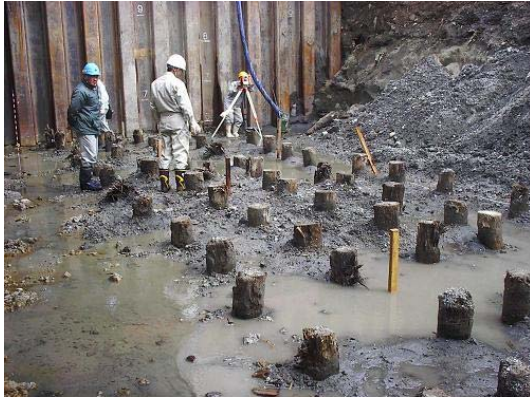
写真-10 福井県足羽川に架かる旧幸橋の橋脚の74年前に打設された木杭基礎
