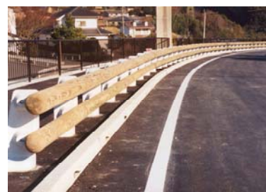
写真-8 国道の木製防護柵
