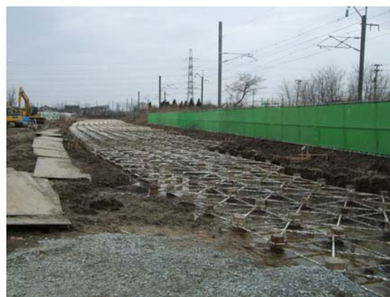
写真-6 パイルネット工法
