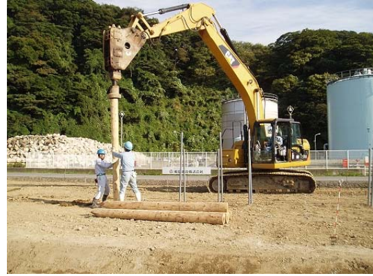
写真-11 地中カーボンストック技術によるCO 2 削減効果の確認試験
