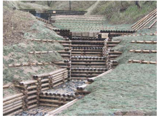
写真-5 木製ダムと流路工 (京都府)
