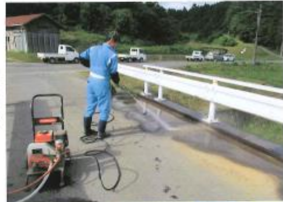
橋面高圧洗浄
