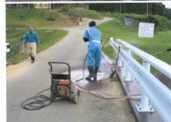
橋面高圧洗浄
