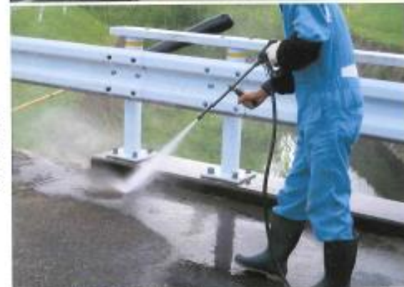
橋面高圧洗浄
