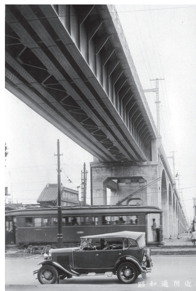
写真1 昭南通架道橋(鐵道省(1932年)『御茶ノ水兩國間高架線建設概要』より抜粋)
