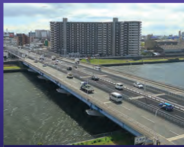
11号池田線 大豊橋付近
