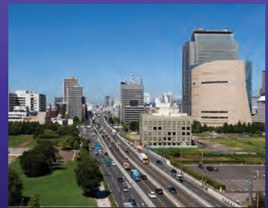
13号東大阪線 法円坂付近
