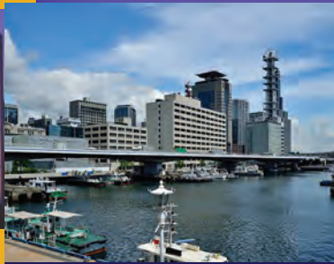
3号神戸線 京橋付近
