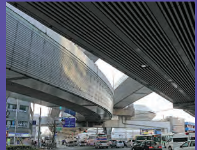
15号堺線 湊町付近
