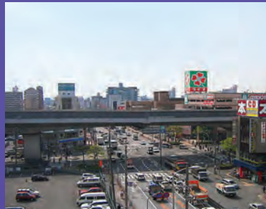
14号松原線 喜連瓜破付近
