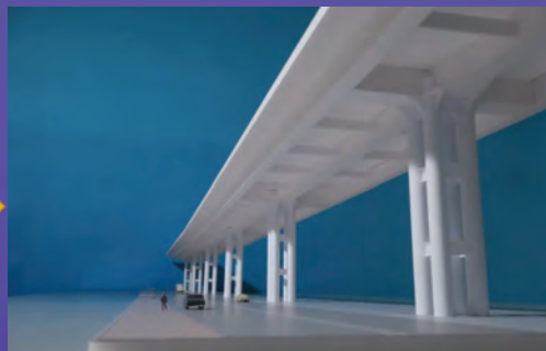
鋼管集成橋脚
