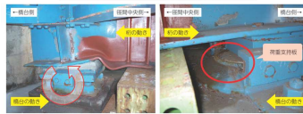
図2-1-2 地震動による下フランジの変形および支保の損傷
