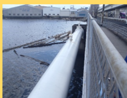
歩道部からの調査
