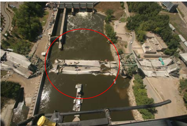
事故現場の状況(2007年8月2日) (出典:MN・DOT)
