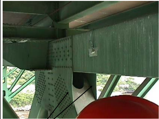
ガセットプレートの変形: 局部の変形が全体の強度に関係
