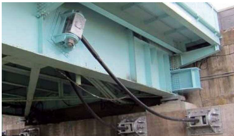
写真 2.6 落橋防止装置
