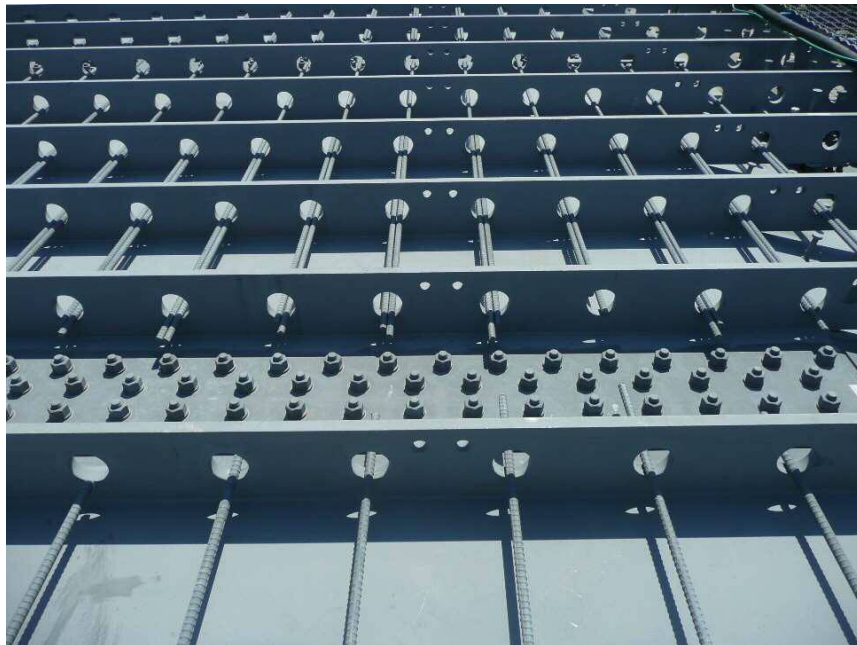
写真 2.2 合成床版の孔明き鋼板ジベルの例
