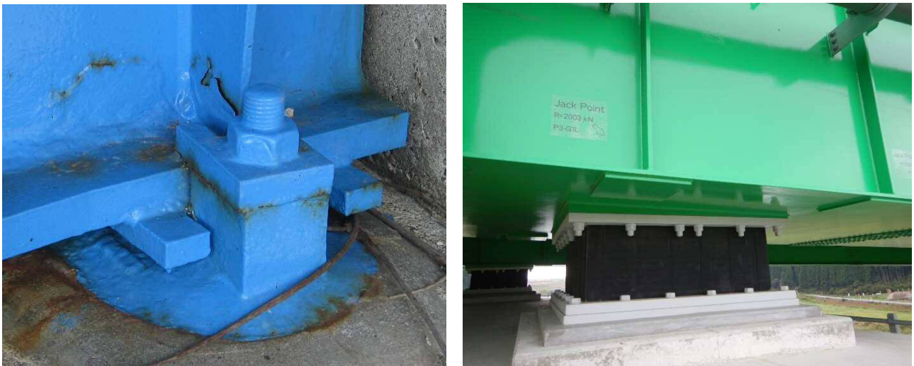
写真 2.5 鋼製支承(左)とゴム支承(右)の例
