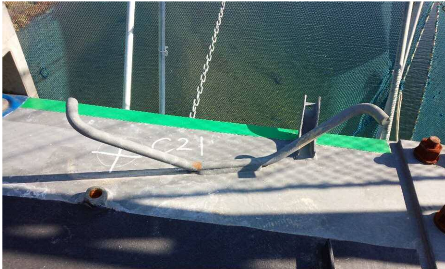
写真 2.3 非合成桁のスラブアンカーの例
