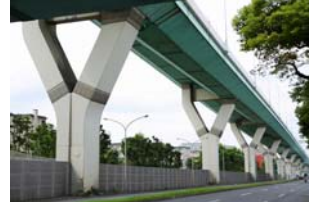
2径間連続立体ラーメン橋
