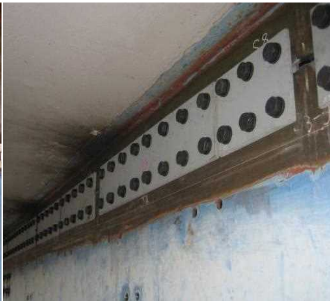
主桁ウェブ仮添接状況
