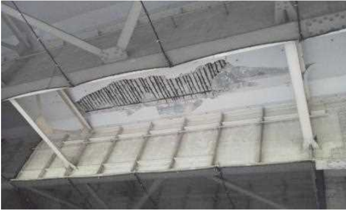
コンクリート塗装の剥離 (NEXCO規準不適合材料)
