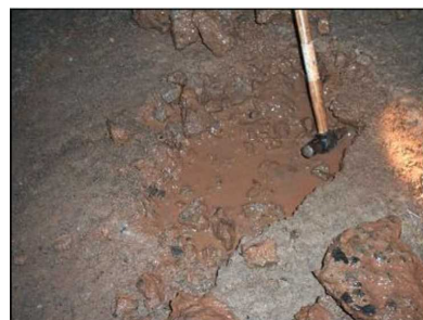
既設床版の土砂化
