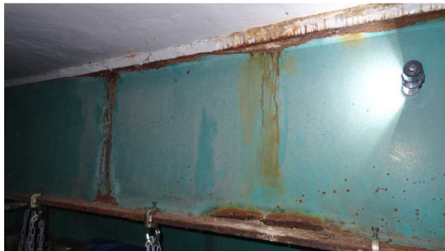
床版ひび割れ部からの漏水 による腐食（補強桁）
