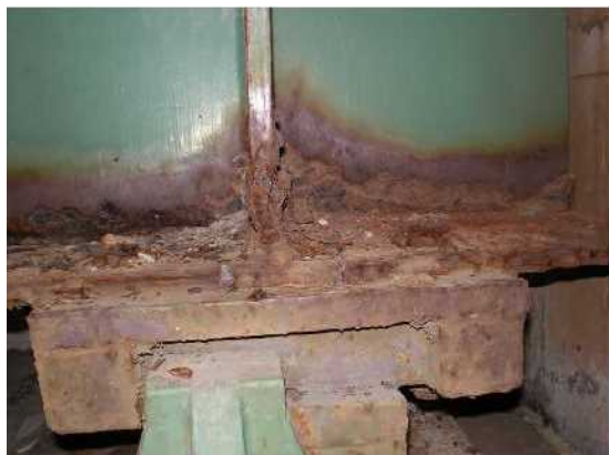
桁端部からの漏水による腐食 (主桁端部)
