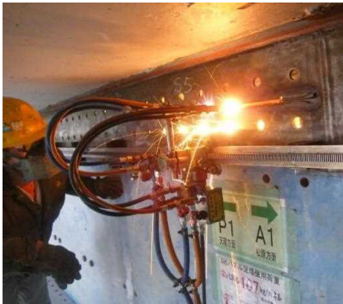
主桁ウェブ切断状況
