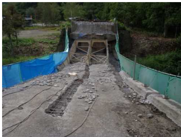
写真3：合成桁の撤去中の落橋事故事例 14) 写真4：合成桁の撤去中の落橋事故事例 25)
