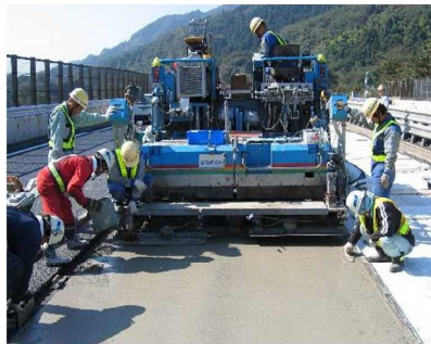
床版増厚補強
