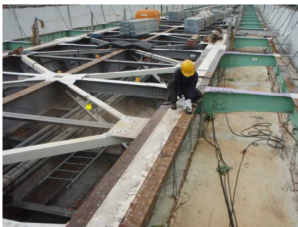
写真2：上フランジのけれん作業状況
