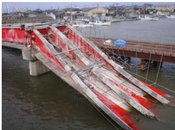
写真3：合成桁の撤去中の落橋事故事例 14) 写真4：合成桁の撤去中の落橋事故事例 25)
