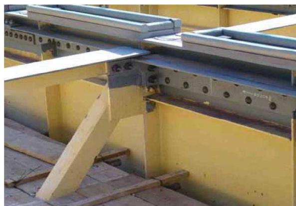
写真5：上フランジの取付部材の接続状況
