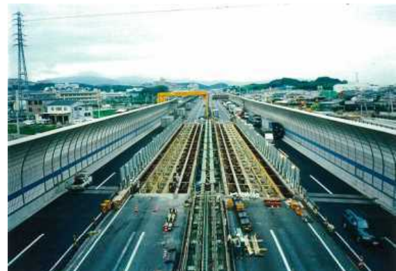
鋼道路橋のRC床版更新 ～現状と今後の展望～
