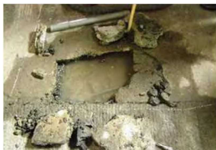
増し厚床版の変状
