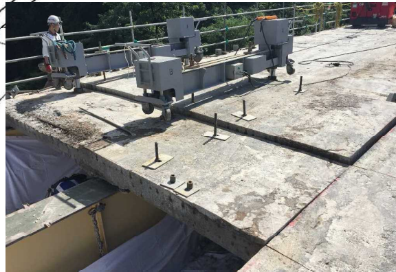
令和元年度全国大会 研究討論会 鋼道路橋のRC床版更新 ～現状と今後の展望～
