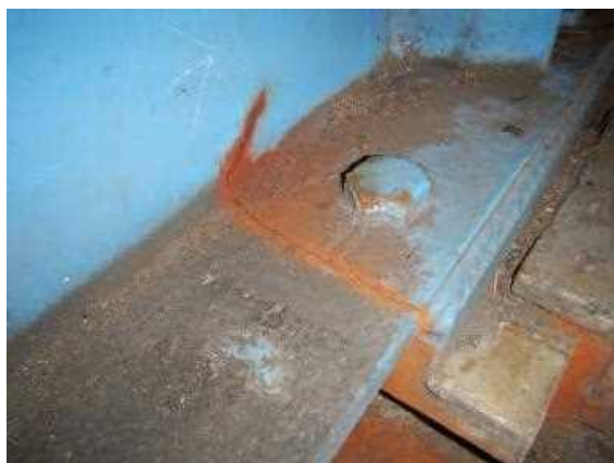
ソールプレート溶接部
