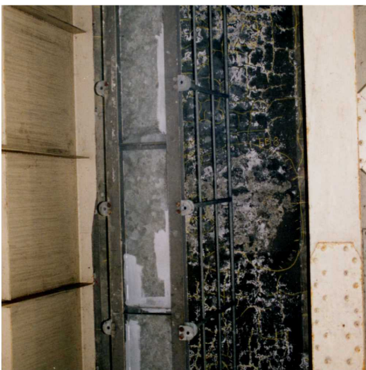
下面のひび割れ、エフロ
