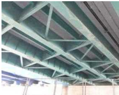
縦桁補強
