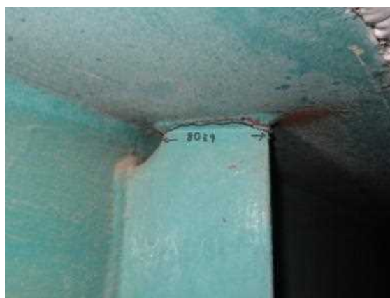
垂直補剛材上端溶接部
