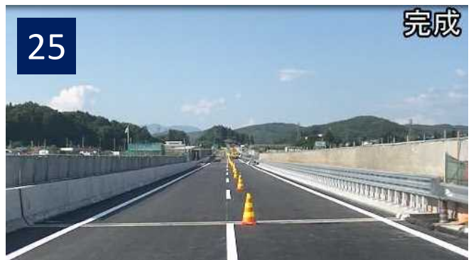
鋼道路橋のRC床版更新 ～現状と今後の展望～
