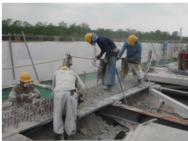
写真1：ずれ止め周りのコンクリートの撤去状況
