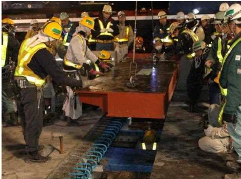
令和元年度全国大会 研究討論会 鋼道路橋のRC床版更新 ～現状と今後の展望～
