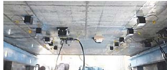
写真-2 床版下面のセンサ設置状況
