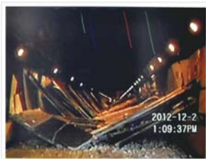
東京都の建設した笹子トンネル、コンクリート製の天井板が半壊し崩落。12月2日深夜、約1kmのトンネル区間
