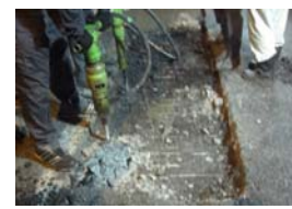
舗装を剥がして分かる、 RC床版上面の土砂化
