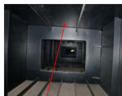
鋼箱桁上フランジはきれいだが その上(RC床版)の状況は不明
