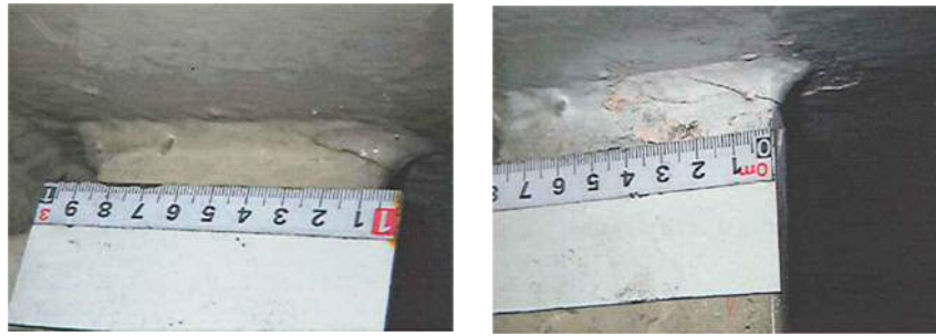
図－１ 塗膜割れ（左）と磁粉探傷試験で確認された疲労亀裂（右）
