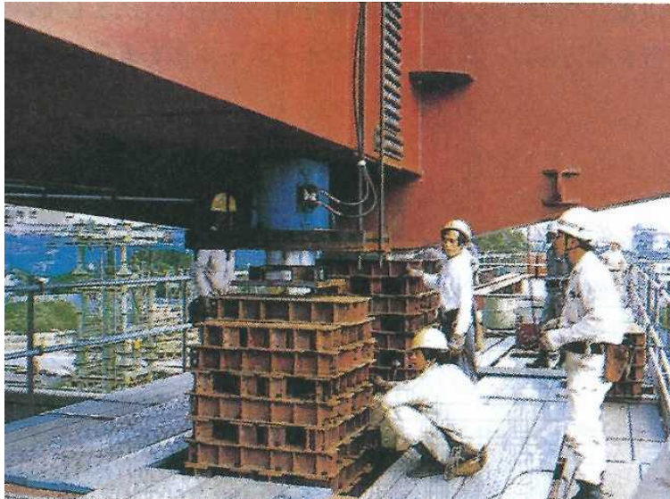
写真7.8.1 油圧ジャッキ(降下)
