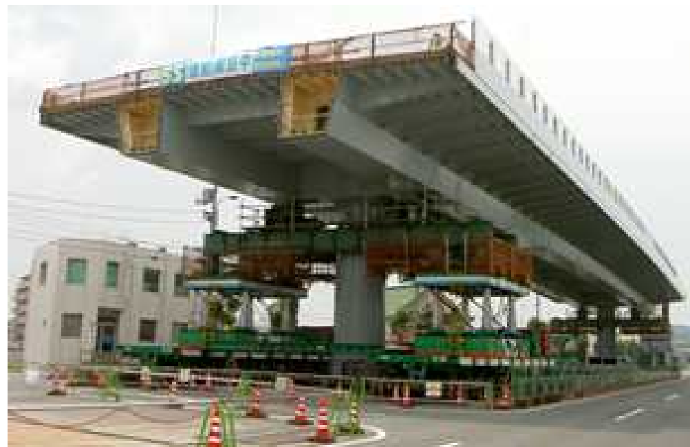
写真7.7.2 大型搬送車と降下用ジャッキの施工例
