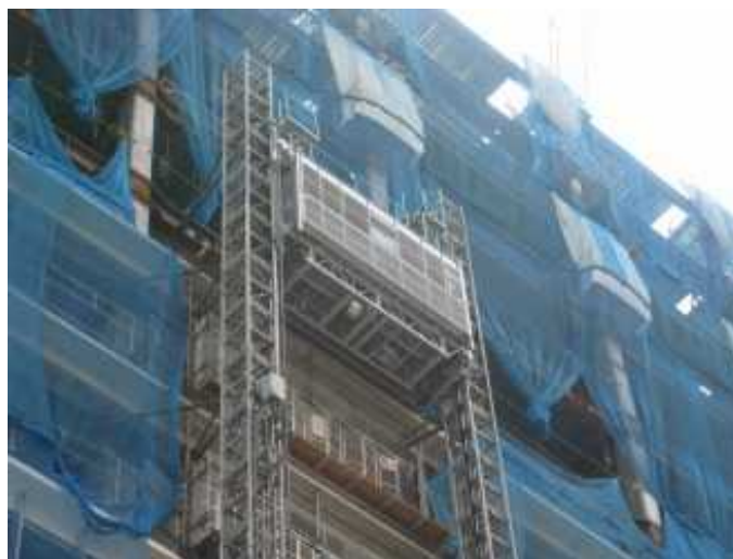
写真 7.11.4 建設用リフト
