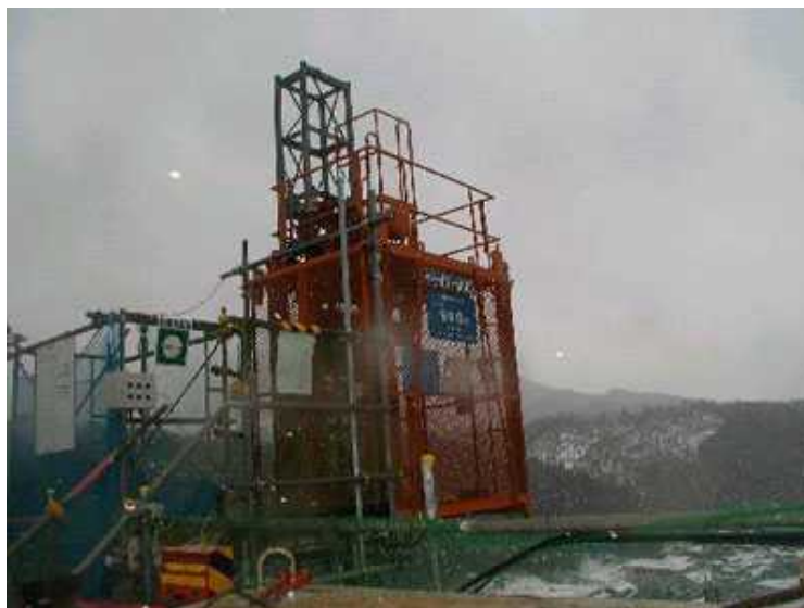
写真 7.11.3 工事用エレベーター
