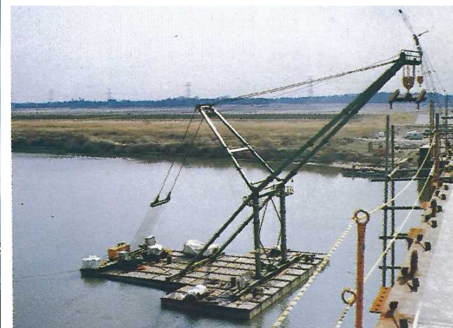
写真 7.4.4 組立て式起重機船
