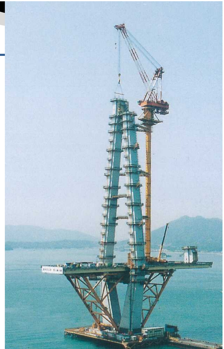
写真 7.3.6 タワークレーン (クライミングクレーン)
