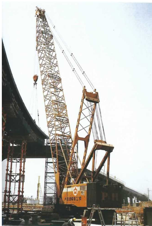
写真7.3.17 移動式クレーン
