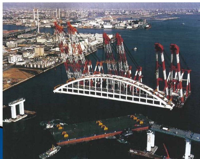
写真7.4.5 起重機船3隻による相吊り
