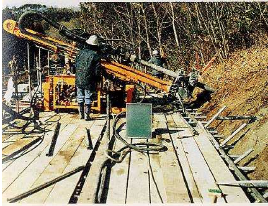
写真5.2.1 グラウンドアンカー施工状況
