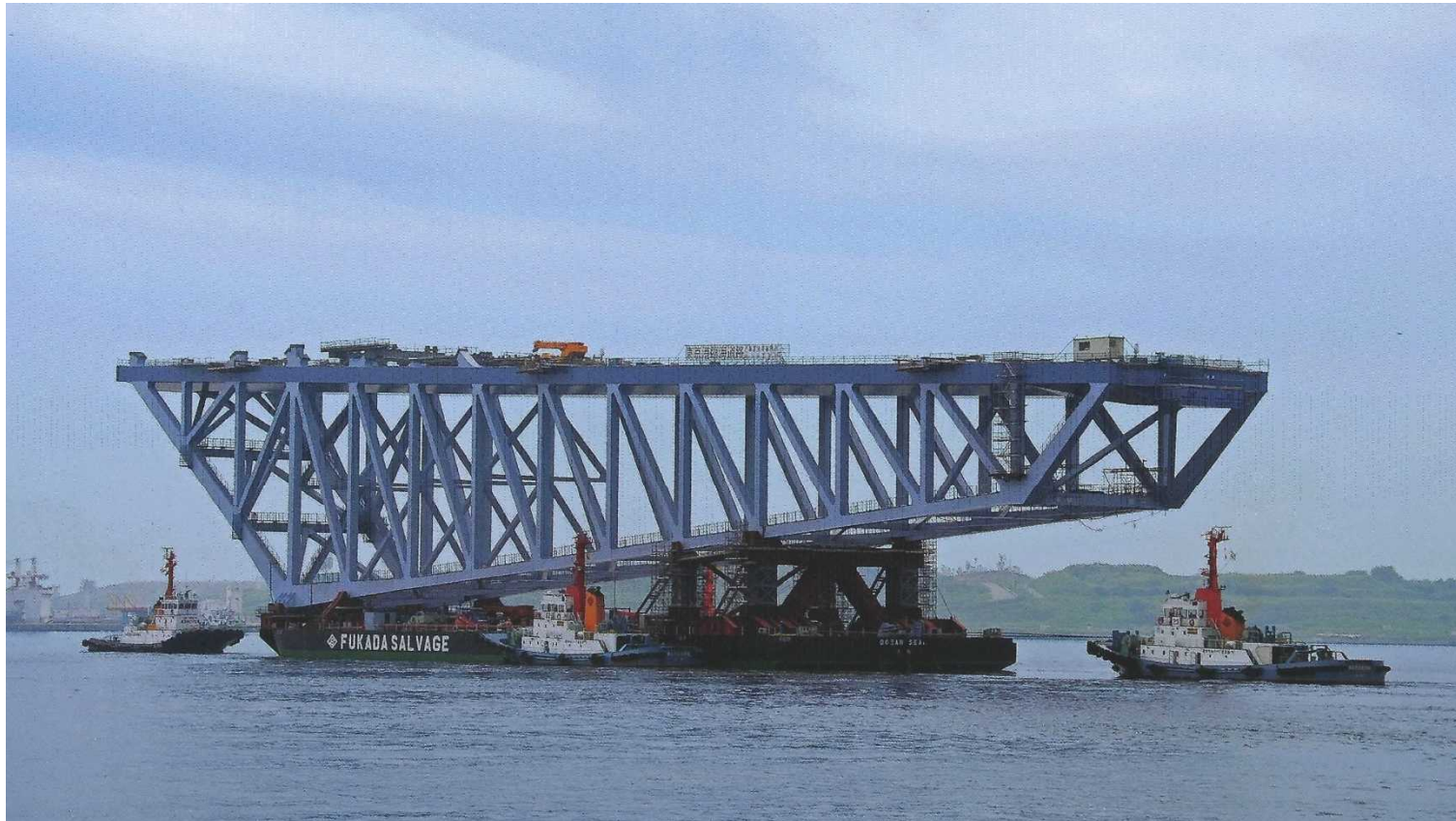
写真 7.5.1 オーバーハングさせた台船の搭載
