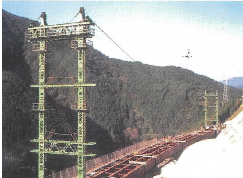
写真7.3.9 ケーブルクレーン全景
