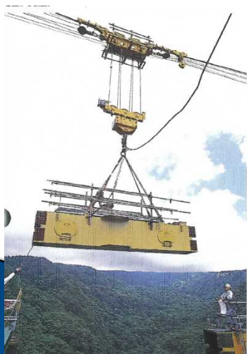
写真7.3.10 部材運搬状況
