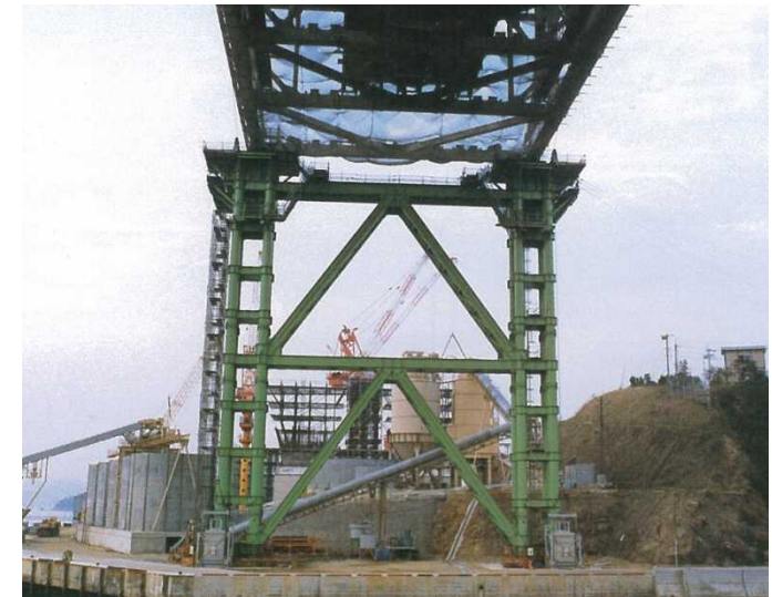
写真 7.12.3 大型ベントの使用例
