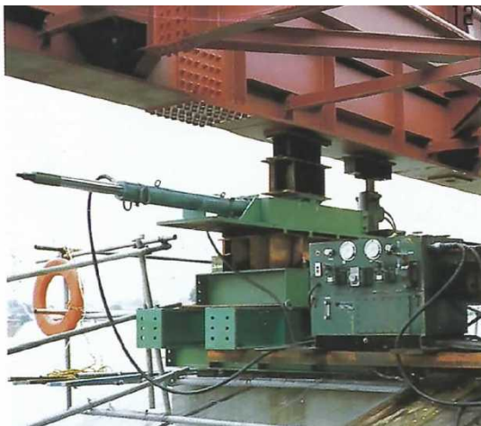
写真7.9.1 水平送出し装置
