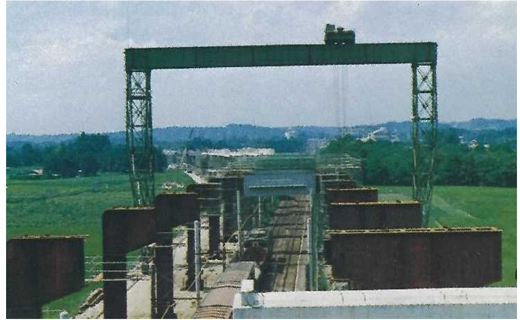
写真7.3.8 橋形クレーン(ウインチ搭載型)
