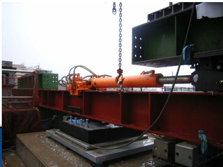
写真7.8.3 油圧ジャッキ(横取り)
