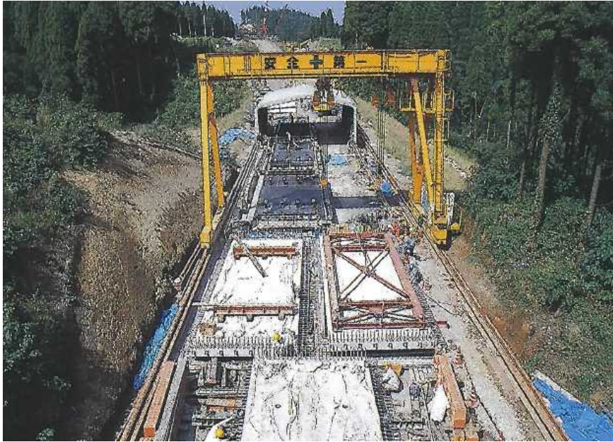
写真7.3.7 橋形クレーン(吊下げ型)
