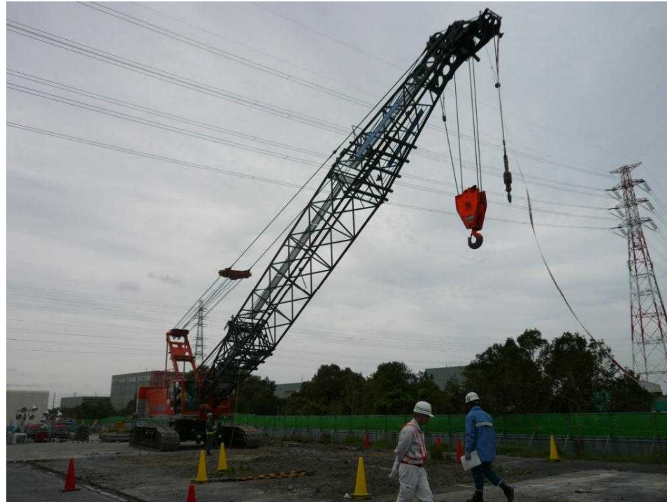
東京電力によるクレーンブーム長と作業範囲制限の確認例
