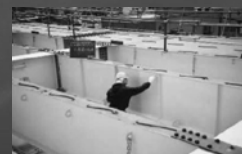
縦桁Web (施工中)
