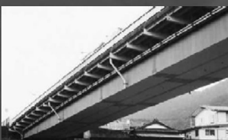
箱桁全景 (施工前)
