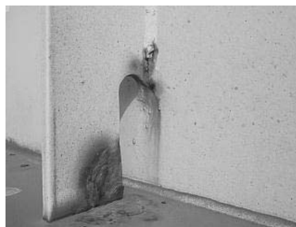
図1 局所的な塗膜劣化・腐食の例
