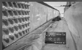
アーチ橋接写 (施工前)
