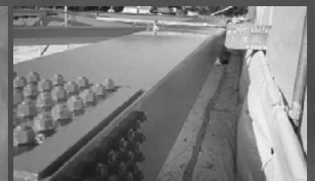
アーチ橋接写 (施工完了)
