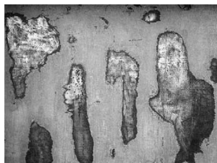
動力工具を用いて腐食箇所を除去した状態で鋼素地露出箇所にさびは残存していない。
