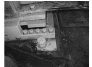
漏水した桁端部でのナイロン粉体支承部
