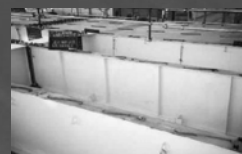
縦桁Web (施工前)
