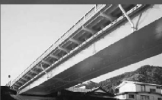
箱桁全景 (施工完了)
