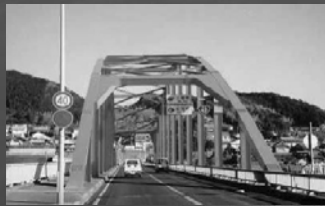
アーチ橋全景 (施工完了)
