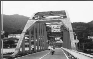
アーチ橋全景 (施工前)
