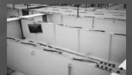
縦桁Web (施工完了)
