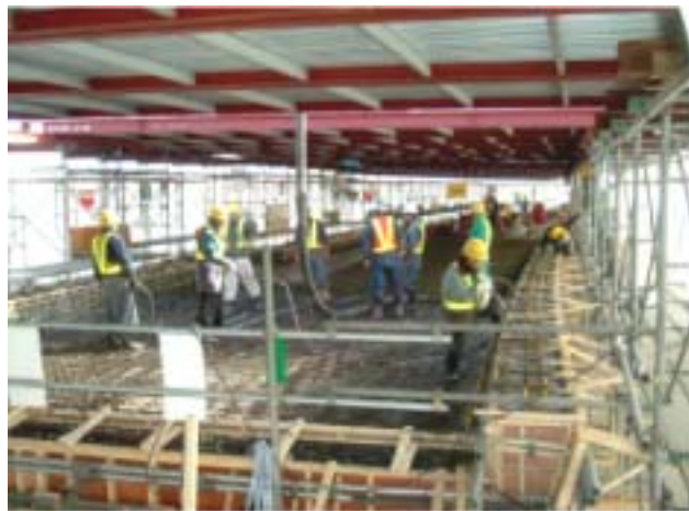
上屋内におけるコンクリート打設状況
