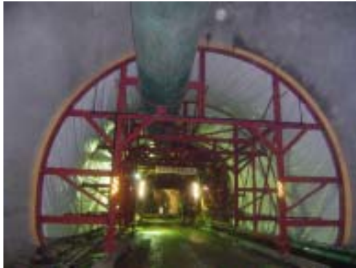
養生架台全景
