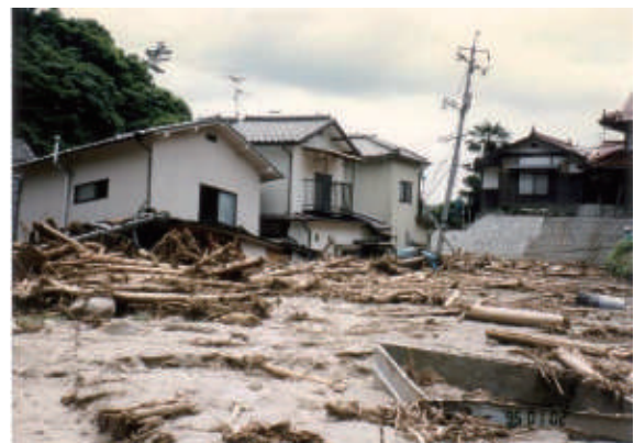
写真-3 溪流に架かる橋梁の流木による閉塞に伴う土石流の氾濫と人家の被害（1999年6月の広島災害における荒谷川）
