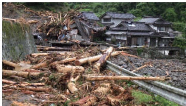
写真-7 福岡県東峰村岩屋地区における土石流および流木の衝突による家屋の被害 (2017年7月「九州北部豪雨」による災害)
