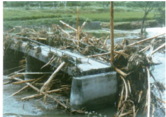
写真-1 流木の閉塞による橋梁の破壊（1986年7月、京都府笠置町、木津川左支川白砂川西奥橋）
