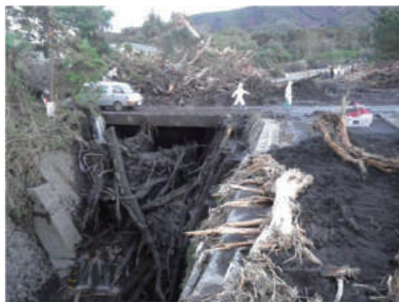
写真-6 伊豆大島大金沢における流木による橋梁の閉塞と土石流の氾濫 (2013年10月台風26号による災害)
