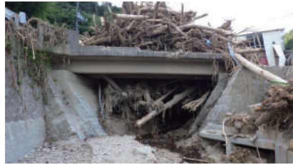
写真-8 広島県坂町総頭川における流木による橋梁の閉塞と土石流の氾濫(2018年7月豪雨)
