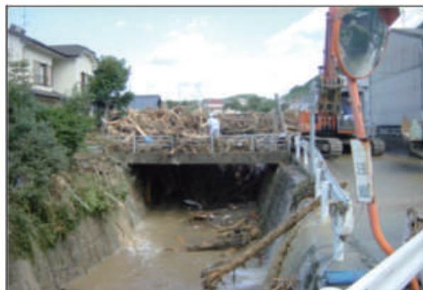
写真-5 愛媛県西条市長谷川における流木による橋梁の閉塞と周辺への洪水氾濫 (2004年9月台風21号による災害、愛媛県提供)
