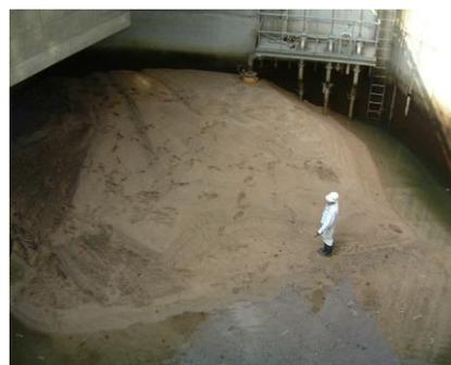
図-2 平成 16 年台風 23 号出水時の沈砂池内土砂流入状況
