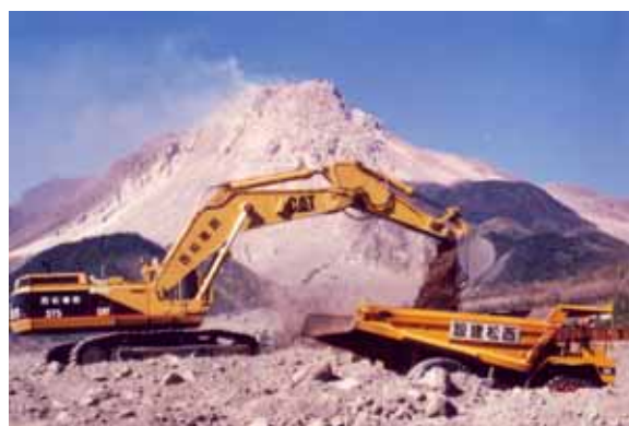
図4.1.2.2 無人化施工による警戒区域内での除石 (1994年4月11日 松井宗広撮影)
