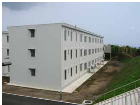
図 6.3.2.2 伊豆避難施設 (クリーンハウス) (2005.5.23 撮影)
