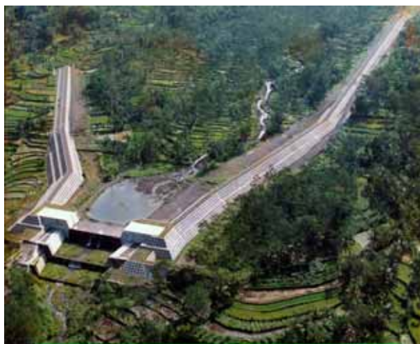
図 4.6.2.4 Phase II 砂防堰堤及び導流堤 (Blongkeng 川 BL-D1) (2000 年 6 月撮影)
