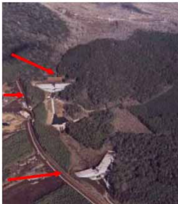
図 4.1.6.2 雲仙普賢岳に施工された火砕流熱風部対策用のフェンス工(矢印)
