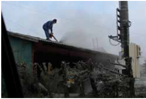
図 2.4.2.8 屋根の上での降灰除去作業 (都城市山田町，2011.2.5)
