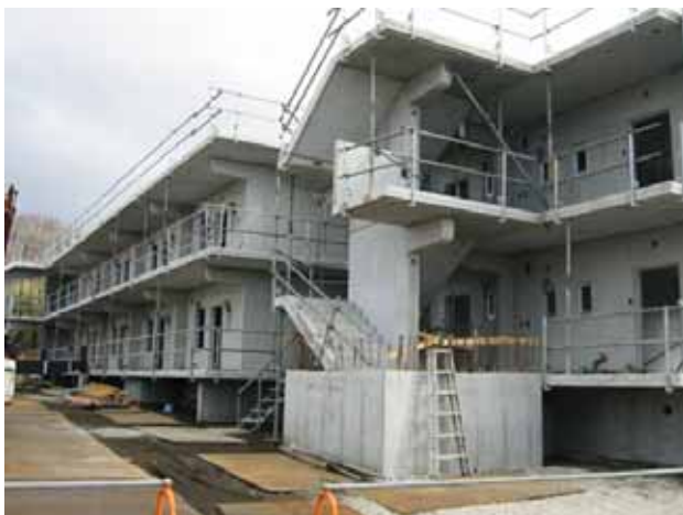
図 6.3.2.6 建設中の村営住宅 (2004.12.6 撮影)
