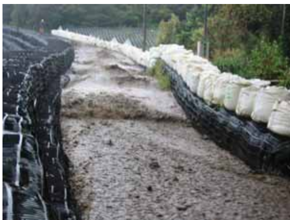
図4.3.3.1 大型土のうによる導流堤（釜方沢）
