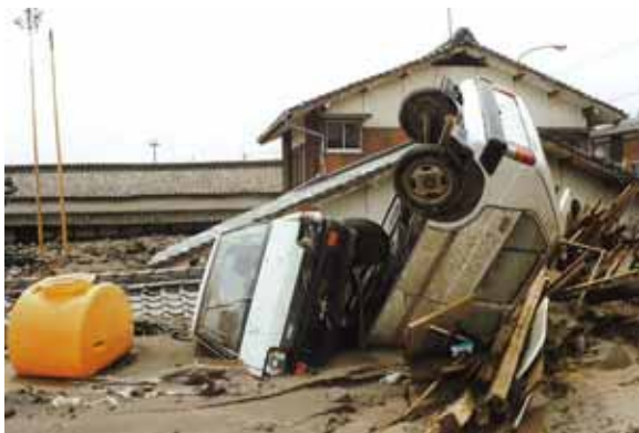
図 3.1.3.1 土石流により押し流された自動車 (1993年4月29日撮影)
