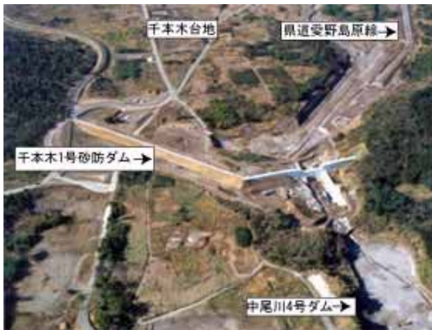
図 4.1.3.6 千本木1号砂防堰堤
