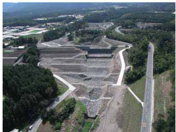
図 4.1.3.7 湯江川砂防堰堤（2011.3）
