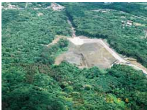
図 4.3.3.3 土石流堆積工（上方より撮影）
