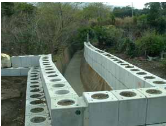
図4.3.3.2 流路嵩上げ状況（道の沢）
