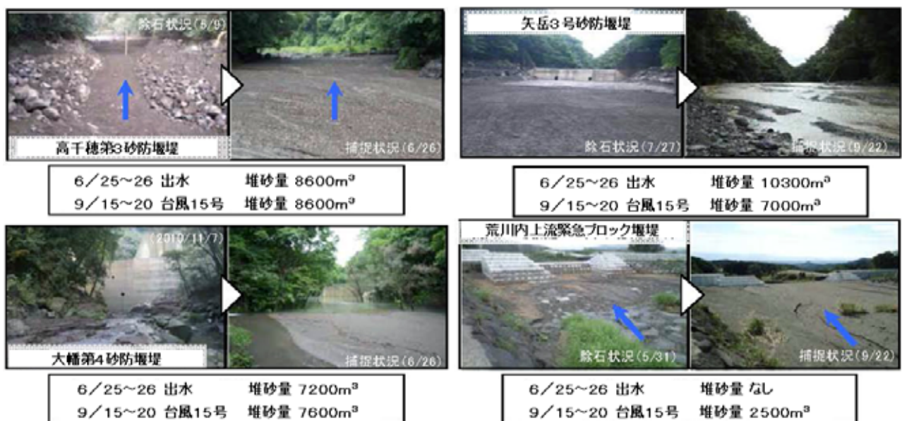
図 2.1.3.10 砂防堰堤の堆砂状況
