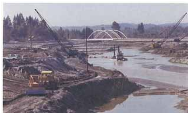
図 4.5.3.2 カウリッツ川での堆積土砂の除去作業の状況
