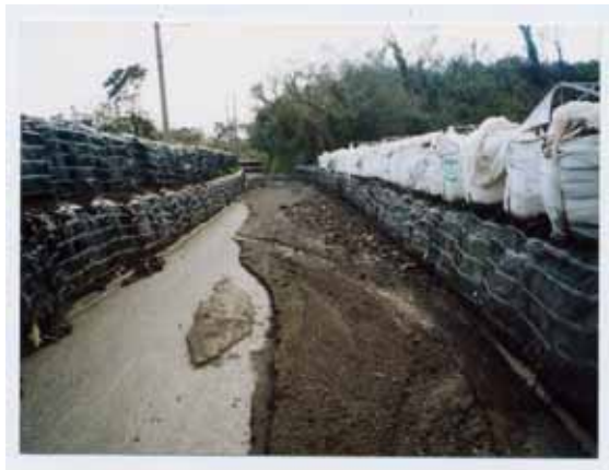
図 3.3.3.6 土のうによる流路工の応急対応
