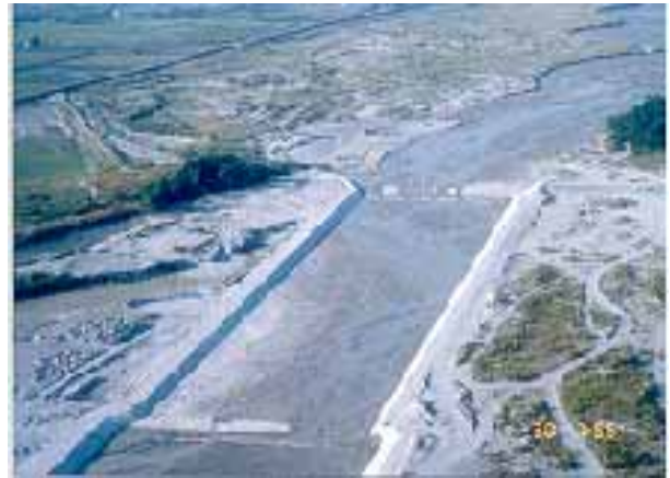
図4.7.2.2 マスカップ砂防ダム
