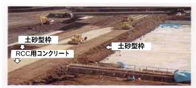
図 4.1.2.4 土砂型枠を用いた本体部の建設 (出典：雲仙復興工事事務所事業概要)
