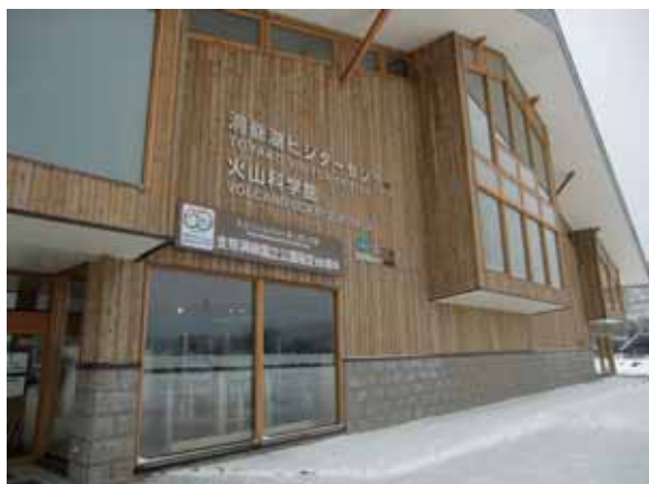
図 6.2.6.3 洞爺湖ビジターセンター
