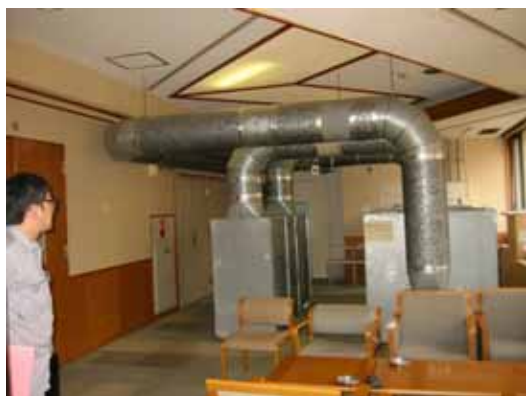
図 6.3.2.9 脱硫装置 (三宅村役場、2003 年 5 月 23 日撮影)
