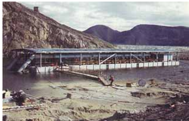
図 4.5.3.3 スピリット湖でのポンプ排水状況
