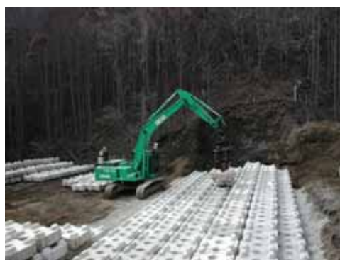
図 4.3.3.5 バックホウによるブロック設置状況
