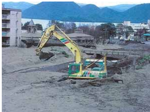
図 4.2.3.1 無人化施工状況 機械による西山川の堆積土砂の掘削作業
