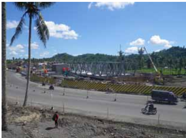
図 6.6.1.1 Putih 川 国道橋梁（施工中）（2011 年 1 月）
