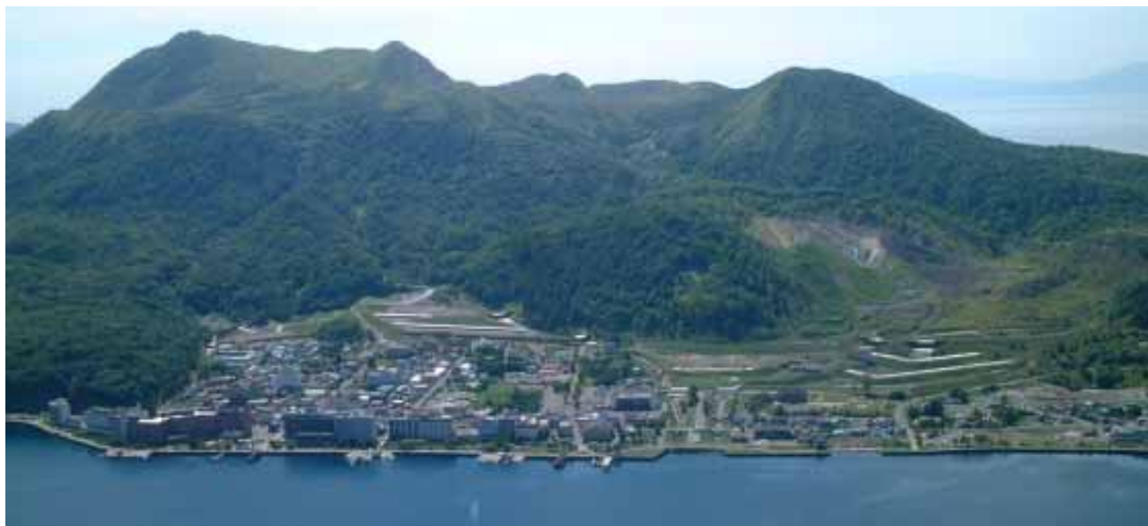
■ 4.2.3.3 完成した有珠山砂防施設と洞爺湖温泉街
