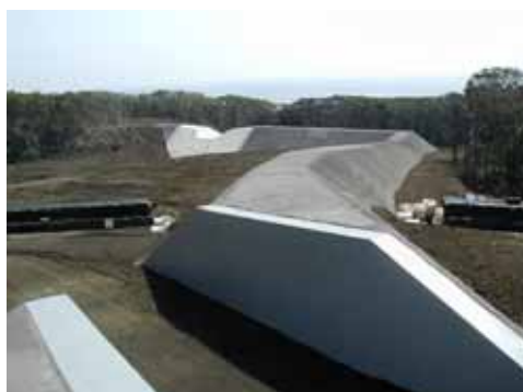
図 4.3.3.4 土石流堆積工（右岸上流より撮影）
