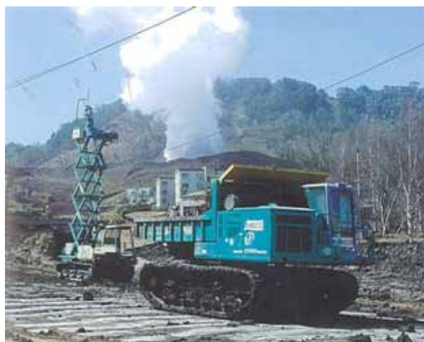
図 4.2.3.2 無人化施工状況 機械による西山川の堆積土砂の搬出作業
