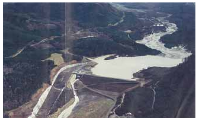
図 4.5.3.6 沈砂地(SRS)の全景
