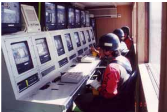
図4.1.2.3 無人化施工の遠隔操作作業状況 (1994年4月11日 松井宗廣撮影)
