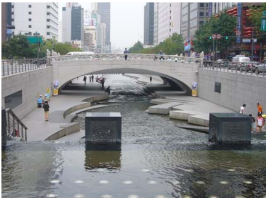
河川及び親水空間整備状況
