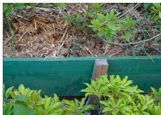
写真-3.7 緑化工に使用されたスギ板と木杭
