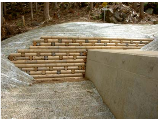
写真-11.7 木製土留工
