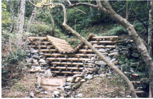
写真-5.22 久多演習林に設置した木製堰堤
