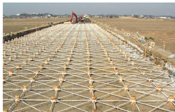
写真-3.5 パイルネット工法 （沼田淳紀氏提供）
