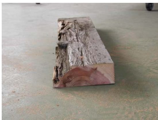
写真-2.4 辺材のみが腐朽したスギ床版
