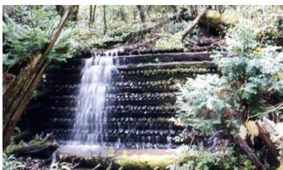
写真-5.16 坪毛沢 No.4 木製堰堤（1954年竣工）、有効高 3m、堤長 14.7m
