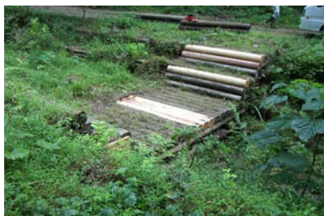
図-9.11 曲げ試験のために部材を取外した木製治山ダム（平成14年度施工鹿原）
