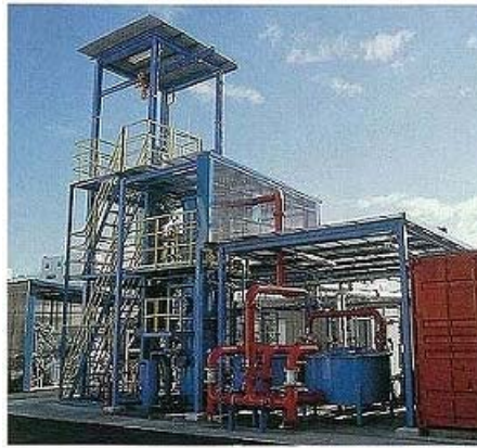
写真-10.3 バイオマスガス化発電
