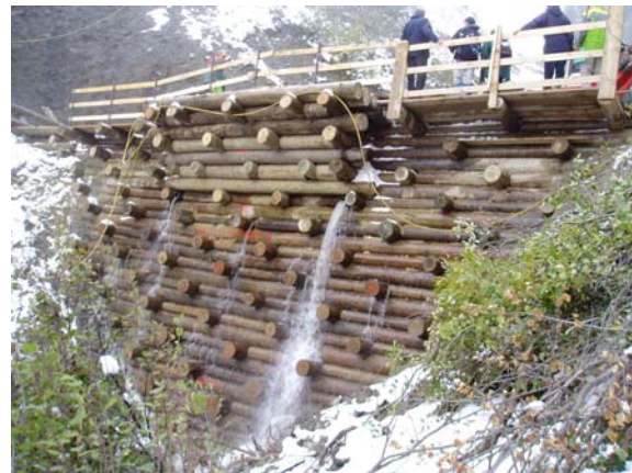
写真-8.3 オーストリア木製ダム（建設中） 高さ 15m を超える大型ダム
