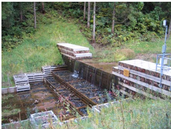
写真-8.8 秋田県木製治山ダム (オールウッドタイプ)
