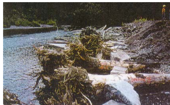
写真-5.11 護岸復旧工、根付き丸太 の設置（1994年施工）
