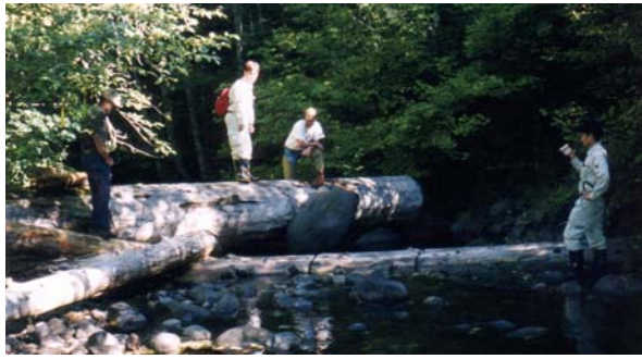
写真-5.8 複数の丸太を組み合わせて 作られたウェッジダム
