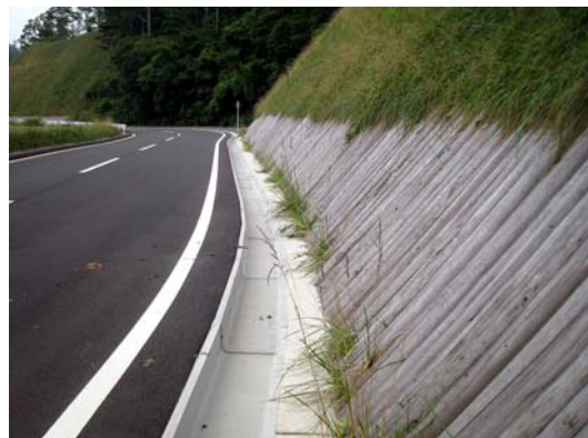
写真-11.6 丸太伏工
