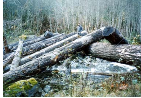
写真-5.9 上流からの流木を捕捉する ために、巨木により造られた 木製施設
