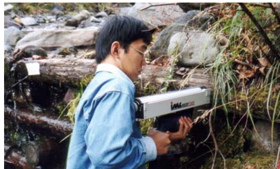
写真-5.36 穿孔抵抗試験器による計測
