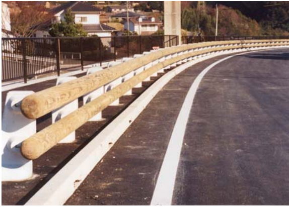
写真-7.6 国道 218 号線に設置された木製防護柵
