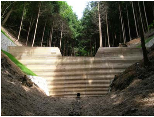
写真-11.1 木製残存型枠（丸太型枠）
