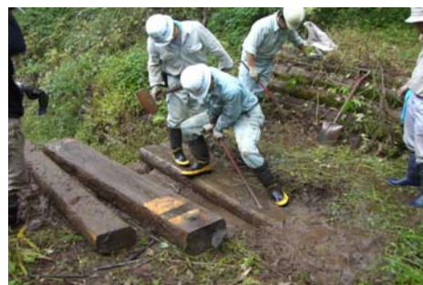
図-9.12 部材取外しの様子（平成11年度施工三山）
