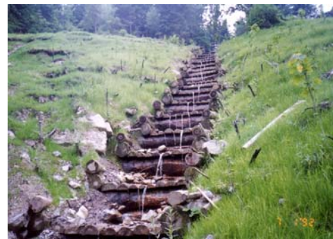
写真-5.1 スイスにおける木製水路
