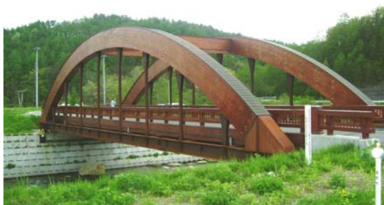
写真-3.1 木材利用例：木橋 (岩手県小出橋)
