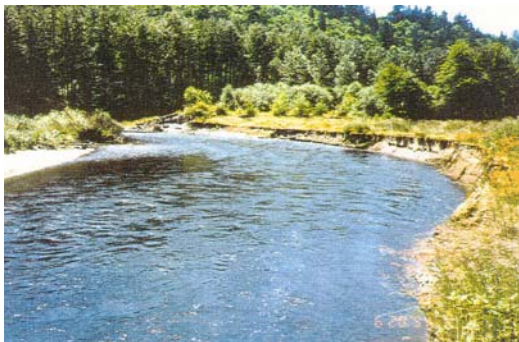
写真-5.10 護岸復旧工の施工前 （グリーン川、1994年6月時点）
