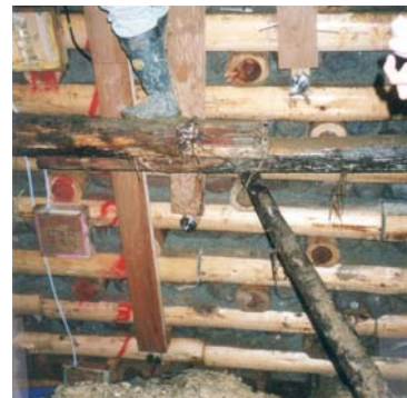
写真-5.29 京北町小塩に設置された木製治山堰堤（平成 12 年度）設置された土圧計
