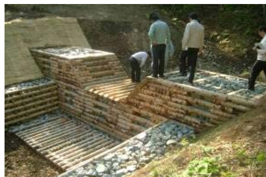
写真-3.2 木材利用例：木製治山ダム
