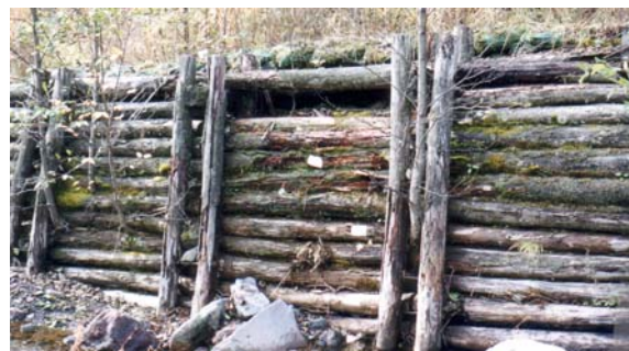
写真-5.21 濁沢木製護岸工(1985 年竣工) 高さ 2.5m
