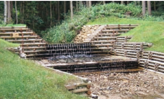
木製治山ダム (写真提供: 京都府)
