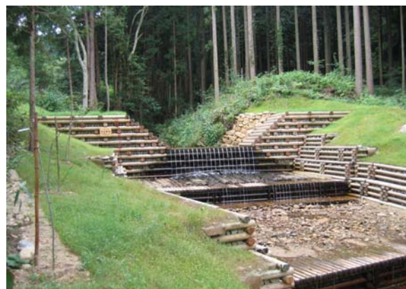
写真-8.1 木製治山ダム（台形型）
