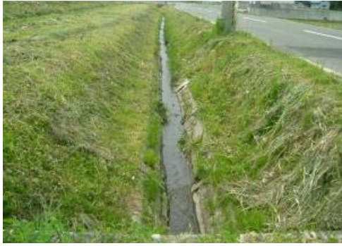
写真-3.10 木製水路
