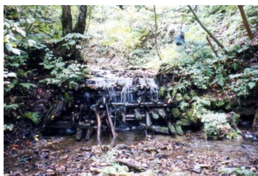
写真-5.15 坪毛沢 No.2 木製堰堤(1916年竣工)、有効高 1.4m、堤長 8.2m
