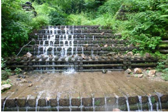
写真-8.4 平成 11 年設置木製治山ダム (京丹後市丹後町三山)
