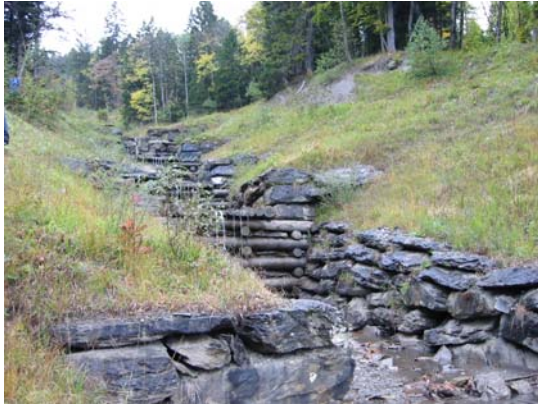
写真-8.6 スイスの地すべり地帯の ダム木材と石材を組み 合わせたもの
