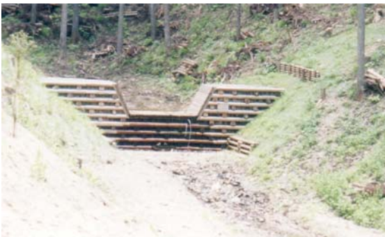
写真-5.28 京北町小塩に設置された木製治山堰堤（平成 12 年度施工）
