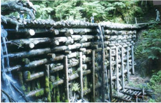
写真-5.18 流沢 No.1 木製堰堤 (1960 年竣工、1975 年および 1990-91 年補修)、有効高 8.0m、堤長 24m
