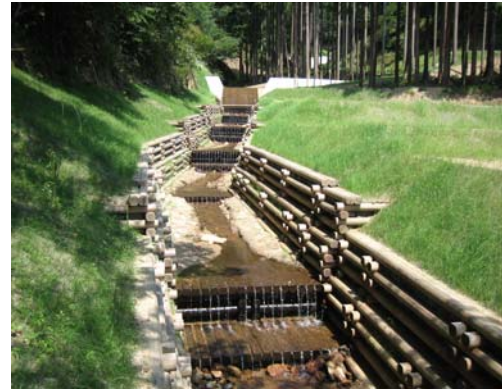
写真-11.4 木製流路工（フトン籠タイプ）
