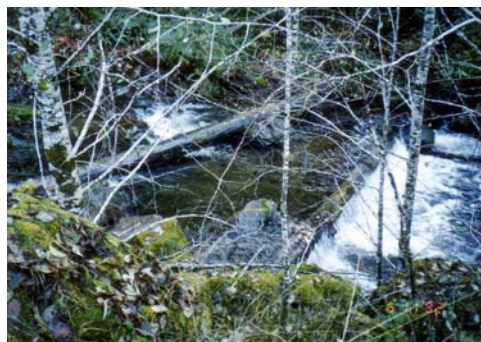
写真-5.6 溪流を横断する形で設置されたログダム
