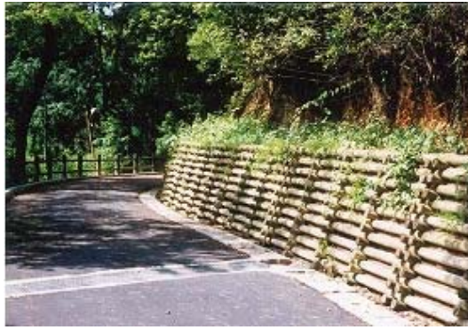
写真-10.5 道路擁壁
