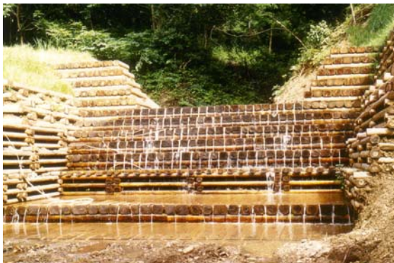
写真-5.24 京都府丹後町三山に設置された木製治山堰堤
