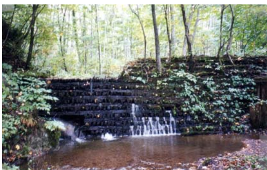
写真-5.14 坪毛沢 No.1 木製堰堤（1958年竣工）、有効高 2.5m、堤長 18m
