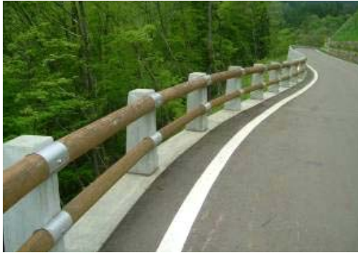
写真-3.3 木材利用例： 木製ガードレール
