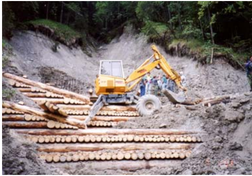
写真-5.3 スイスにおける木製堰堤 の施工状況
