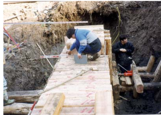
写真-5.25 水平載荷試験の実施（丹後町三山）
