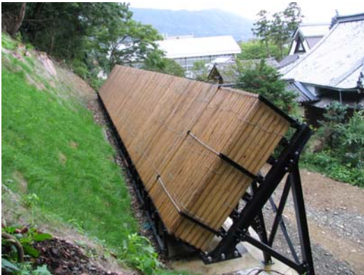
写真-11.3 落石防止柵（緩衝材）
