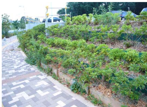
写真-3.6 のり面緑化工全景
