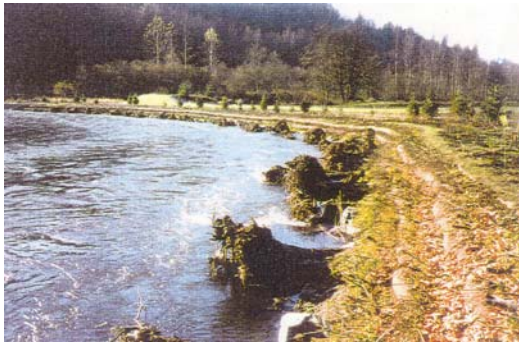
写真-5.12 護岸復旧工の完成 (1994年11月完成)
