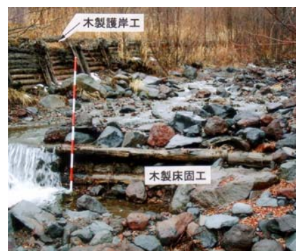
写真-5.32 部材を採取した御岳濁沢木製床固工・護岸工（1985年竣工、2002年12月撮影）
