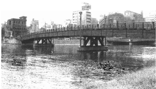
写真1 常盤橋の全景
