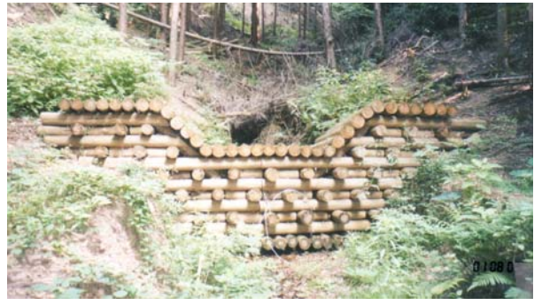
写真-5.23 大枝演習林に設置した木製堰堤
