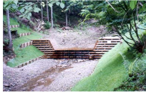
写真-5.27 京北町小塩に設置された木製治山堰堤（平成 11 年度施工）
