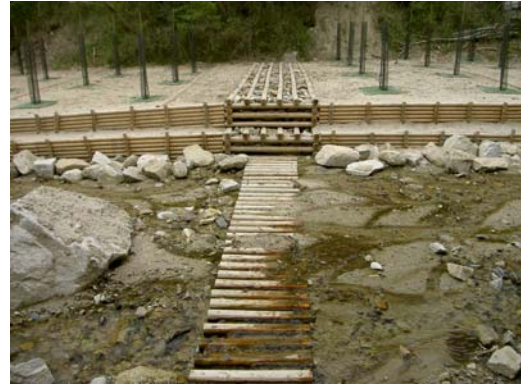
写真-11.2 木製護岸工（丸棒タイプ）
