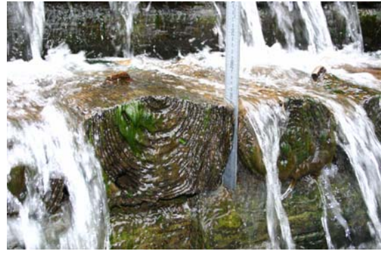
写真-8.5 平成 11 年設置木製治山ダム (本体部) 流砂等による摩耗が みられるが健全
