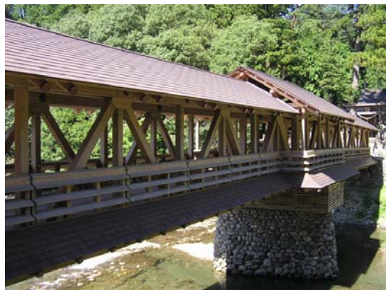
写真-7.5 御幸橋（高知県）
