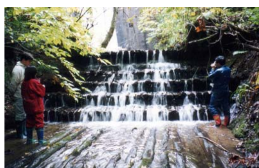
写真-5.17 坪毛沢 No.6 木製堰堤(1953年竣工)、有効高 2.2m、堤長 7.5m
