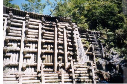
写真-5.19 流沢 No.5 木製堰堤(1960 年竣工、1975 年および 1990-91 年補修)、有効高 10.0m、堤長 21m
