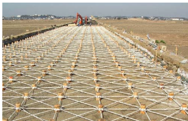
写真-7.3 パイルネット工法
