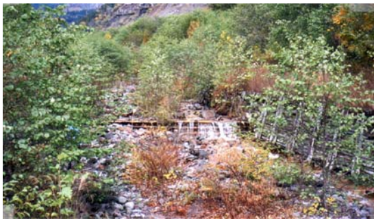
写真-5.20 濁沢木製堰堤 (1985 年竣工) 高さ 3.0、堤長 11m
