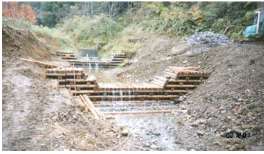
写真-5.26 舞鶴市鹿原に設置された木製治山堰堤（奥の堰堤は平成 11 年度施工、手前は平成 12 年度施工）
