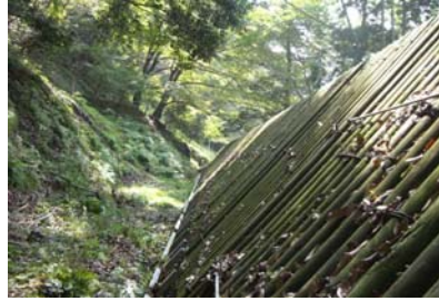
図-9.6 落石防護柵
