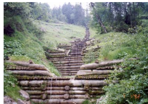
写真-5.2 スイスにおける木製堰堤
