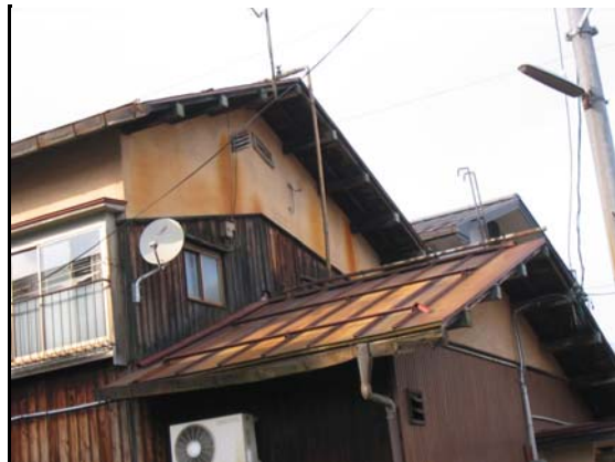
古い住宅では散水により屋根が着色している
