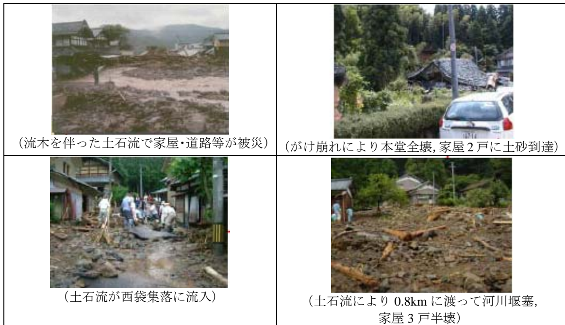
写真 5.4 福井豪雨による土砂災害の様子
