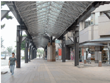
写真 連続上屋による全天候型歩行空間 （リファーレ前）
