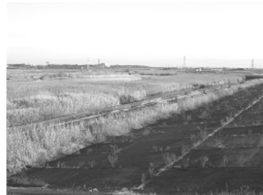
写真6.3 菅生調節池（利根川）。左は農地部，右は湿地状地区の様子。右手前は越流堤。
