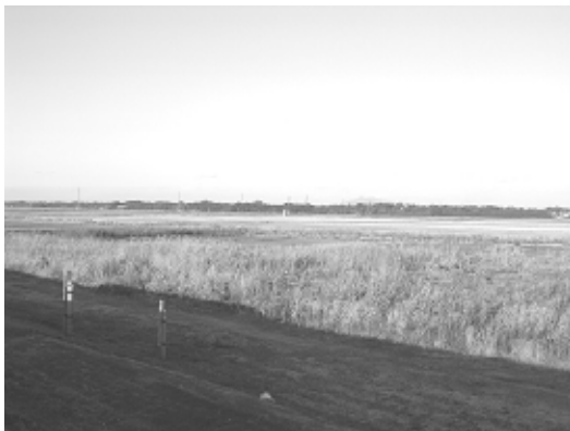
写真6.3 菅生調節池（利根川）。左は農地部，右は湿地状地区の様子。右手前は越流堤。
