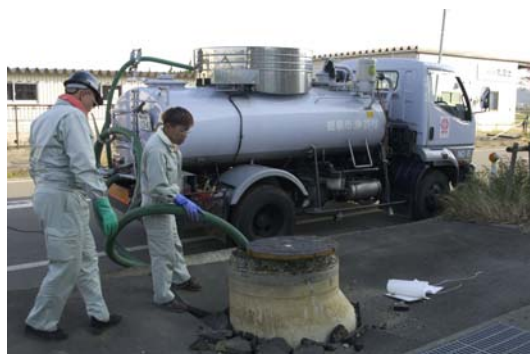
写真 3.3 バキューム車による下水滞留部の吸引
