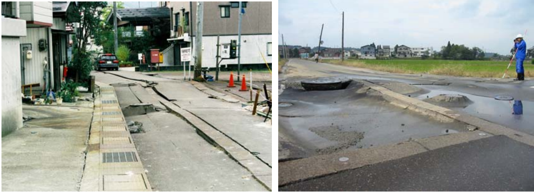
写真 8.4 中越地震における消雪パイプの被害状況（小千谷市下水道課撮影）
