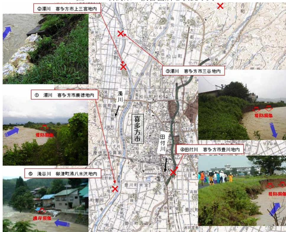
図 5.5 福島県の被害箇所と状況写真
