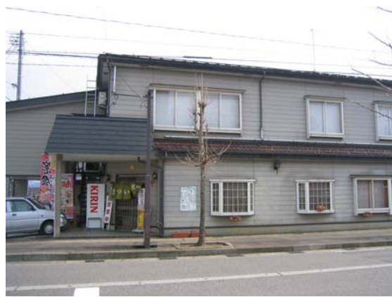
商店の小屋根に設置された散水装置
