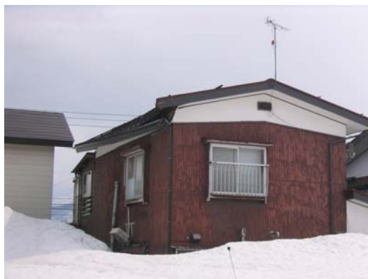
写真 8.2 積雪の加重により破壊した軒（南魚沼市）
