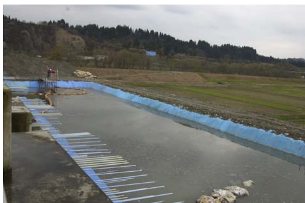
写真 3.1 堀之内浄化センターの応急沈殿地
