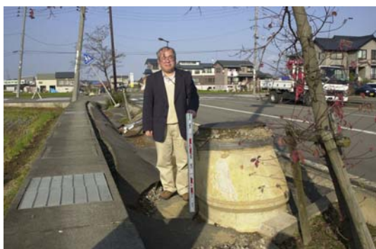
写真 3.2 マンホールの浮上と管路埋め戻し部の沈下
