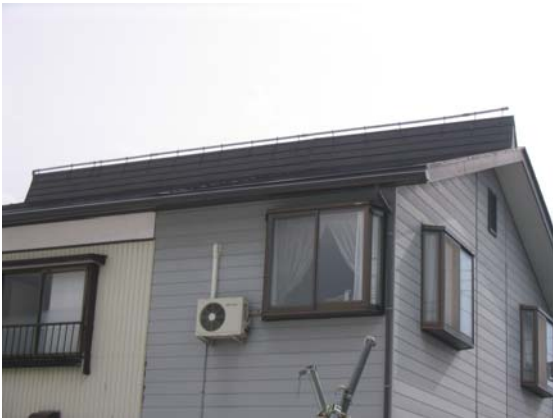
比較的新しい家屋でも散水装置が設置されている
