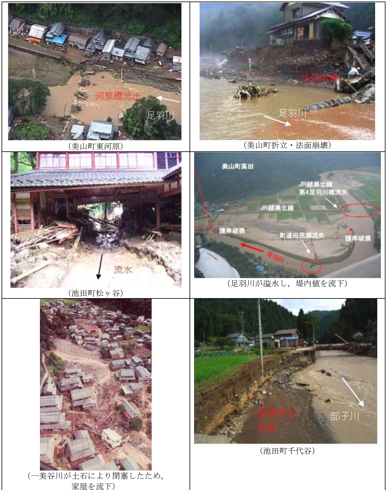
写真 5.2 福井豪雨による浸水被害状況 (2/2)
