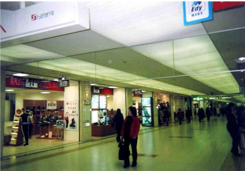
写真-2.3.5 透明除煙板
