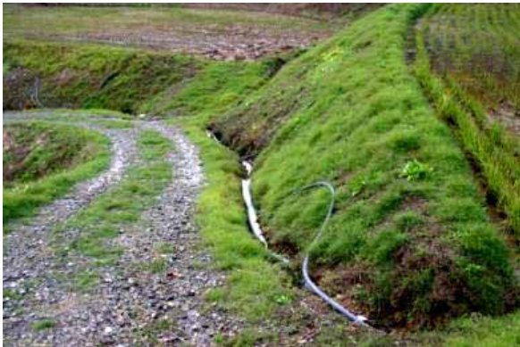
写真 5.2-13 棚田の中に設置された水路と、導水、排水用の塩ビ管。(小千谷市小栗山 43 地点：05.5.14)
