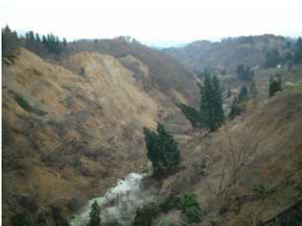
写真 4.2-11 河川斜面表層崩壊 (大久保 04.4.26)
