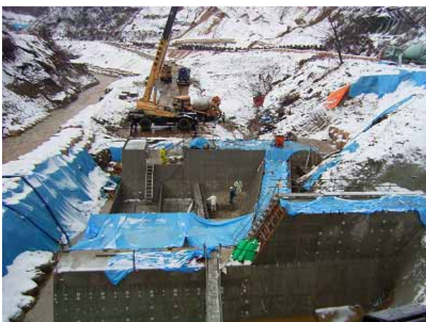
写真7.1-26 十二平地区における砂防堰堤工事状況(3地点)
