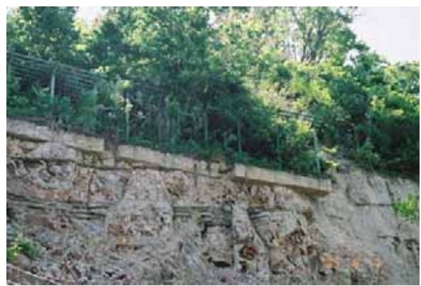
写真 3.4-10 深層崩壊により基礎が露出した予防柵 (旧山古志村 05.5.31)
