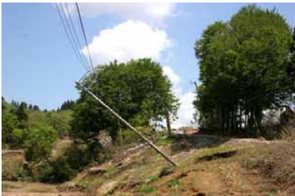
写真 5.2-6 崩落した道路路肩、傾斜した電柱の傍で自然林のブナ樹林は無傷であった。(旧山古志村東竹沢 05.5.14)
