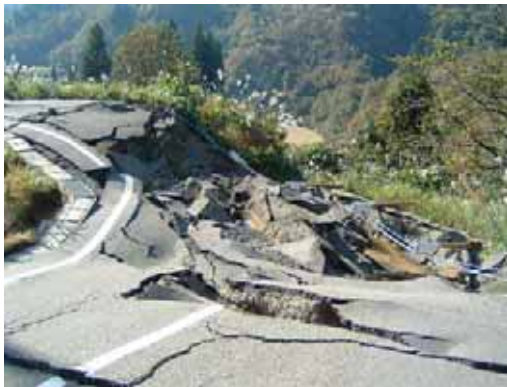
写真 2. 8-5 山古志村内の道路盛土の崩壊と大量の湧水 (5 地点 : 04. 10. 29)
