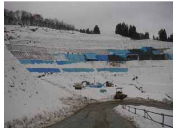
写真 4. 2-52 吹付枠工 (寺野 11 地点 05.12.10)
