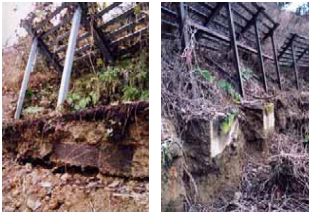
写真 3.4-11 地盤の変位により基礎が浮いた予防柵 (旧山古志村竹沢) (左: 32地点:04.11.26 右: 31地点:05.5.31)
