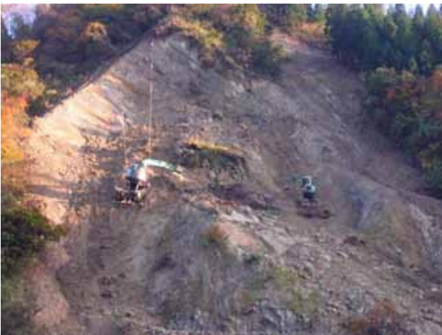
写真7.1-16 施工中の山腹工（小国町七日町）新潟県提供 急斜な深層崩壊地に対して、クライミングマシンにより不安定な土塊を取り除いている（法切工）。
