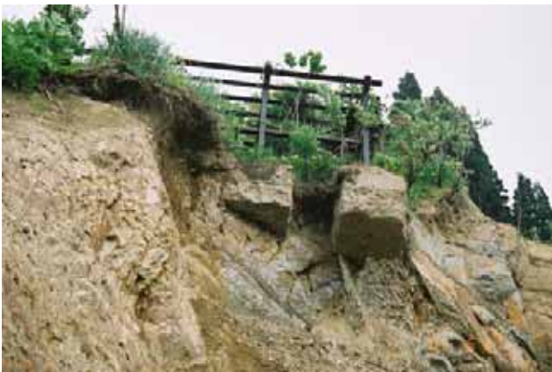
写真 3.4-12 深層崩壊により基礎が浮いた予防柵 (旧山古志村竹沢) (31地点:05.5.31)
