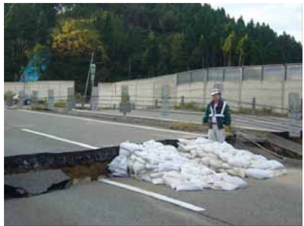
写真 7.2-1 土のうによる緊急車両の通路確保(路面段差部)
