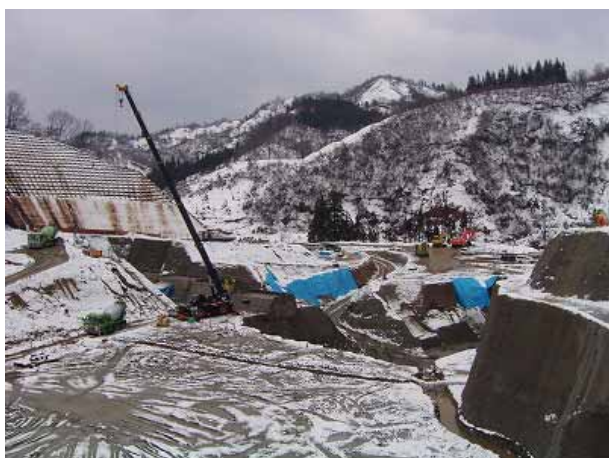
写真7.1-25 東竹沢地区における砂防堰堤工事状況(1地点)
