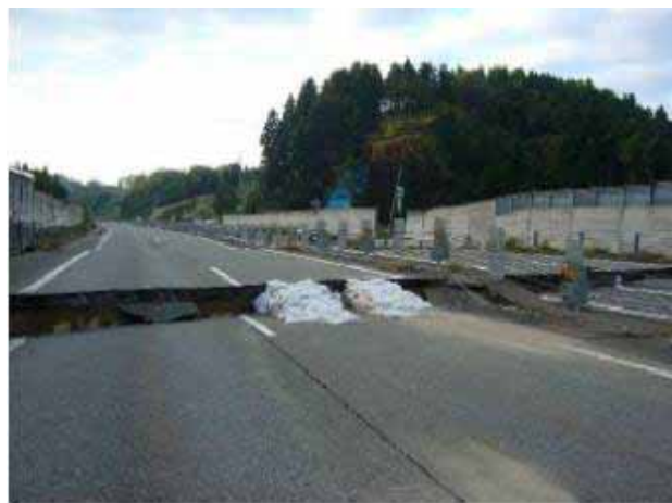
図 3.7-8 カルバートボックス部における段差
