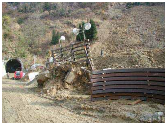
写真 3.3-35 深いすべりによって土塊ごと移動した 予防柵の被災事例 (30 地点 : 04.11.26)
