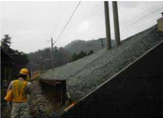
写真 7.3-4 復旧状況 (JR 東日本提供)
