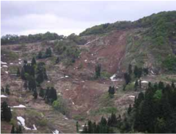
写真 4. 2-23 山腹斜面表層崩落 (種芋原05.5.16)
