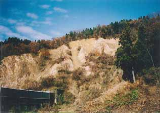
写真 3.1-6 上越新幹線妙見トンネル抗口の表層崩壊 (小千谷市浦柄) (地点: 04.11.26)
