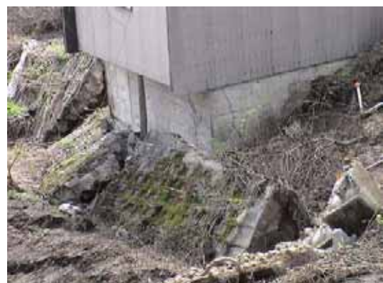
写真 3.5-8 池谷地区、道路横の急傾斜部の盛土上の構造物の被災例(23地点：05.5.14)
