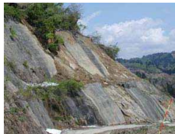
写真 3.3-3. 吹付け工の被災事例 (25 地点 : 05.05.14)
