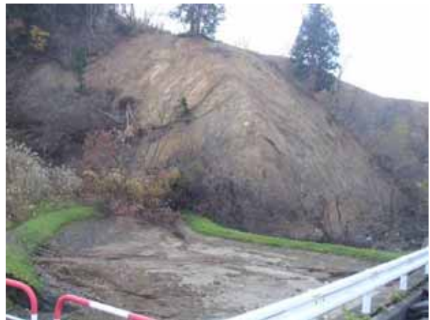
写真 4.2-18 河川斜面表層崩壊 (小栗山 04.11.26)
