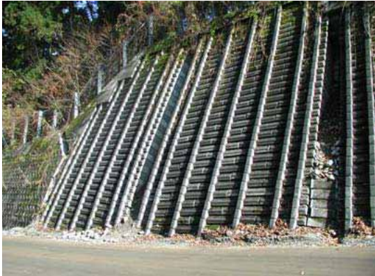
写真 3.3-17 井桁擁壁の被災状況 (45 地点 : 04.11.26)
