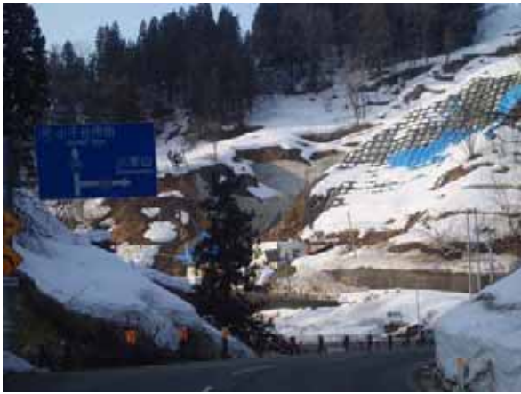
写真7.1-4 完成した治山ダム等（小千谷市呼坂） 林野庁提供（45地点：05.3）
