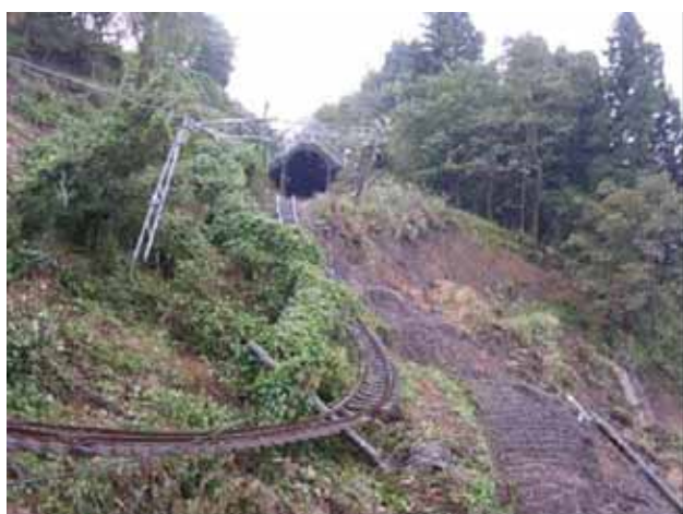
写真 3.6-3 盛土崩壊の状況(61 地点: JR 東日本提供)
