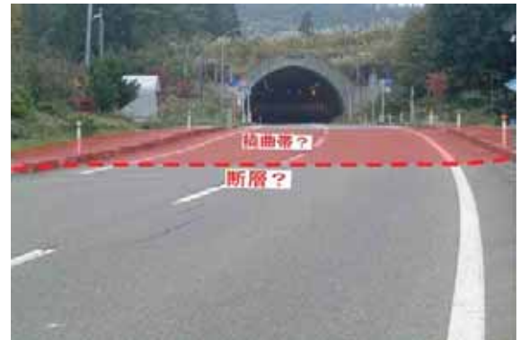
写真2.3-1B 小平尾地区の道路の変形 (解釈あり 19地点：04.10.30)
