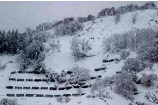
写真8.3-4 斜面に設置されたなだれ予防柵 (長岡市蓬平町 05.3.23) 予防柵が一部崩壊している。
