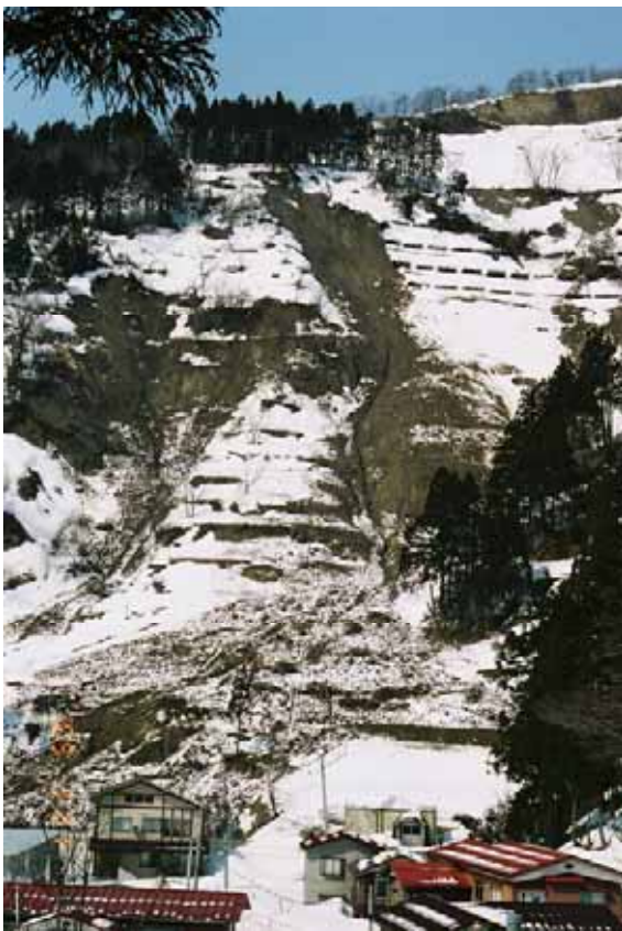
写真2.7-5 融雪期の2005年3月23日夕方発生した崩壊地 (長岡市濁沢町, 56 地点 : 05.3.27)
