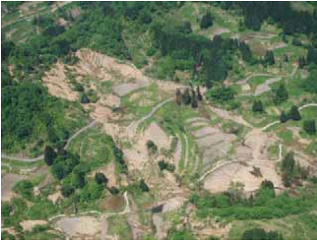
写真7.1-15 調査中の再滑動した地すべり（旧栃尾市滝之上） 林野庁提供
