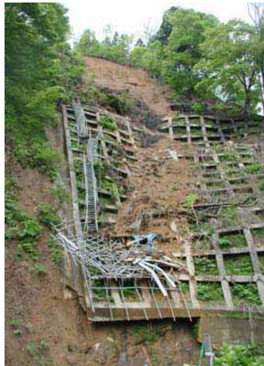
写真 3.3-10 融雪後の状況 (50 地点 : 05.05.15)
