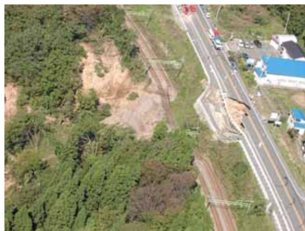
写真 3.6-5 盛土崩壊の状況(59 地点: JR 東日本提供)
