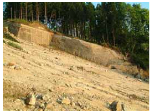
写真 2.2-4 白岩の岩盤崩壊 (48 地点 : 05.5.14)
