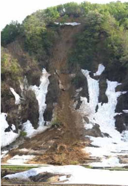
写真8.3-1 融雪期における表層崩壊地の侵食(広神村05.3.23)雪面上に土砂が流下、崩落部分を広げている。
