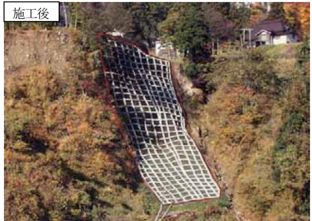
写真7.1-19 法枠工の施工箇所（高柳町高尾）新潟県提供
