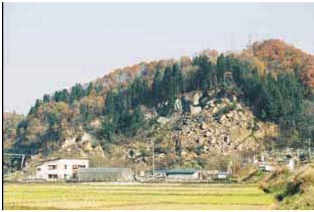
写真 3.1-14 通行車両が巻き込まれた岩盤崩壊 (長岡市妙見町) (47地点: 04.11.26)
