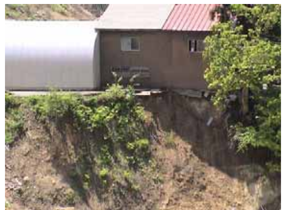
写真 3.5-9 川沿いの急崖部の基礎地盤が崩壊。2006年12月にもまだ復旧工事に取りかかっていなかった。(31地点：05.5.14)
