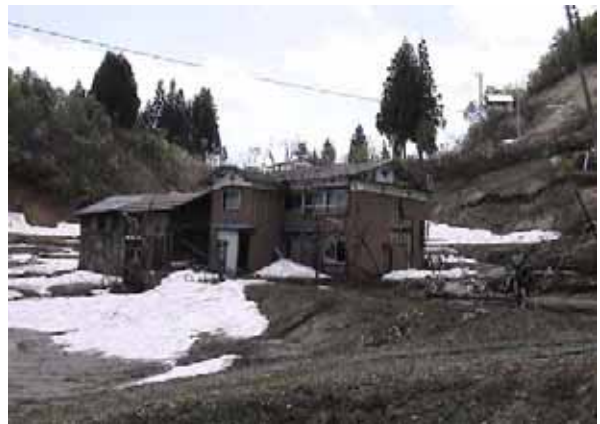
写真 3.5-13 池谷地区. 左側の水田が沢埋め土砂部. 家 屋は大きく変状している. (23 地点 : 05.5.14)
