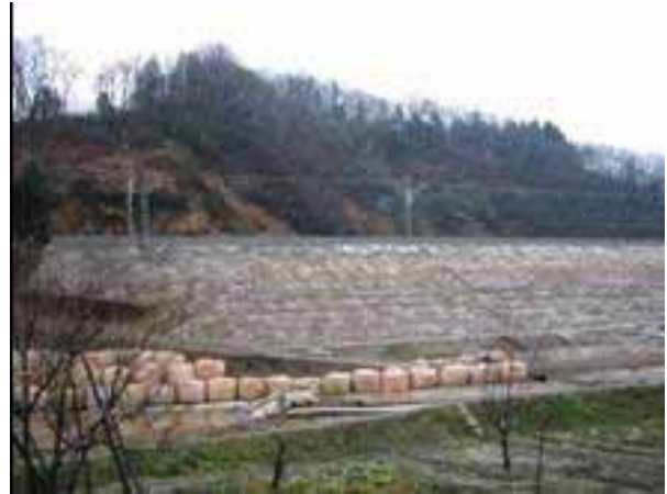
写真7.3-5 復旧状況 (JR東日本提供)
