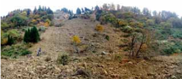
写真7.1-11 崩壊地の状況(旧山古志村竹沢)新潟県提供
