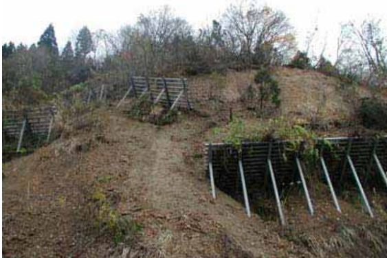
写真 3.3-39 表層崩壊によって基礎が破壊した事例と表土が予防柵で捕捉され予防柵機能が低下した事例 (34 地点 : 04.11.16)
