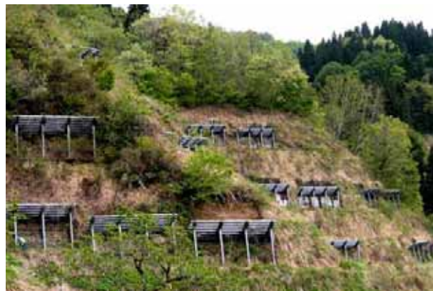
写真5.1-15 雪崩防止柵が設置された既存急傾斜地。小規模な表層崩壊にとどまっている。（東竹沢05.5.14）
