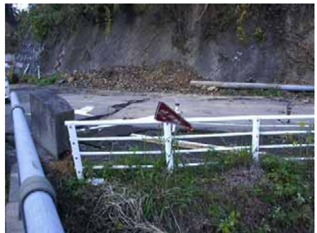
写真 6.1-10 破損したコンクリートやガードレール等 (旧山古志村) (04. 11. 23)
