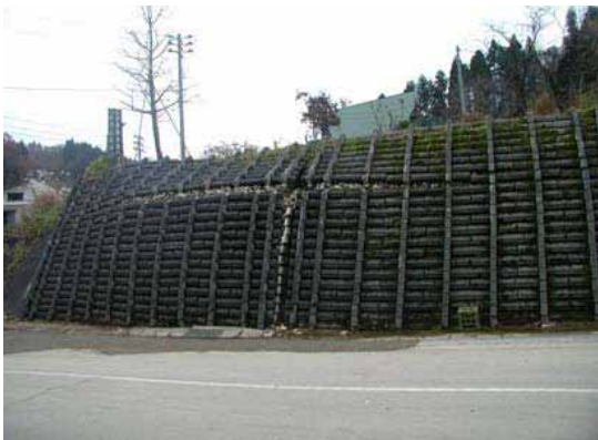
写真 3.3-19 井桁擁壁の被災状況 (36 地点 : 04.11.26)
