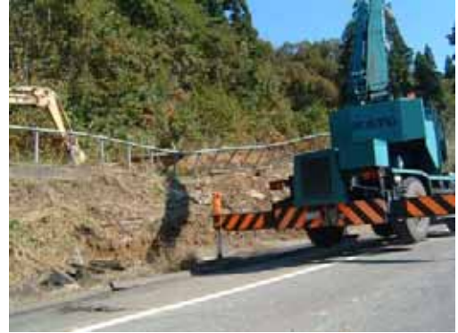
写真 2.8-10 復旧の進む関越自動車道の災害現場（04.10.29）
