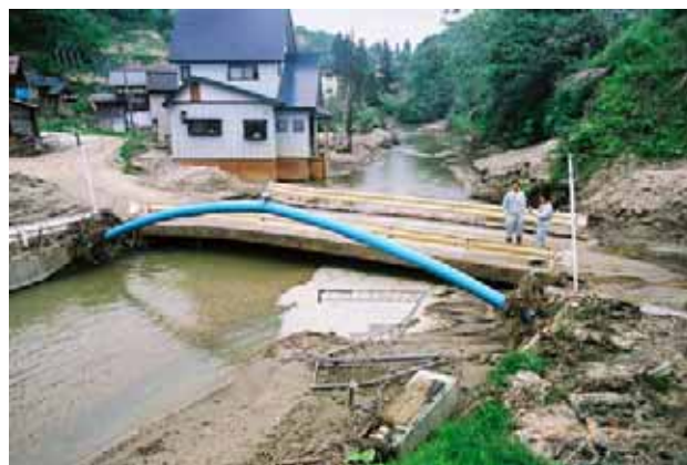
写真5.3-2 河床が上昇した芋川(旧山古志村植木集落, 05.5.31)
