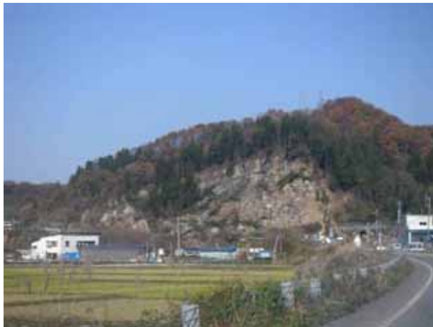
写真 4. 2-27 岩盤崩壊 (妙見トンネル 04.11.26)
