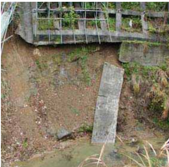
写真 3.3-9 のり枠工基礎部の被災状況 (50 地点 : 04.11.28)
