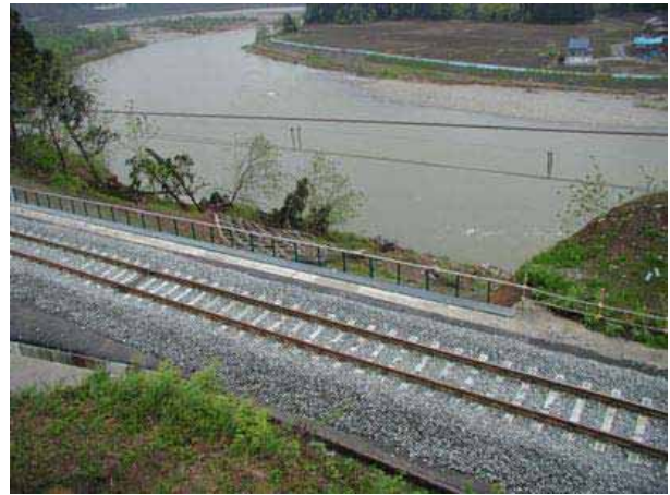
写真 3.3-5 のり枠工の被災事例 (60 地点 : 05.05.15)
