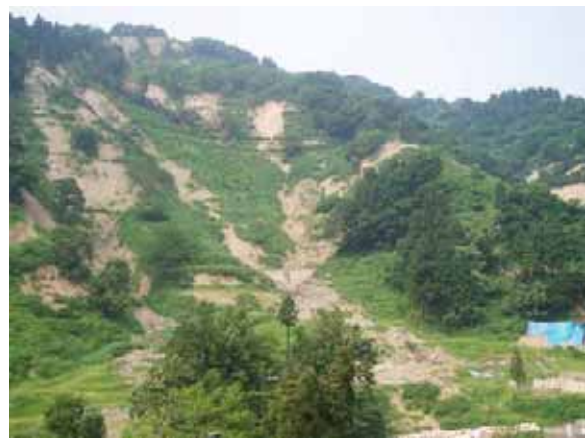
写真7.1-6 崩壊が多発した斜面（長岡市貫）林野庁提供
