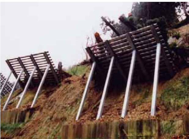
写真 3.4-13 崩土・倒木が堆積した予防柵 (旧山古志村寺野) (11地点: 04.11.27)
