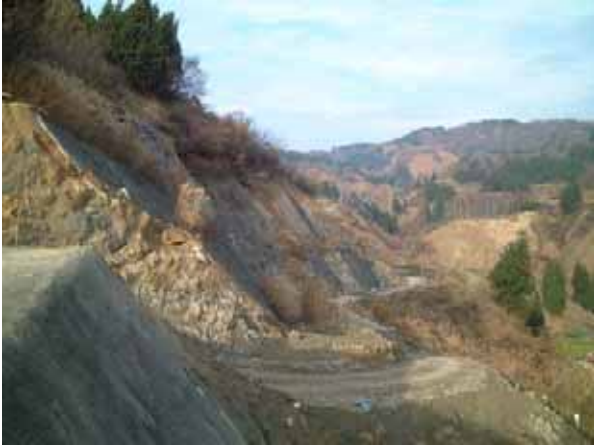
写真 4. 2-21 モルタル吹付面の崩落と表層崩壊(池谷04.11.26)
