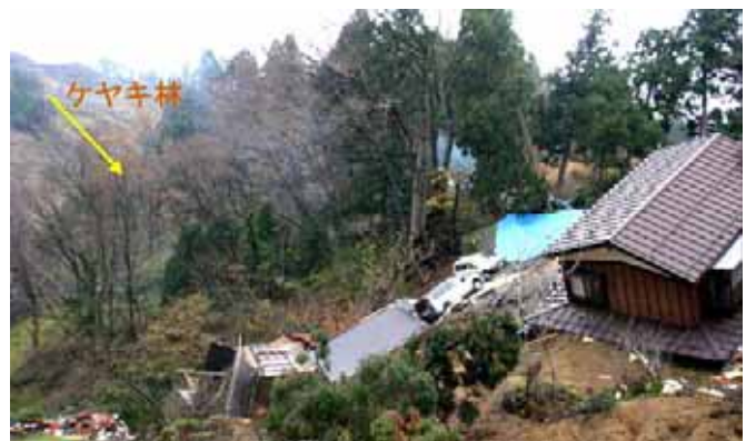
写真 5.2-8 住宅を巻き込んで滑落した濁沢地区、隣接するケヤキ林(後方左側)はほとんど無傷であった。(長岡市濁沢 55 地点 : 04.11.15)
