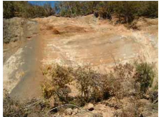
写真 2. 8-8 急崖部の植生表土だけの表層崩壊 (04.10.29)
