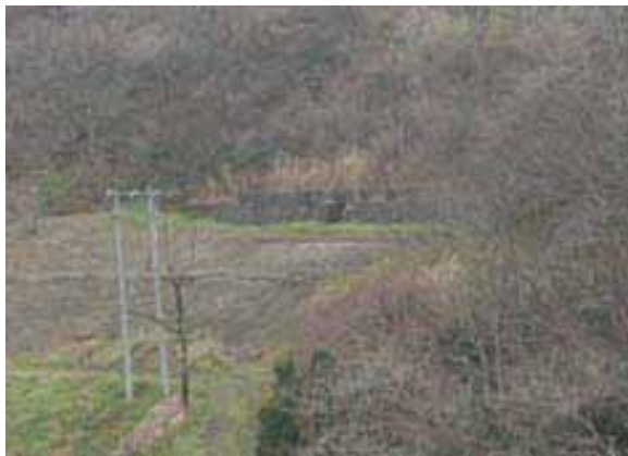
写真 3.3-33 鋼製枠構造物の状況 (14 地点 : 04.11.27)
