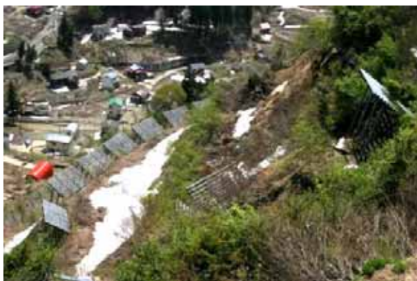
写真5.1-14 雪崩常習地の既存の急傾斜地。小規模な表層崩壊にとどまっている。（旧山古志村東竹沢05.5.14）
