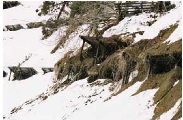
写真 3.4-15 崩土に埋まった予防柵 (長岡市濁沢) (56地点: 05.3.27)
