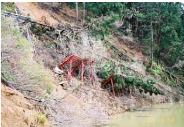
写真 3.4-6 表層崩壊によりすべり落ちた予防柵 (東竹沢 05.5.13)
