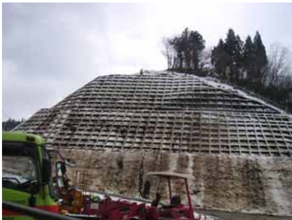
写真 4. 2-51 吹付枠工 (寺野 12 地点 05.12.10)
