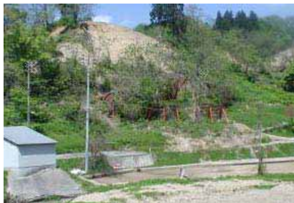
写真 3.3-38 同上融雪後の状況 (44 地点 : 05.05.14)
