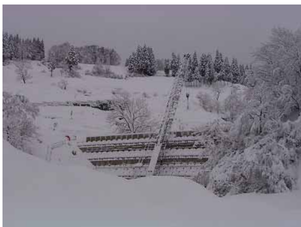
写真7.1-24 東川地区における砂防堰堤（ブロック堰堤）
