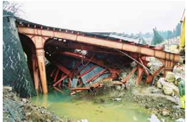
写真3.4-3 崩土により押しつぶされたスノーシエツド(12地点:04.11.27)
