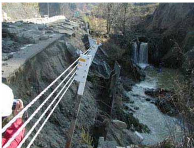
写真 3.3-13 L型擁壁工の被災状況 (44 地点：04.11.27)
