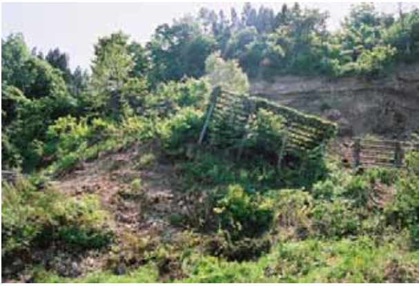
写真 3.4-5 崩土と共に崩落した予防柵(旧山古志村 05.5.31)
