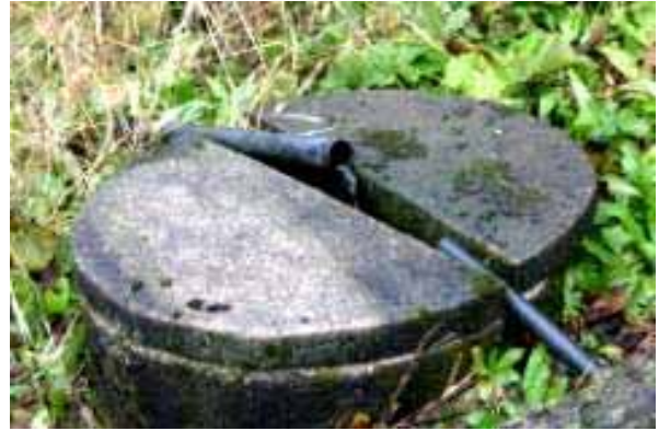
写真 5.2-14 棚田に設置されてる集水枡の例。塩ビ管でネットワーク化されている。(小栗山 05.5.14)
