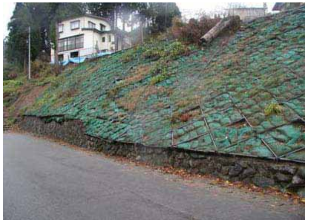
写真 3.3-27 軽量砕工の被災状況 (52 地点 : 04.11.28)
