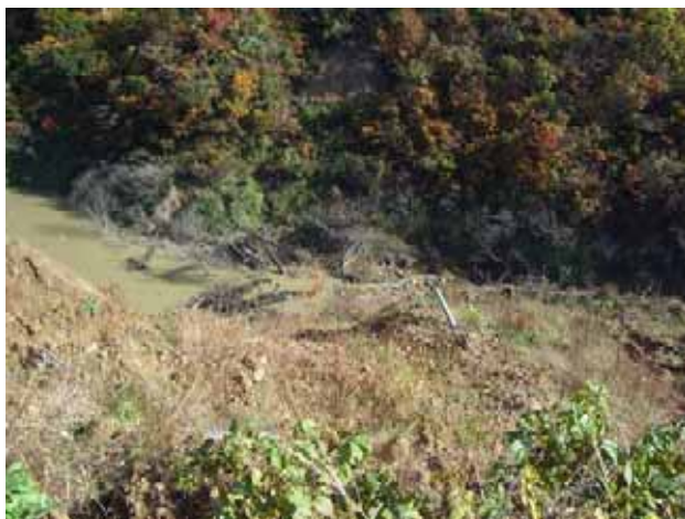
写真3.8-3 No. 3河道閉塞の概況 (68地点付近：05. 11. 11)
