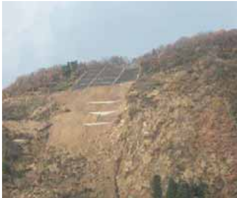
写真7.1-10 崩壊地上部の施工(旧山古志村風口) 林野庁提供 (9地点)
