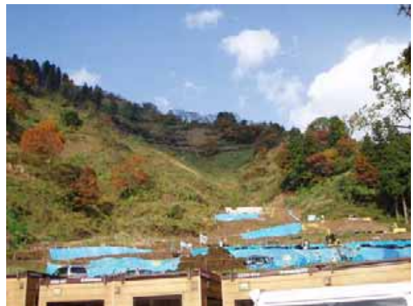
写真7.1-7 施工状況（長岡市貫）林野庁提供（56地点）
