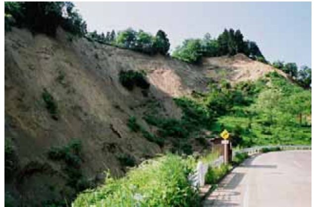
写真5.1-6 急斜面の広葉樹低木林に発生した表層崩壊。 (小千谷市首沢) (05.6.1)
