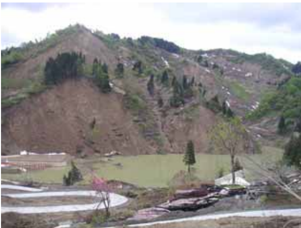
写真 4. 2-25 山腹斜面表層崩落 (寺野05.5.16)
