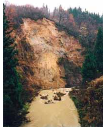
写真 3.1-5 芋川下流部の水衝部における表層崩壊 (堀之内町竜光) (48地点 : 04.11.25)
