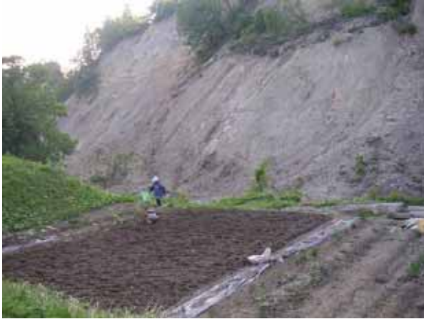
写真 4.2-53 吹付粹工 (小栗山 11 地点 05.515)
