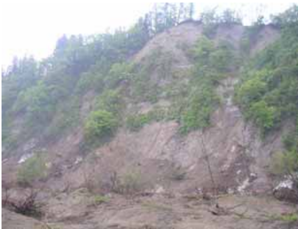
写真 4.2-9 段丘斜面崩落 (北堀之内 05.5.15)
