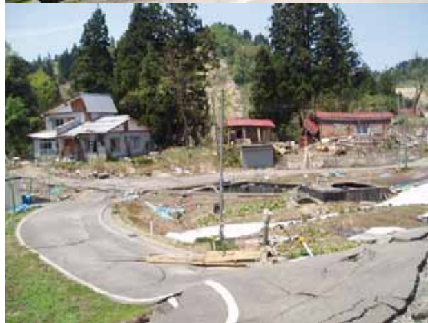
写真 6.1-6 地震発生後半年以上経過後の家屋の状況(旧山古志村) (05. 5. 21)
