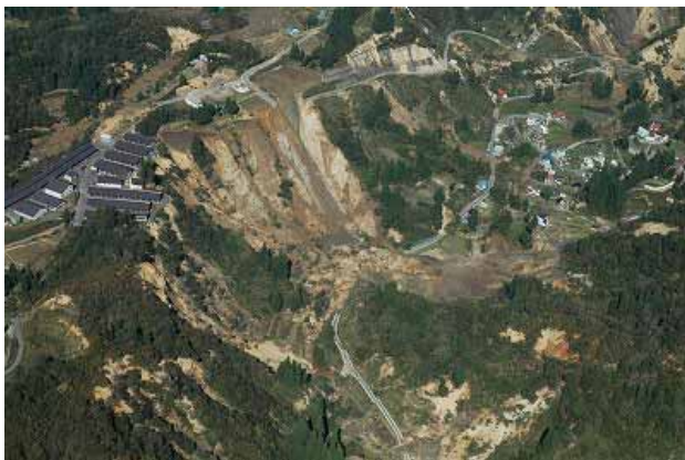
写真3.8-2 楯木地区における河道閉塞発生状況 (26地点：04.10.24, 写真提供：朝日航洋株式会社)
