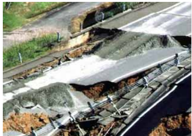
写真 7.2-2 碎石投入による緊急車両の通路確保 (大規模路面崩壊部)
