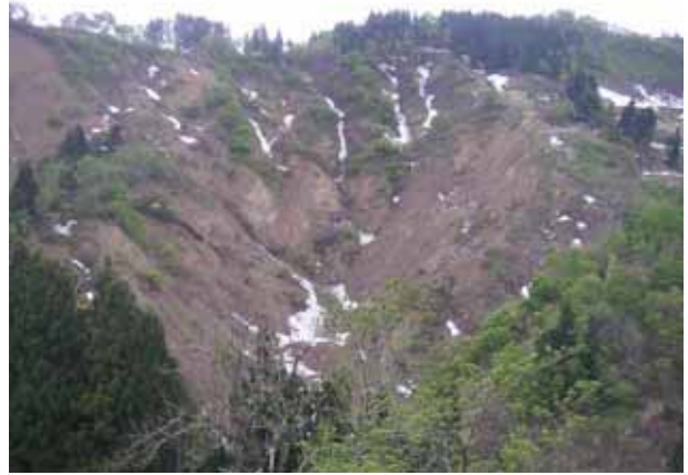
写真 4. 2-22 山腹斜面表層崩壊(寺野05.5.16)
