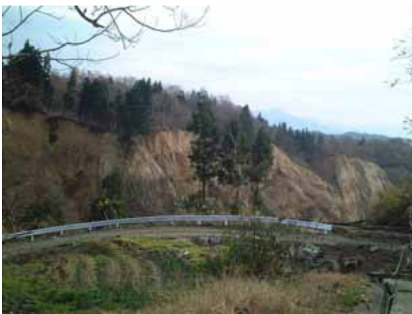
写真 4.2-13 河川斜面表層崩壊 (大久保 05.4.26)
