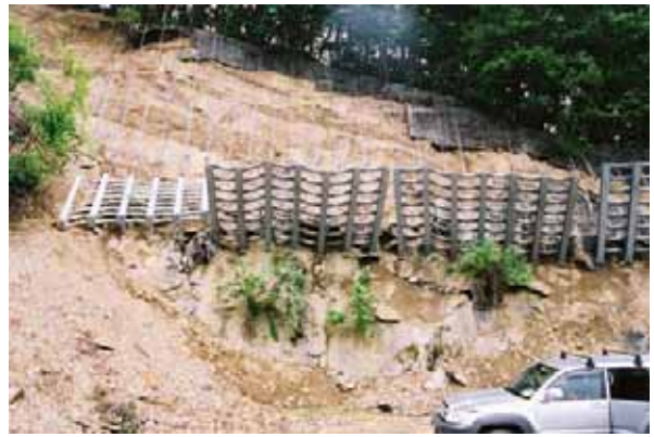
写真 3.4-2 被災した吊柵(旧山古志村竹沢05.531)
