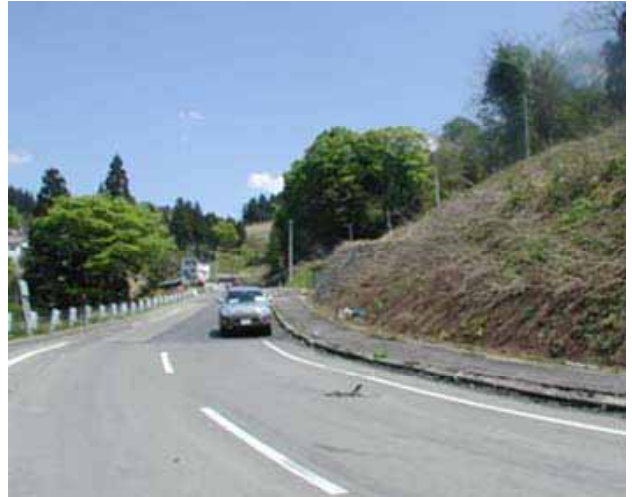
写真 3.3-26 融雪後の状況 (35 地点 : 05.05.14)
