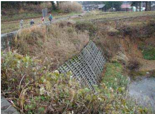
写真 3.3-20 井桁擁壁の被災状況 (6 地点 : 04.11.28)
