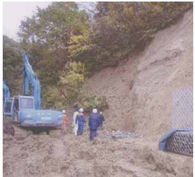
図 7.6-2 栃尾市での労働災害事例
