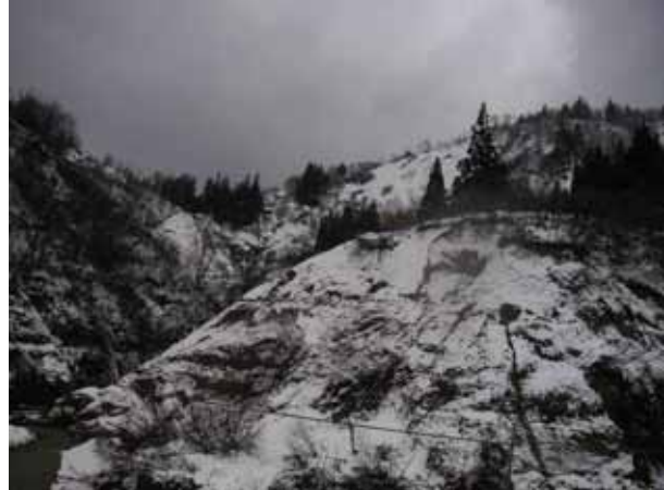
写真 4. 2-42 表層崩壊箇所 (小栗山 05.12.10)
