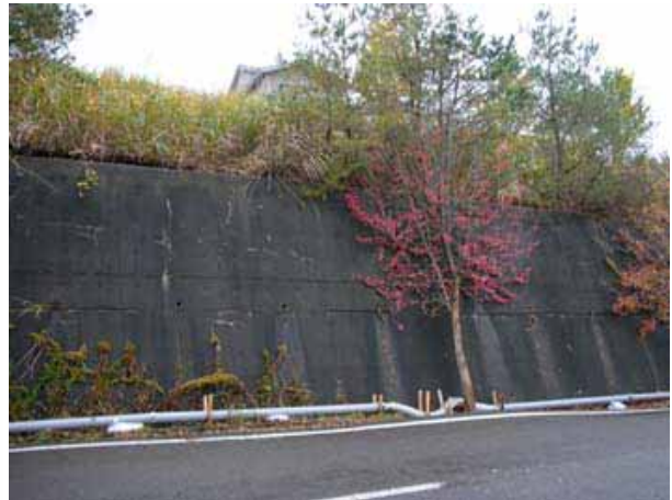
写真 3.5-1 擁壁の割れ目から流出する地下水 (高町団地) (66 地点 : 04.10.31)
