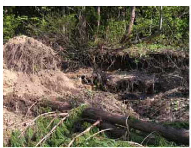
写真 4.2-40 根系の緩み箇所(小栗山41地点 05.5.28) 融雪水による侵食により転倒・崩落が進行している
