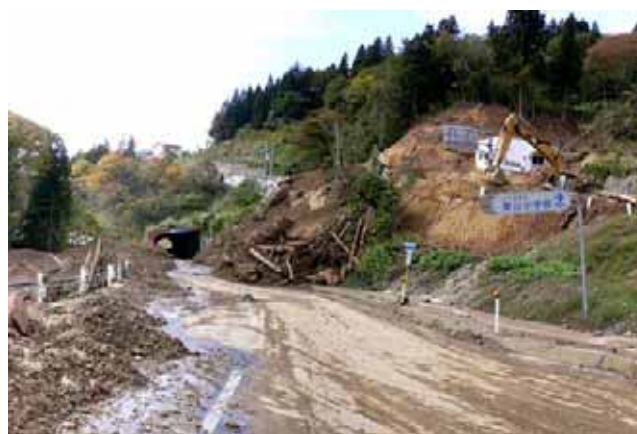
写真7.1-3 崩土の流出により国道が被災（小千谷市呼坂） 新潟県提供（45地点）
