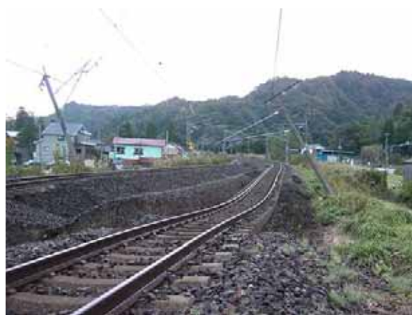
写真 3.6-7 盛土崩壊(JR 東日本提供)
