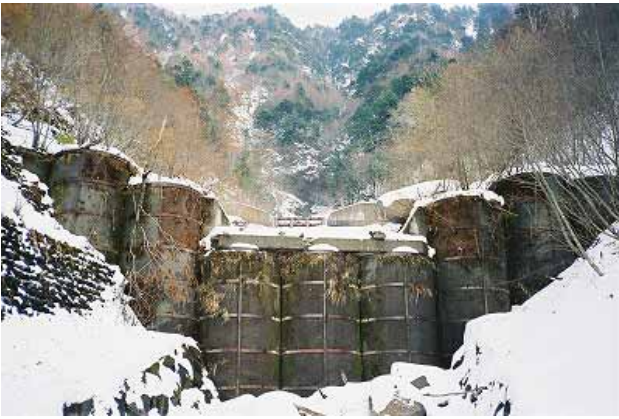
写真7.1-32 土砂を中詰め材として活用した砂防堰堤(岐阜県)
