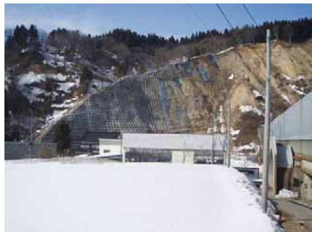
写真7.1-14 施工中の法枠工(小千谷市浦ノ山) 林野庁提供(46地点)
