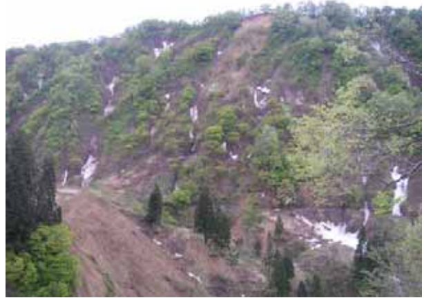
写真 4. 2-24 山腹斜面表層崩落 (種芋原05.5.16)
