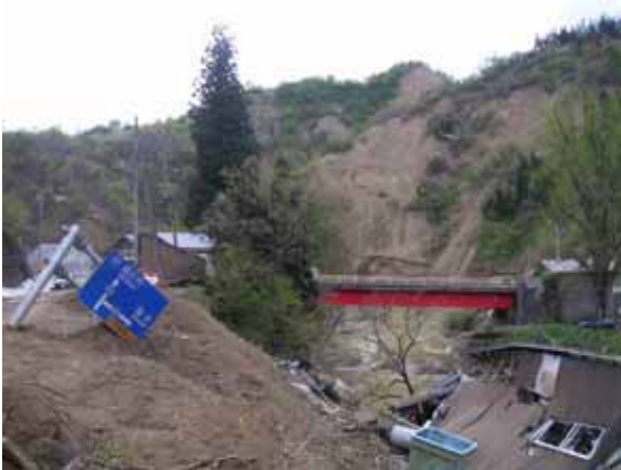
写真 4.2-15 河川斜面表層崩壊 (十二平 05.12.12)
