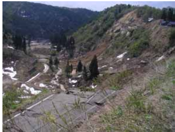
写真 4.2-4 山腹崩壊 (25地点 05.1514)
