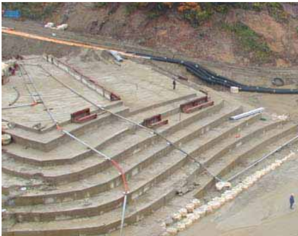
写真7.1-30 ISM工法による砂防堰堤基礎部構築状況(12地点)
