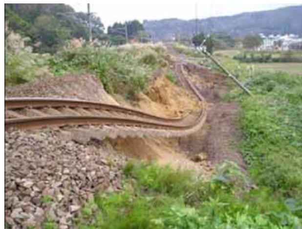
写真 3.6-8 盛土崩壊(JR 東日本提供)
