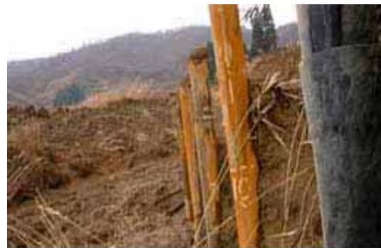
写真 3.3-22 地すべり抑止杭の被災状況
