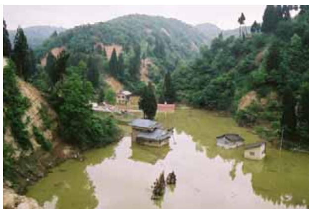
写真5.3-1 斜面崩壊による芋川の堰きとめにより水没した木籠集落(旧山古志村, 05.5.31)
