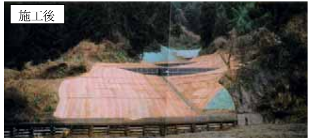
写真7.1-18 山腹工の施工箇所（西山町大坪）新潟県提供
