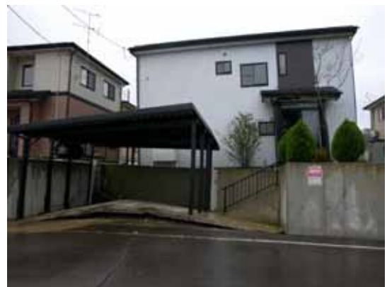
写真 3.5-6 地盤沈下によって傾斜した住宅（長岡ニュータウン）
