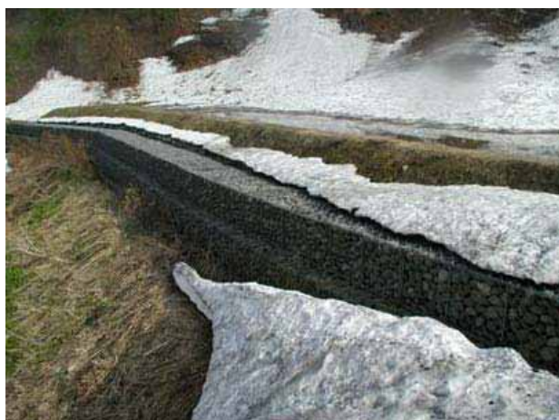
写真 3.3-32 ふとんカゴによって補強された棚田 (20 地点 : 05.05.13)
