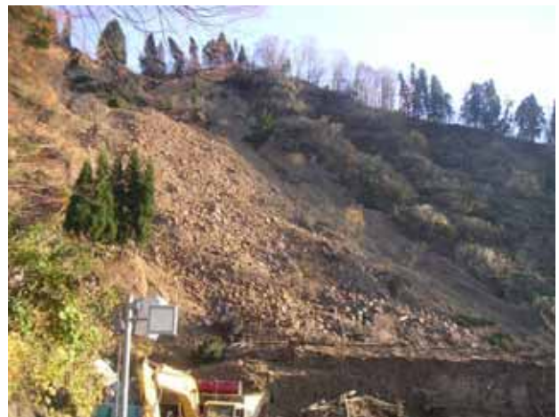
写真 4. 2-28 岩盤崩壊 (羽黒山トンネル31地点 04.11.26)
