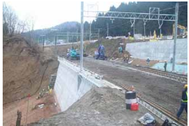
写真 7.3-2 復旧状況(59 地点：JR 東日本提供)
