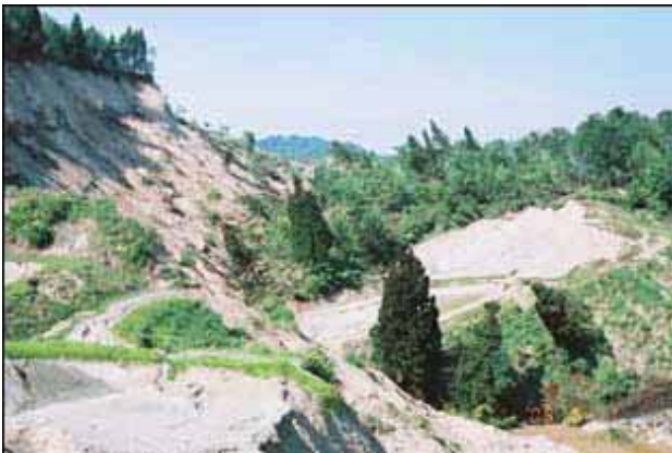
写真 3.1-3 明瞭な地すべり地形を呈する箇所 発生した地すべりの滑落崖付近の状況 (小千谷市塩沢) (65地点 : 05.6.1)
