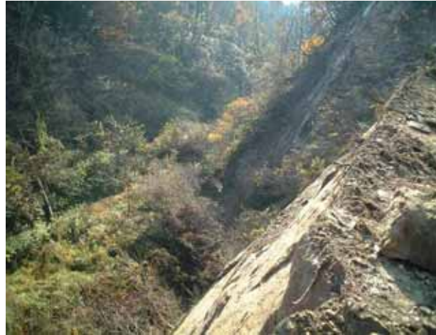
写真 4.2-16 河川斜面表層崩壊 (白岩 04.11.26)
