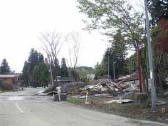
写真 4.2-8 家屋の崩壊 (梶金 05.5.1216)
