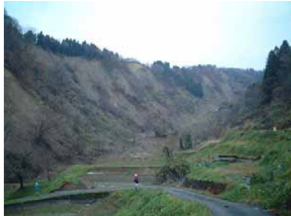
写真 4.2-12 河川斜面表層崩壊 (43 地点 小栗山 04.11.28)
