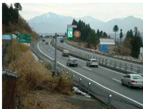
写真7.25 全線4車線確保【第四段階】
