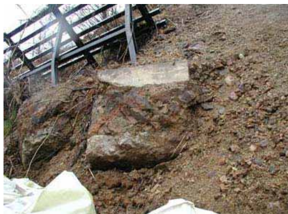
写真 3.3-42 被災した予防柵基礎部の状況 (49 地点 : 04.11.28)
