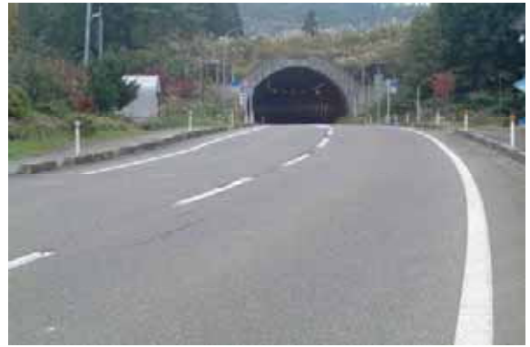
写真2.3-1A 小平尾地区の道路の変形 (19地点：04.10.30)
