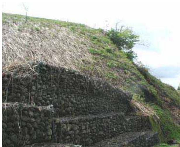
写真 3.3-30 ふとんカゴ被災状況 (49 地点 : 05.05.15)
