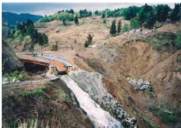
写真7.1-22 応急対策による表面排水路（寺野地区：12地点）
