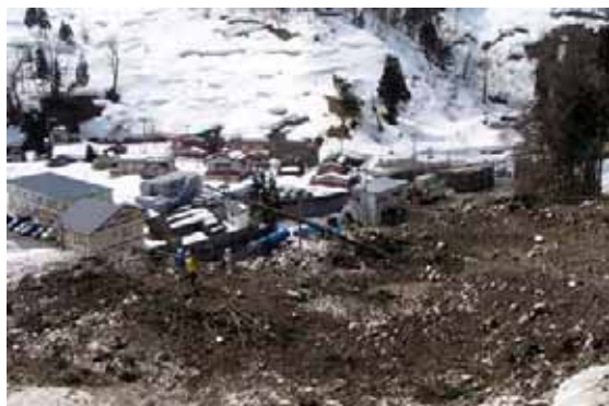
写真7.1-5 融雪期の崩壊（長岡市貫） 新潟県提供（56地点）
