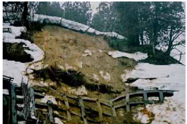
写真8.3-3 表層崩壊地における雪食の進行 (長岡市蓬平町) (50地点:05.3.23)
