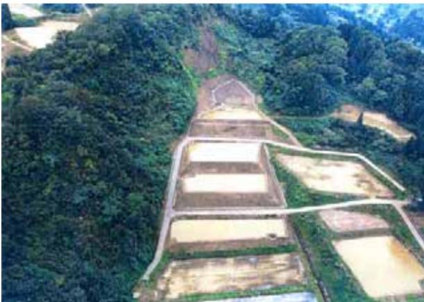
写真 3.2-3(b) 小規模地すべり（復旧後）
