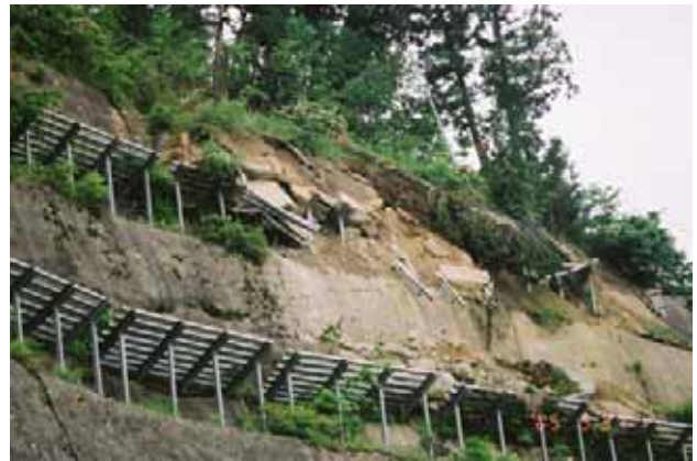
写真 3.4-8 倒壊した道路上の予防柵 (旧山古志村 05.5.31)
