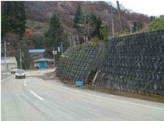
写真 3.3-18 井桁擁壁の被災状況 (36 地点 : 04.11.26)
