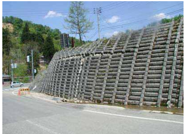
写真 3.3-21 融雪後の井桁擁壁の状況 (36 地点 : 05.05.14)
