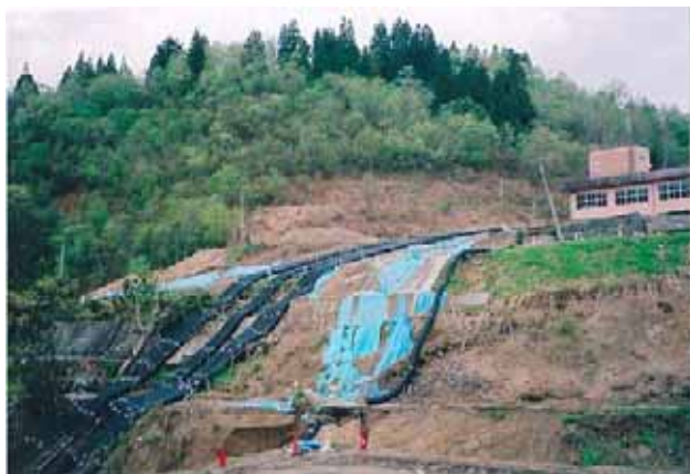
写真7.1-20 緊急対策による排水管（東竹沢地区：1地点）
