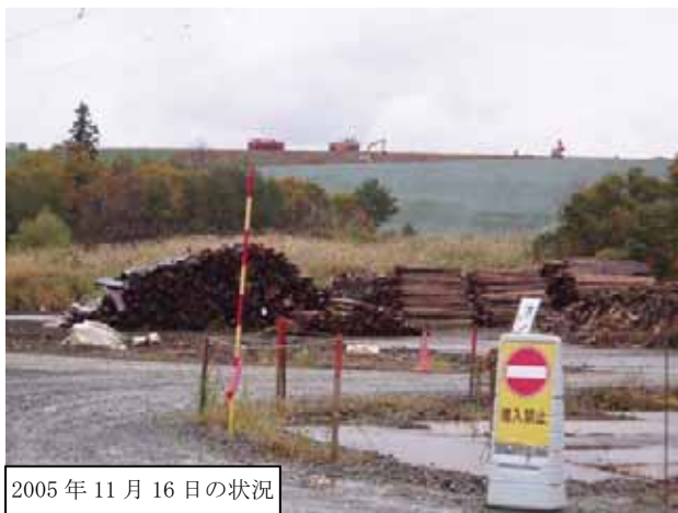
写真 6.1-8 小千谷市の解体廃棄物の仮置き場の状況 5月に比べ11月は、廃木材が減少している 様子が伺われる。
