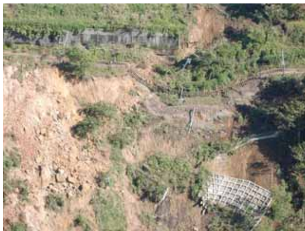
写真 3.6-4 上越線下り線の盛土崩壊 (60 地点: JR 東日本提供)
