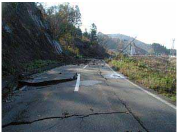
写真 3.3-1 吹付け工被災事例 (48 地点 : 04.11.26)
