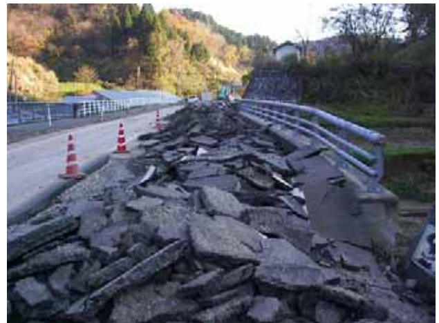
写真 6.1-9 破損したアスファルト・コンクリート (旧山古志村) (04. 11. 23)
