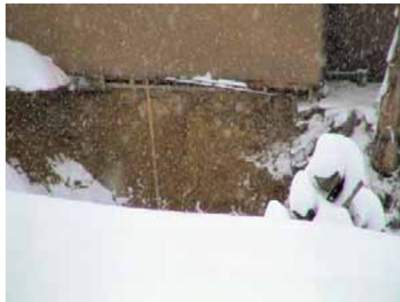
写真 7-4-3 家屋基礎部の崩壊に対しての復旧工事はあまり進んでいない。（31地点：05.12.11）
