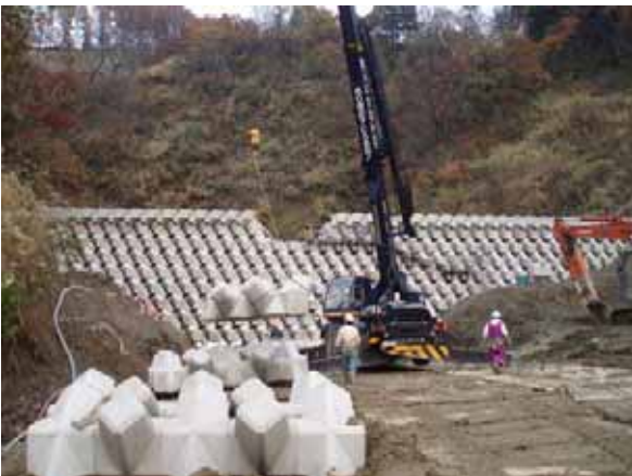
写真7.1-17 施工中の治山ダム（小国町三桶）新潟県提供 土砂流出防止のために、緊急にブロックダムを施工。
