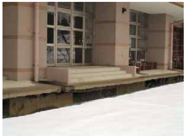
写真 3.5-14 旧山古志村役場の盛土沈下 (34 地点 : 05.12.10)
