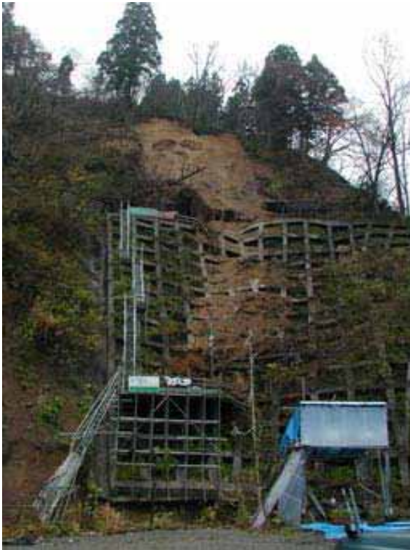
写真 3.3-8 のり枠工の効果事例 (50 地点 : 04.11.28)
