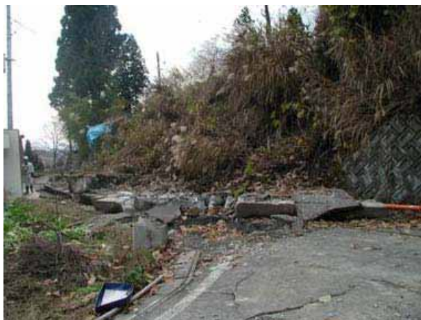
写真 3.3-12 擁壁工の被災状況 (29 地点：04.11.27)
