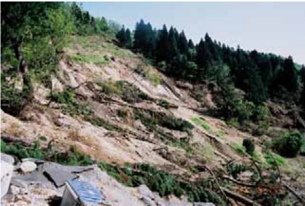
写真5.1-3 緩斜面(流盤)の地すべりの再滑動により 崩壊したスギ林(小千谷市小栗山)。(41地点:05.5.4)
