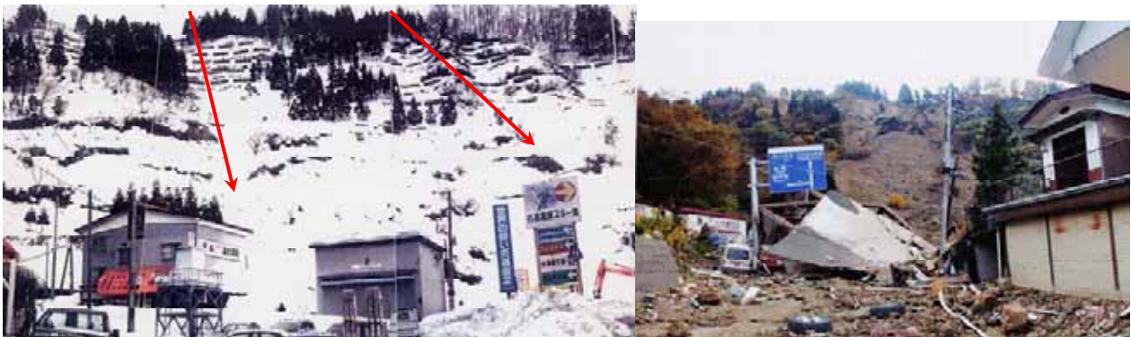
写真 3.4-4 予防柵が崩落した斜面(旧山古志村竹沢,31地点) 左:崩落前・右:崩落後 新潟県長岡地方振興局提供
