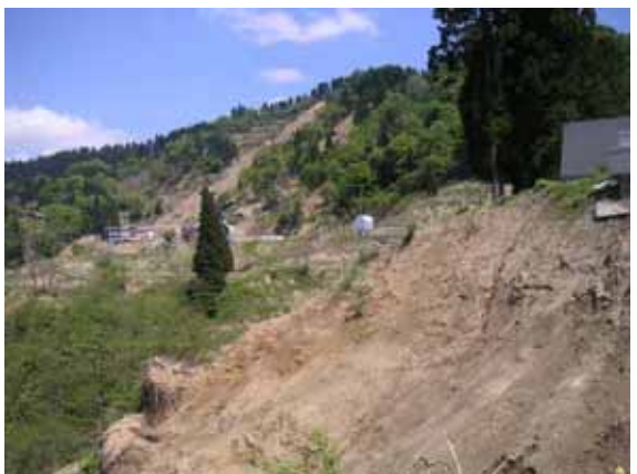
写真 4.2-7 盛土崩壊と岩盤崩壊(竹沢 05.5.14)
