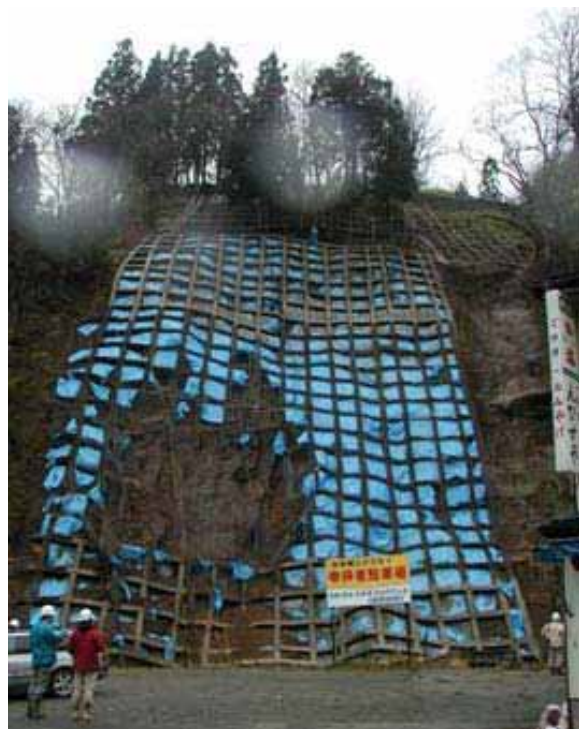
写真 3.3-7 のり枠工被災事例 (50 地点 : 04.11.28)
