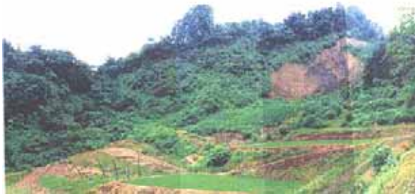
写真 3.2-3(a) 小規模地すべり（復旧前；上越市提供）
