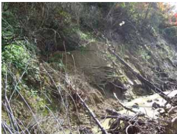
写真3.8-4 河道閉塞下流の侵食状況 (68地点付近：05. 11. 11)
