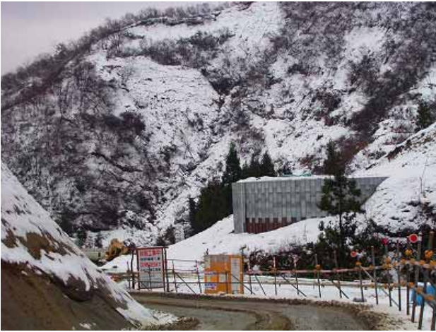
写真7.1-28 神沢川地区における砂防堰堤(鋼製セル構造)
