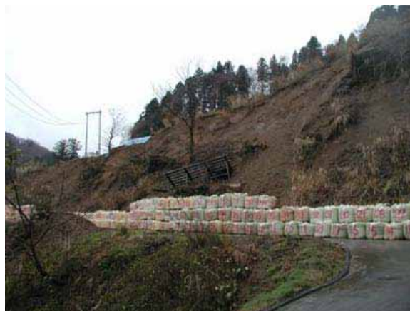
写真 3.3-41 表層崩壊で基礎ごと崩壊した予防柵の事例 (49 地点 : 04.11.28)
