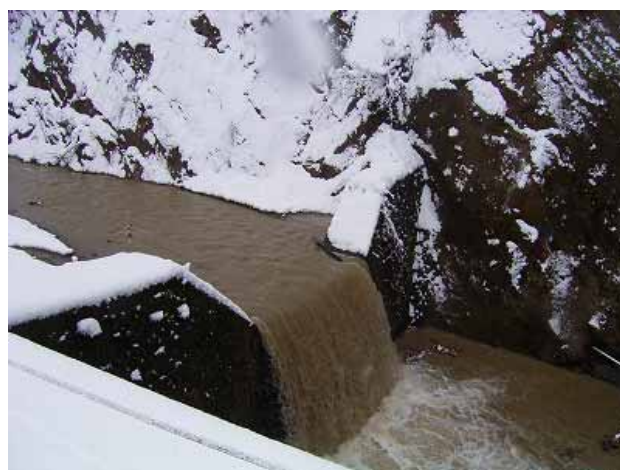
写真7.1-27 地震後約1年経過後の流水の濁流状況
