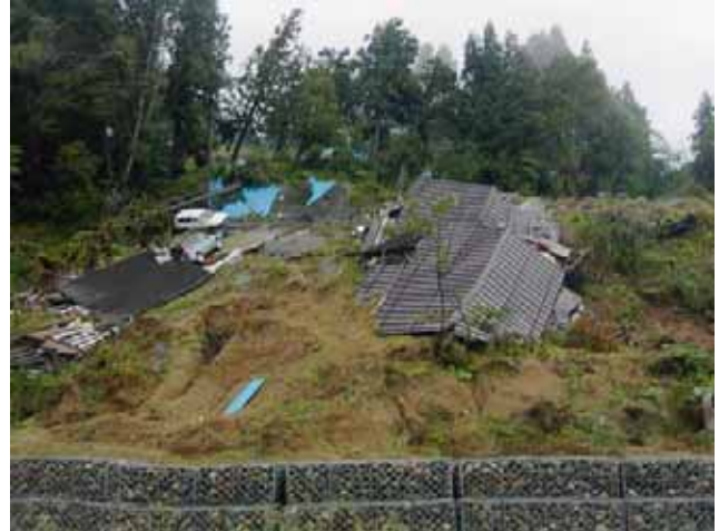
写真 3.1-13 濁沢町地内における地すべり(55 地点:05.10.8)
