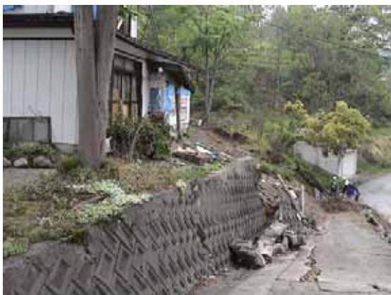
写真 3.5-7 典型的な宅地の地震被害。擁壁などの急斜面部は容易に破壊され崩壊している。2005年12月には、家屋は全て撤去されていた。(53地点：05.5.15)
