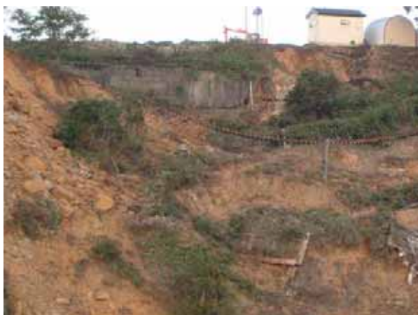
写真2.8-9 盛土部の崩壊により線路が宙吊りとなっている信越線と、不通が続く国道17号(61地点:04.10.28)
