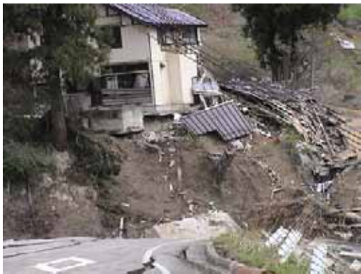
写真 3.5-11 池谷地区家屋. 盛土部の崩壊 (23 地点 : 05.5.14)
