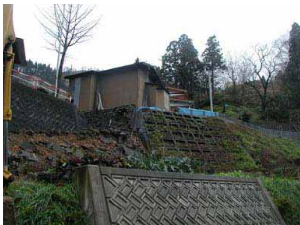
写真 3.3-15 ブロック枠工の被災状況 (55 地点：04.11.28)
