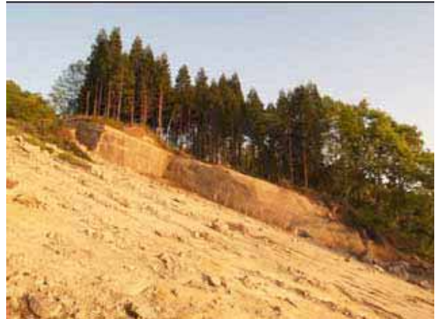
写真 3.1-4 酸化した層理面をすべり面とした岩盤すべり (小千谷市浦柄, すべり面の傾斜は約22度) (53地点 : 05.1.15)
