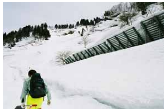
写真 2.7-3 道路/集落を守るなだれ予防柵 (旧山古志村竹沢, 05.3.21)
