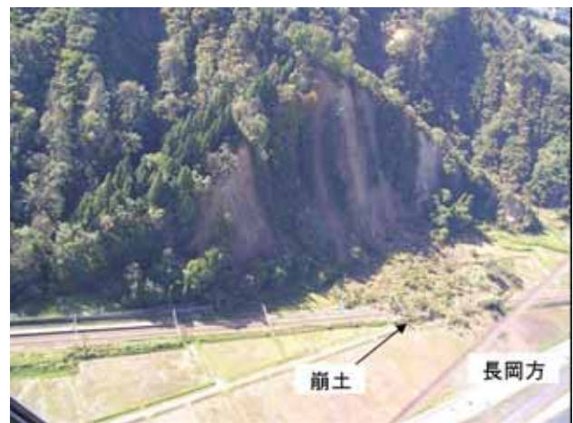
写真 3.6-1 斜面表層崩壊全景(62 地点: JR 東日本提供)
