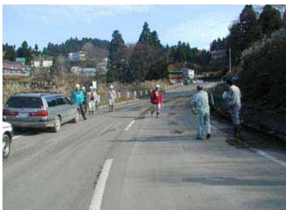
写真 3.3-25 ジオテキスタイルによる補強盛土の状況 (35 地点 : 04.11.26)
