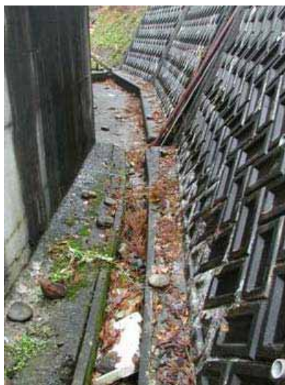
写真 3.3-16 飛散した間詰め石 (55 地点：04.11.28)
