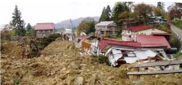
写真7.1-12 人家の被害状況(旧山古志村竹沢)新潟県提供
