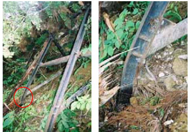
写真 3.4-9 崩土の衝突により部材が変形した予防柵 (旧山古志村竹沢) (31 地点 : 05.5.31)
