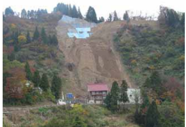
写真7.1-13 施工中の崩壊地(旧山古志村竹沢) 新潟県提供 (31地点)
