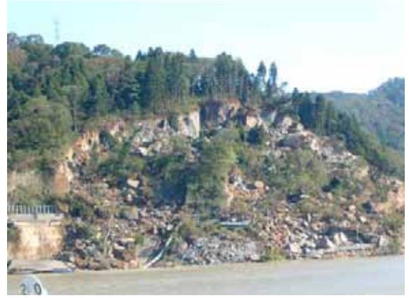
写真 2. 5-7 白岩での尾根の道路切土法面の岩石崩壊現場。 埋まった女の子の救出が続いていた (47 地点 : 04.10.28)
