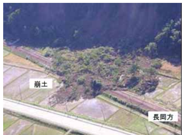
写真 3.6-2 斜面崩壊による崩土の到達状況(62 地点: JR 東日本提供)
