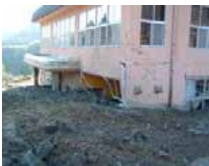
写真 2.8-2 地すべりの流動化した土砂による東竹沢小学校の被害状況 (1 地点 : 04.10.29)
