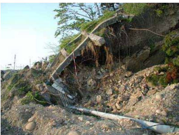
写真 3.3-4 のり枠工の被災事例 (48 地点 : 04.11.26)
