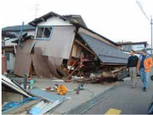
写真 2. 8-4 小千谷市上村付近の盛土地盤での家屋の倒壊 (04. 10. 28)
