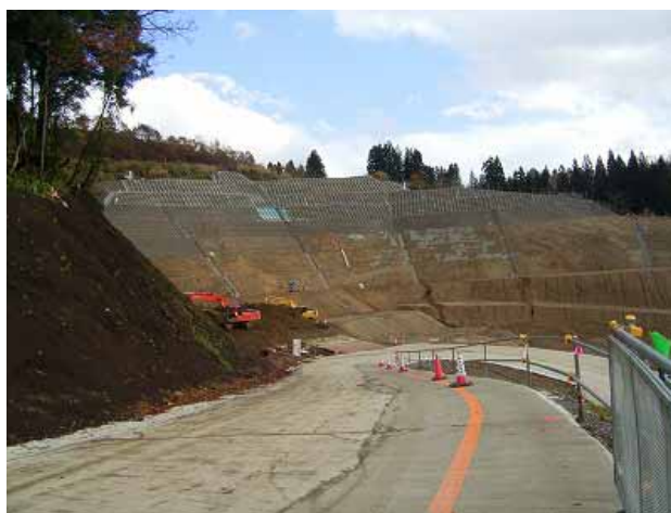
写真7.1-23 寺野地区における地すべり頭部のり面工（12地点）
