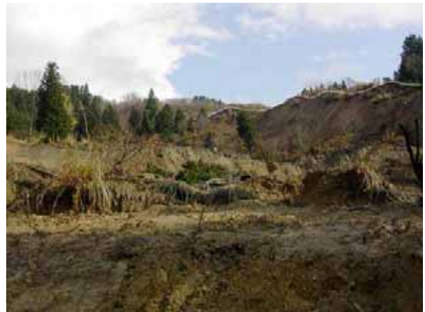
写真 3.1-10 左岸の寺野地すべりの滑落崖 (白色の点線が滑落崖)(12地点:04.11.20)
