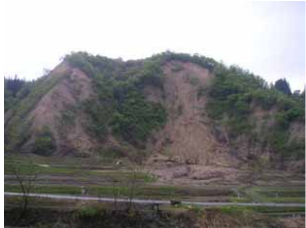
写真 4.2-10 段丘斜面崩落 (北堀之内 05.5.15)
