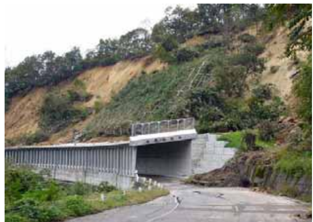
写真 3.3-6 のり枠工の被災事例 (62 地点 : 東京電機大学安田教授提供)
