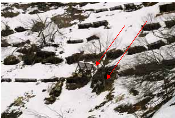
写真 3.4-7 表層崩壊により崩落した予防柵 (長岡市濁沢町) (56 地点:05.3.27)
