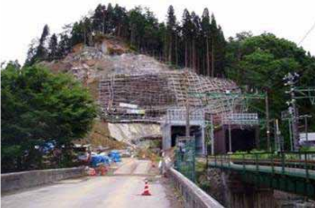
写真 7.3-3 格子枠工による復旧状況 (47 地点：JR 東日本提供)
