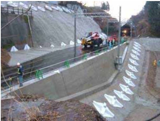
写真 7.3-1 復旧状況(61 地点：JR 東日本提供)
