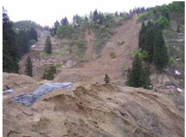
写真8.4-2 棚田・山腹斜面崩壊 (梶金 05.5.14)
