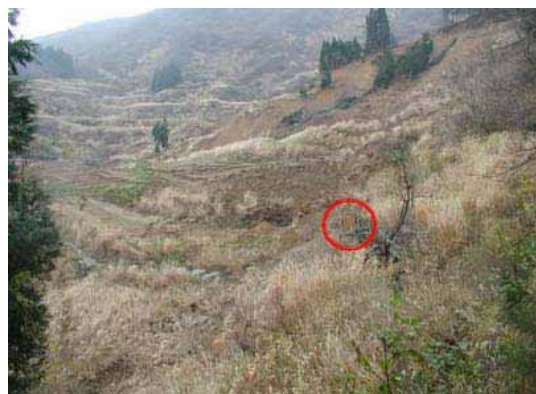
写真 3.3-23 上記抑止杭含む地すべり全景 (8 地点 : 04.11.27)
