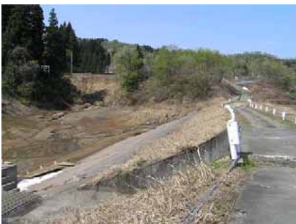
写真 3.2-1 (a) 被災ため池：ため池の漏水 (川口町)
