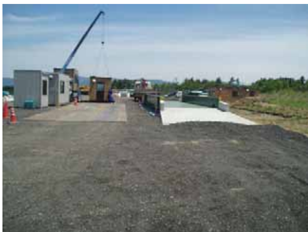
写真 6.2-1 長岡市西部丘陵地の解体廃棄物仮置き場の計量器 (05. 5. 20)
