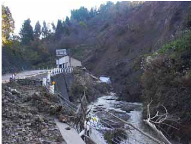
写真 6.1-11 崩壊によって発生した土砂や倒木 (旧山古志村) (04. 11. 23)
