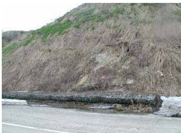
写真 3.3-31 ふとんカゴ被災状況 (23 地点 : 05.05.14)
