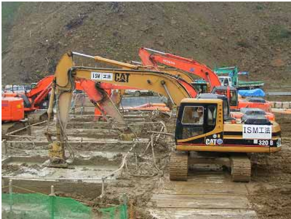
写真7.1-29 砂防ソイルセメント製造状況(ISM工法：12地点)
