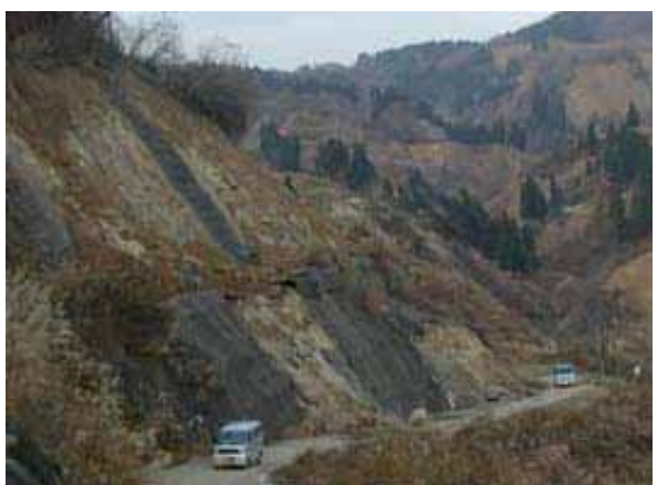
写真 3.3-2 吹付け工被災事例 (25 地点 : 04.11.26)
