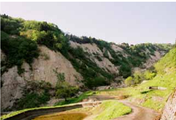
写真5.1-4 急斜面(受盤)の広葉樹低木林に発生した 表層崩壊(小千谷市小栗山)。(43地点:05.5.14)
