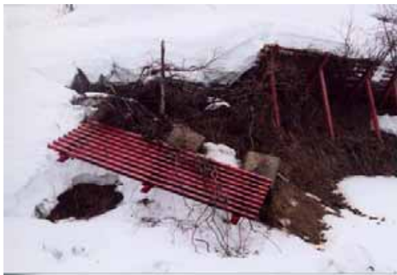
写真 3.4-1 被災した予防柵(38地点: 05.323)
