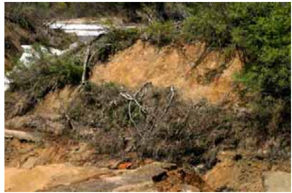
写真5.1-11 崖地辺縁部の植生が滑落，冬の積雪で枯死している例。土砂の崩落量は少ない。 (旧山古志村東竹沢43地点：05.5.14)
