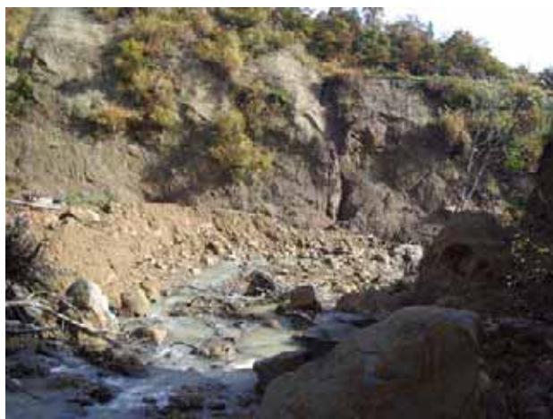
写真3.8-5 河道閉塞箇所から流出した土砂の堆積状況 (68地点付近：05. 11. 11)
