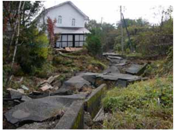
写真 3.5-4 谷埋め盛土地すべりの末端部（鶴ヶ丘団地）(04.10.30)
