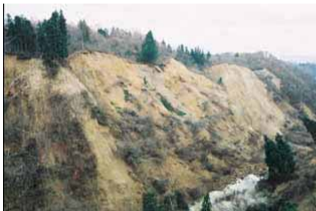
写真 3.1-1 表層崩壊(旧山古志村大久保 28地点：04.11.26)
