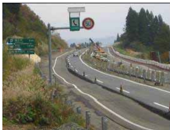
写真7.24 片側1車線での通行止め解除【第三段階】
