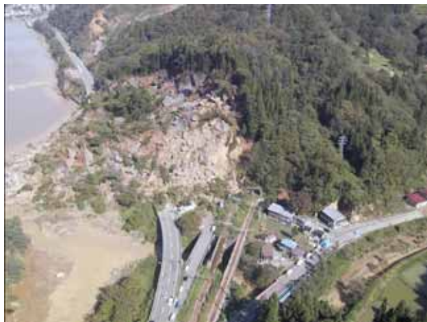
写真 3.6-6 榎峠トンネル上方の斜面崩壊全景 (47 地点：JR 東日本提供)
