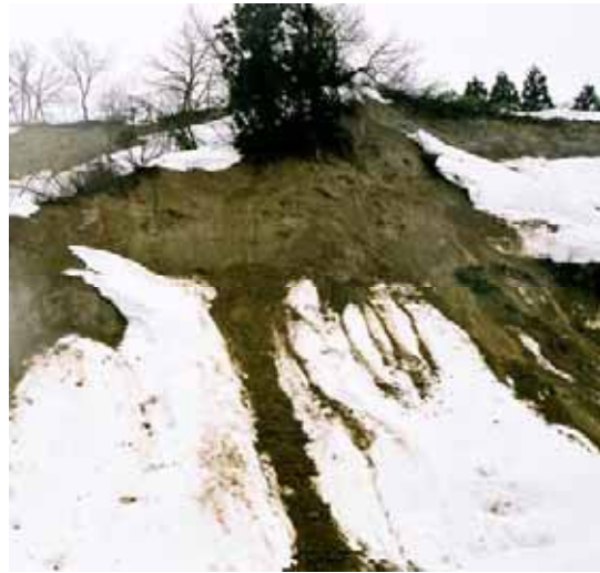
写真8.3-2 融雪期における表層崩壊地の侵食（小千谷市首沢05.3.23）雪面上に流下した土砂が堆積している。
