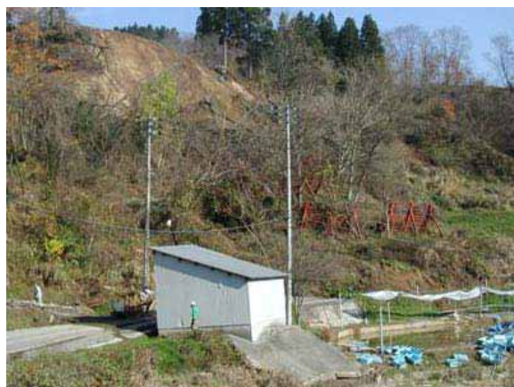
写真 3.3-36 深いすべりによって土塊ごと移動した 予防柵の被災事例 (44 地点 : 04.11.26)
