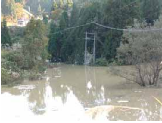
写真 2. 8-3 山古志村芋川での地すべり崩土による堰止め湖の出現 (2 地点 : 04. 10. 29)
