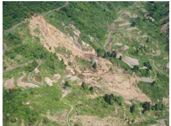
写真7.1-8 深層崩壊地の全景（旧山古志村風口） 林野庁提供
