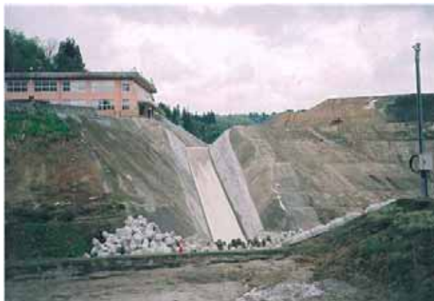
写真7.1-21 応急対策による表面排水路（東竹沢地区：1地点）
