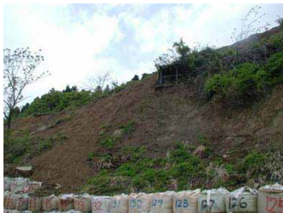
写真 3.3-43 融雪後の同一現場の状況 (49 地点 : 05.05.15)
