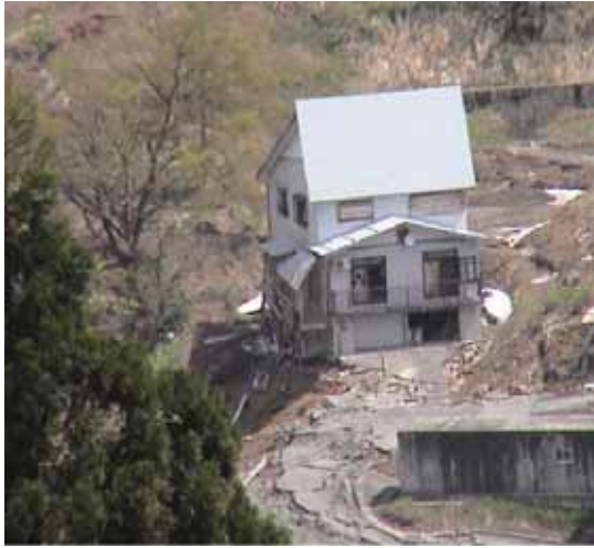
写真 3.5-10 楢木集落内の斜面肩部の崩壊 (05.5.14)
