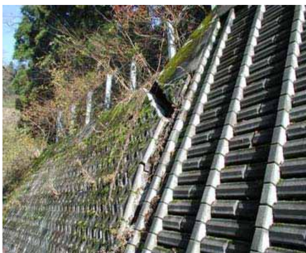
写真 3.3-14 ブロック積み擁壁の被災状況 (44 地点：04.11.27)
