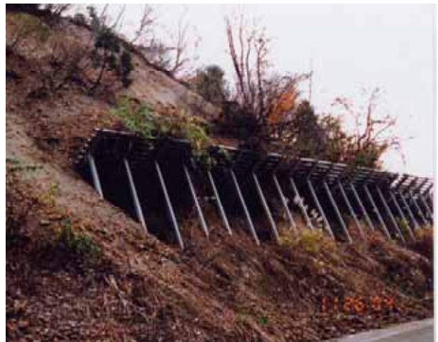
写真 3.4-14 崩土が堆積した予防柵 (旧山古志村竹沢) (32地点: 04.11.26)
