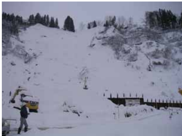
写真 4. 2-46 (羽黒トンネル 31 地点 05.12.11)
