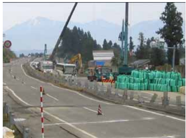
写真 7.2-3 緊急車両の走行を確保【第二段階】
