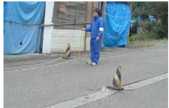
写真2.3-2A 小平尾地区の道路の変形その2 (18地点：04.10.30)
