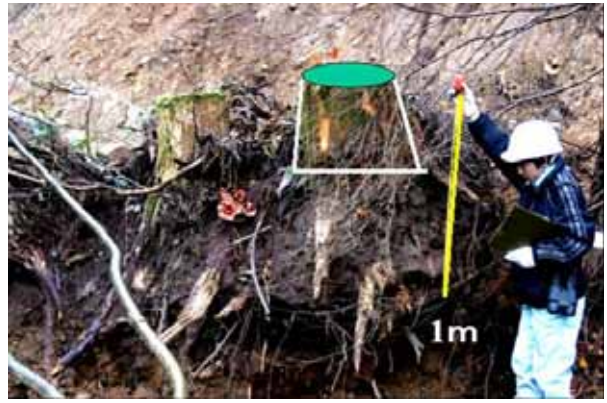
写真 5.2-2 崩落したスギの根茎 (小千谷市小栗山 04.11.15)
