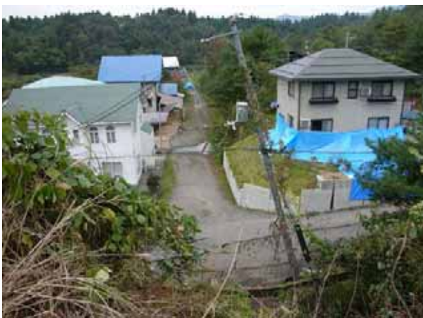
写真 3.5-3 鶴ヶ丘団地における谷埋め盛土地すべり (04.10.30)
