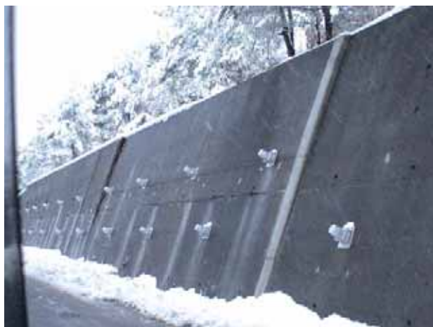
写真7-4-2 高町団地へ昇る道路沿いの擁壁は、背後の盛土が変動したため、アンカー工で対策してある。（66地点：05.12.10）
