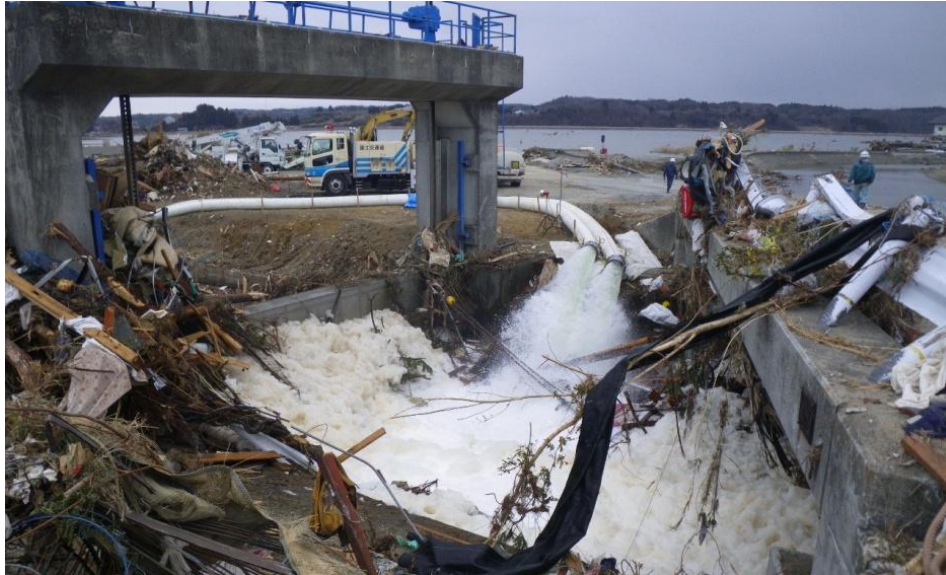
図 7 : 国土交通省のポンプ車による排水作業
