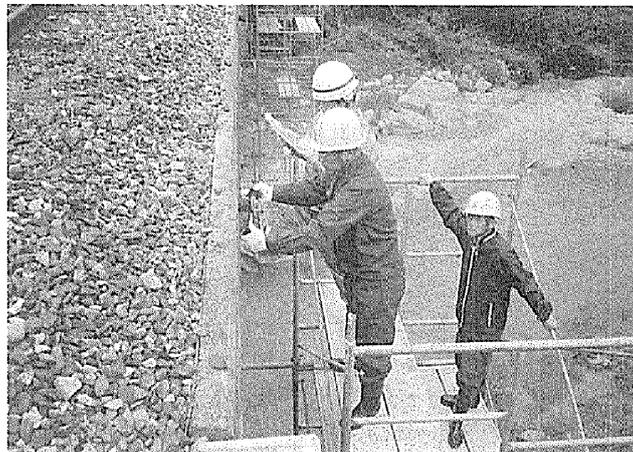
写真 2.3.6 第一大戸川橋梁 PC 桁のクリープ測定
