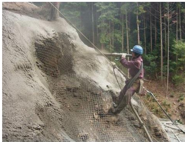
図 4.1.2-3 モルタル・コンクリート吹付工の例
