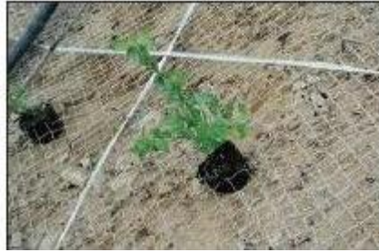
図 4.1.1-9 苗木設置吹付工（山取苗吹付工法）の例
