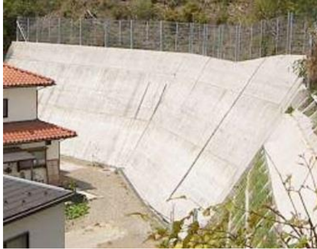
図 4.1.2-5 コンクリート張工の例
