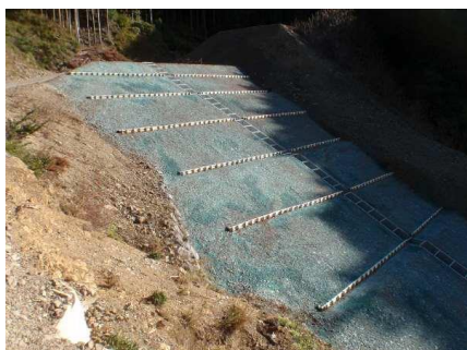
図 4.1.1-1 種子散布の例
