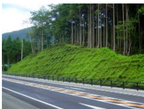
図 4.1.1-7 植生土のう工の例
