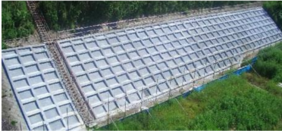
図 4.1.2-7 現場打ちコンクリート枠工の例
