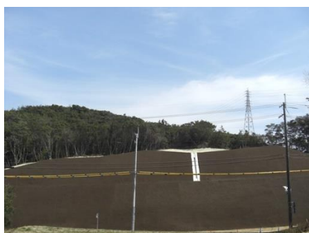
図 4.1.1-3 植生基材吹付工の例
