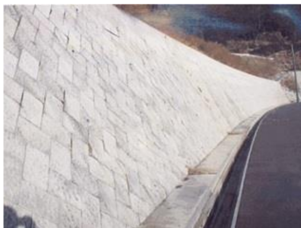
図 4.1.2-4 ブロック石張工の例
