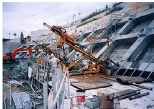
図 4.1.2-8 グラウンドアンカー工の例
