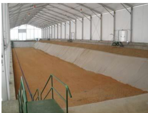
(2) エルカブルル処分場
