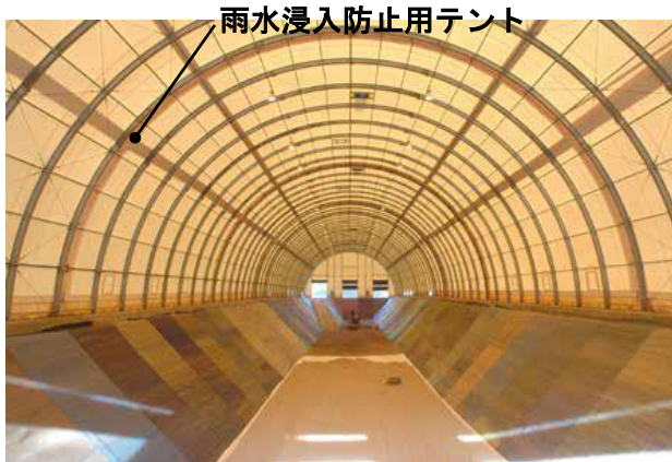
(1) 埋設施設内部
