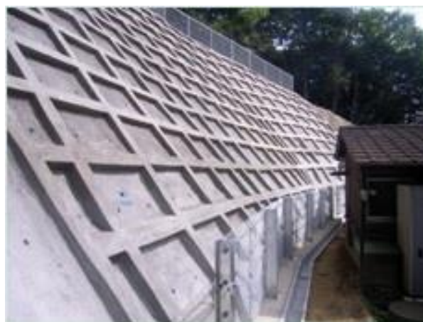
図 4.1.2-6 吹付砕工の例
