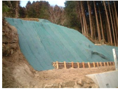
図 4.1.1-5 植生シート工の例
