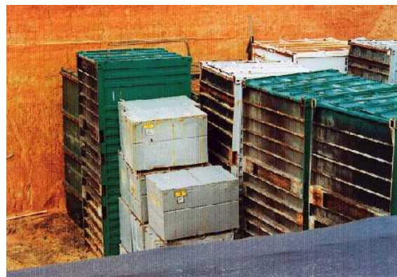
(5) Class A 廃棄物処分 (20 フィートコンテナ／鉄箱)
