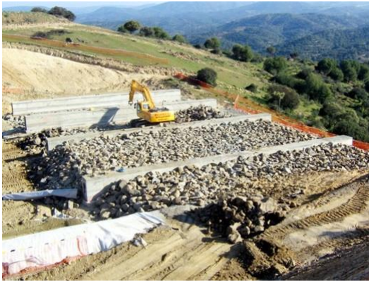
(3) 砕石層、浸出水排水管設置
