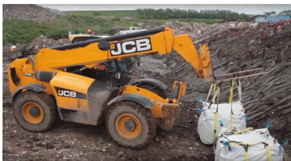
(1) フレコン定置 (トレンチ)
