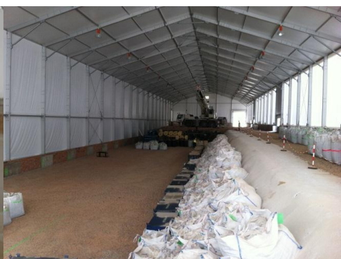
(4) VLLW 処分場シェルター内
