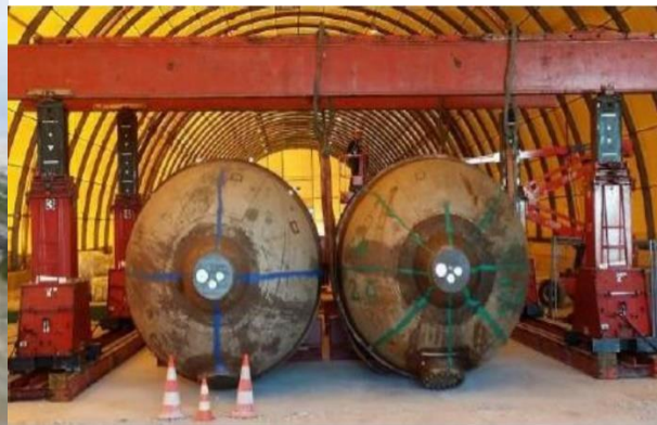
(8) 蒸気発生器定置
