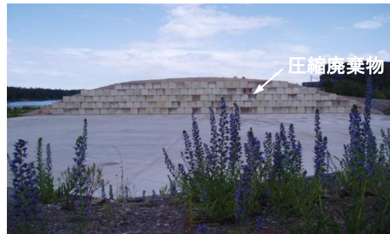
(4) 廃棄物定置状況
