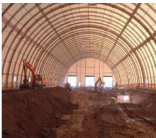
(1) トレンチの掘削
