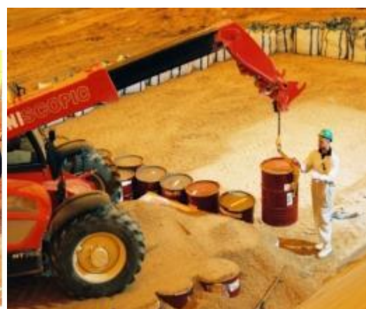
(4) ドラム缶廃棄物の定置作業
