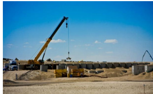
(2) コンクリート容器収納廃棄物埋設
