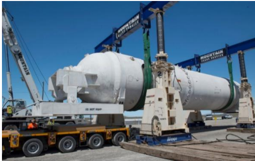
(5) 大型機器一体埋設
