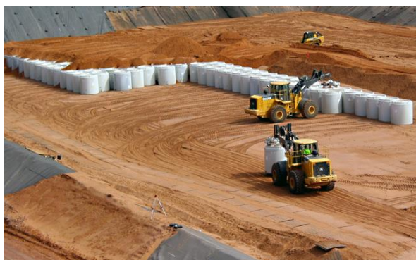
(3) 副産物処分施設
