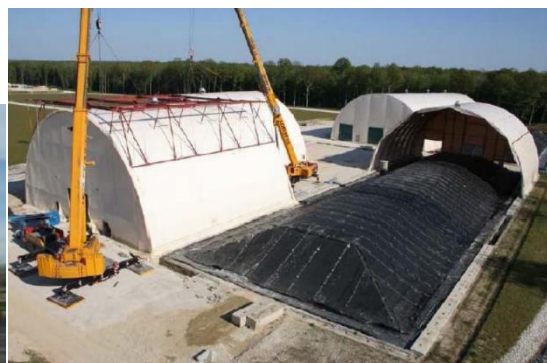
(10) 覆土後のテント移設作業
