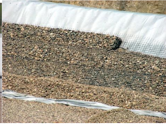
(6) 砕石排水層、底部及び法面
