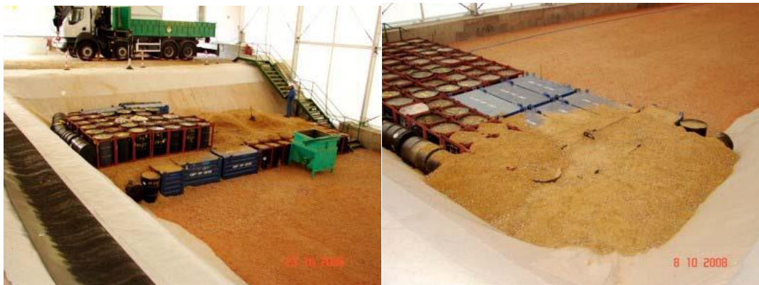
(1) 廃棄物定置状況
