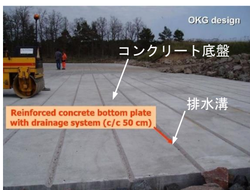
(1) 鉄筋コンクリート底盤
