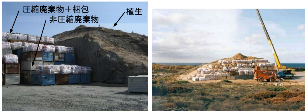
(1) 廃棄物定置状況
