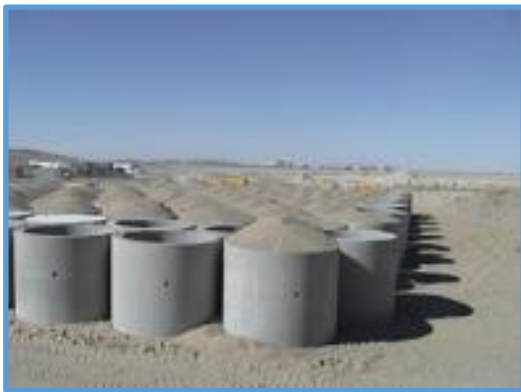
(3) コンクリート容器収納廃棄物埋設
