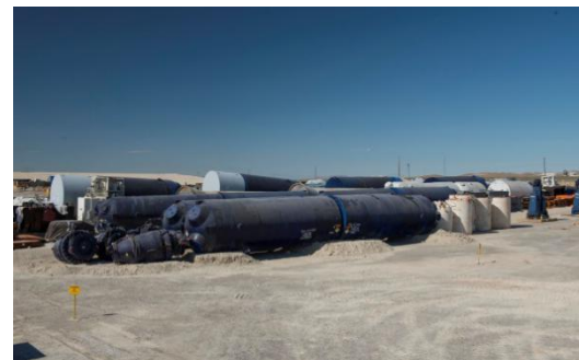
(6) 大型機器一体埋設
