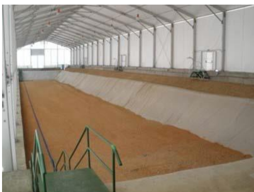
(3) VLLW 処分場シェルター内
