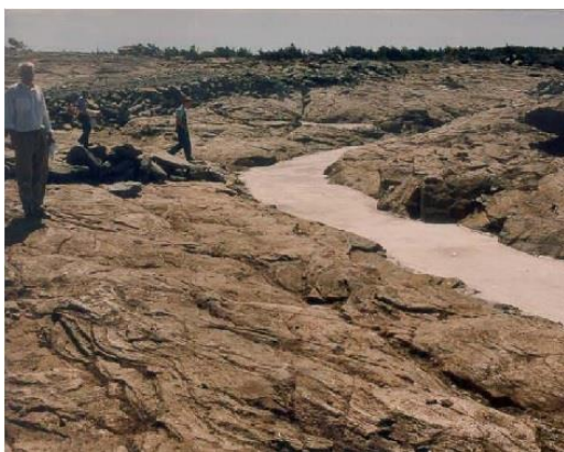
(1) 処分場底部・施工前（岩盤）
