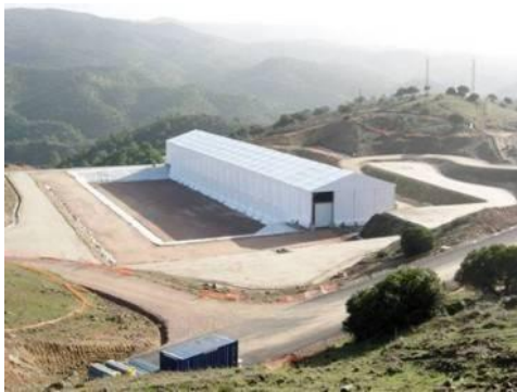
(1) VLLW 処分場全景
