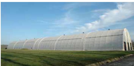
(9) 雨水浸入防止テント設置状況
