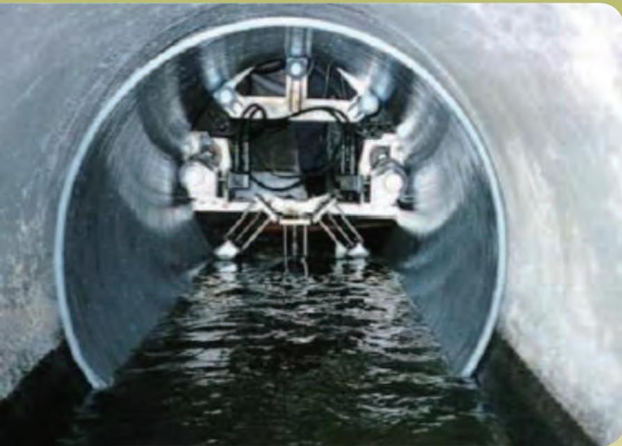
更生工法による下水道管の修繕と改築
