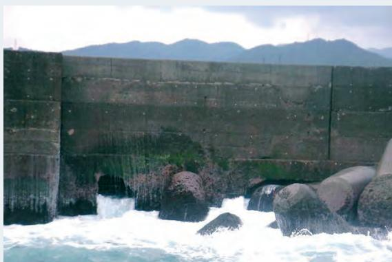
防波堤の損傷（ケーソン側壁の穴あき）
