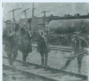
ビータによるバラスト突き固め
