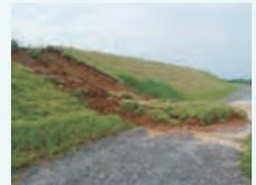
雨水の堤防への浸透に起因して法崩れが発生した様子。堤防機能が支障が生じており、直ちに措置を要します。
