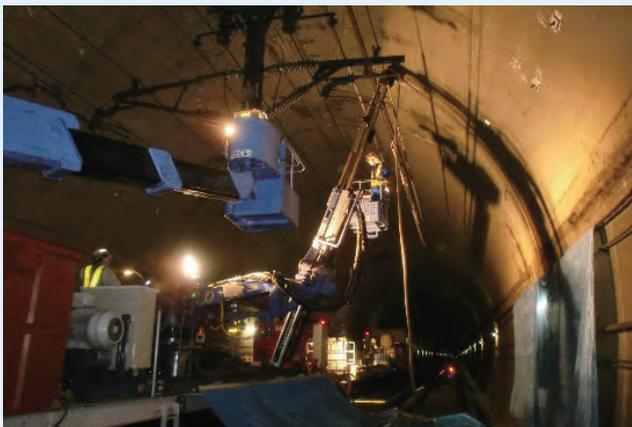
終列車～初列車の時間帯でのトンネル補強状況
