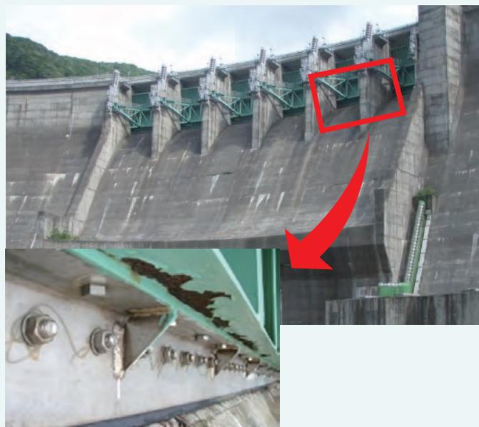
非常用放流設備（クレストゲート）の老朽化による腐食状況の事例。このままでは腐食が進行し、構造物の機能に支障が生じる可能性があるため、早期に措置をすることが望まれます。
