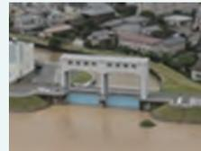
洪水時の水門。本川の水位が高くなった際に、水門を閉鎖することで、本川の洪水を支川に逆流させないようにしています。
