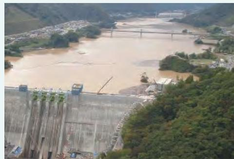
令和元年台風第19号で洪水を貯留したハツ場ダム。台風第19号では、利根川上流ダム群（矢木沢ダム、奈良俣ダム、藤原ダム、相模ダム、園原ダム、下久保ダム、試験湛水中のハツ場ダム）で約1.45億立方メートルの洪水を貯留し、利根川の基準地点八斗島の洪水位を約1m低下させ、治水効果を発揮しました。
