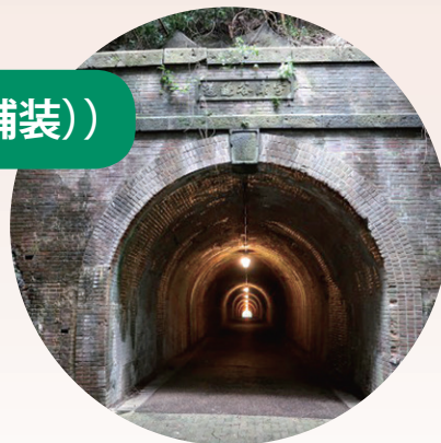
宇津ノ谷隧道(静岡県・明治9年竣工)
