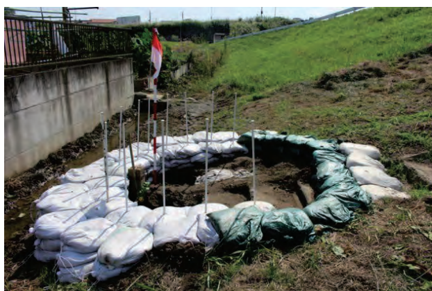
図5.1-9 漏水対策地点の状況 4)
