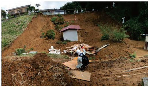
写真7.1-4 ②崩壊斜面状況（正面）
