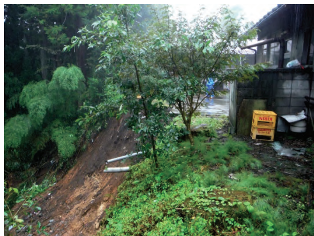
写真7.1-12 被災箇所の様子
