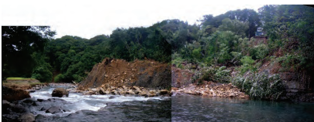
写真7.1-19 Bブロック末端部の河道閉塞箇所
