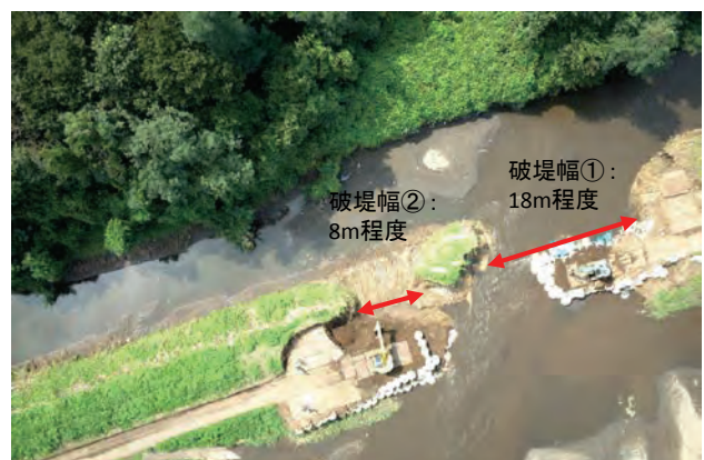
図4.5-2 西仁連川における破堤点状況（島状地形）
