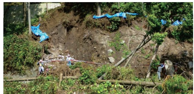
写真7.1-8 崩壊斜面の状況（起点側）
