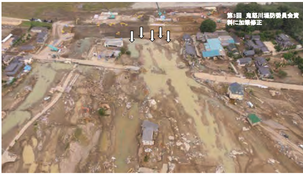
図4.5-5 注目した堤防長手方向の落掘
