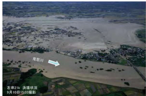
破堤地点付近の浸水状況 (9月10日15:03撮影) 7)
