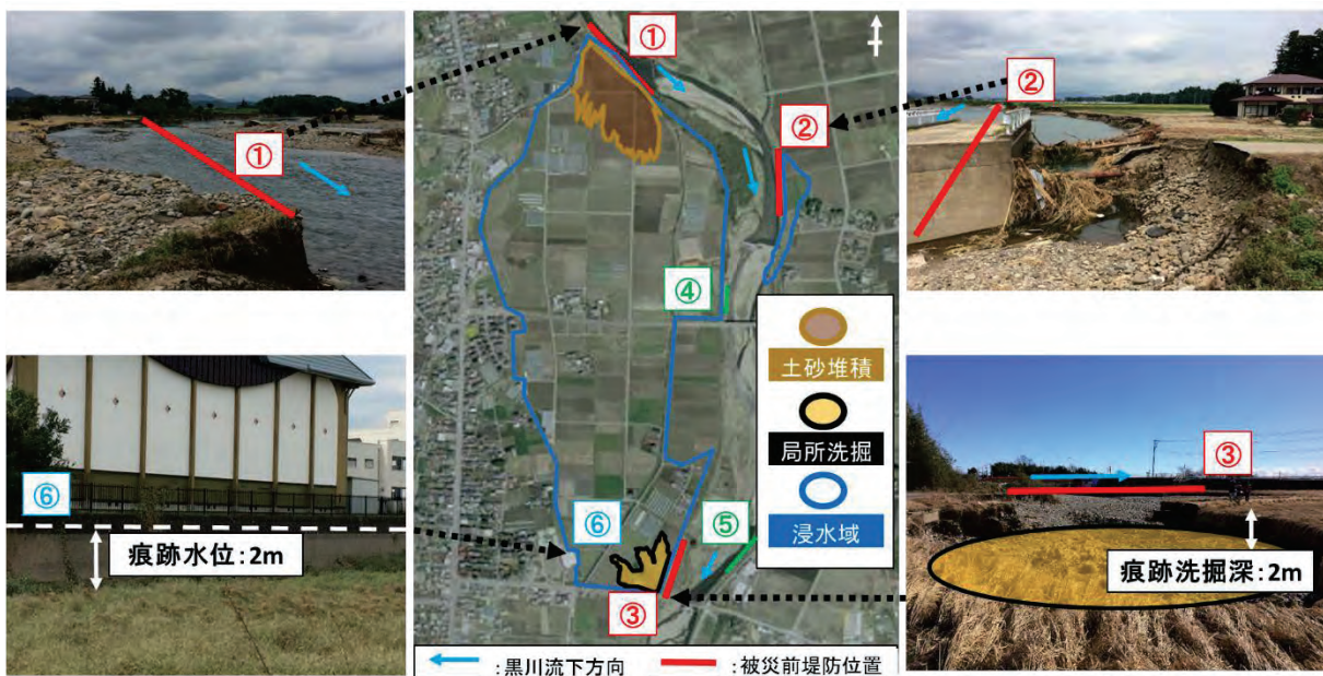
図5.2.(3)-3 現地調査による黒川奈佐原地区水害の概況(中央全体図の番号と左右状況写真の番号を対応表記)
