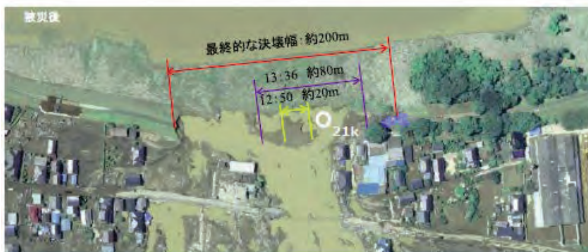
図 4.3-6 破堤幅の時間変化（国交省関東地方整備局 4) ）
