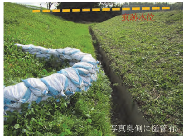
図 4.1-8 裏のり面の冠水状況 (38.17k 右岸)
