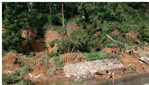
写真7.1-32 No.6: 斜面崩壊, 鹿沼市板荷(調査日 2015年9月11日)
