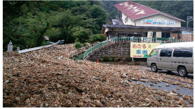
写真7.1-37 No.11: 風化岩斜面の崩壊先端部, 日光市鬼怒川温泉滝 (調査日 2015年9月11日)
