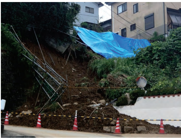
写真7.1-14 被災箇所の様子
