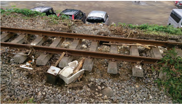
写真7.1-35 No.9: 線路路盤の洗掘被害, 日光市鬼怒川温泉大原 (調査日 2015年9月11日).
