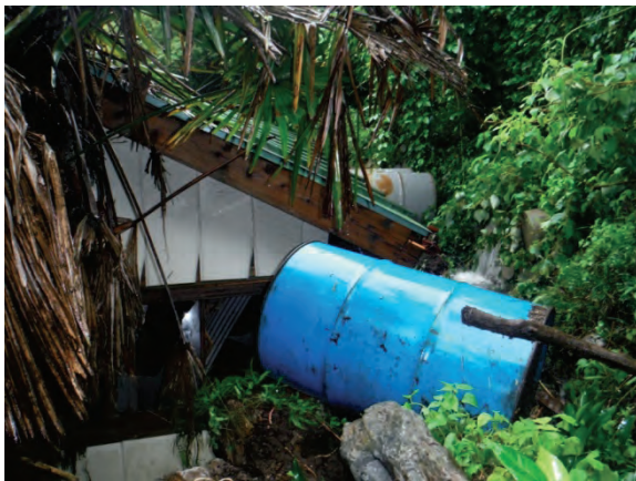
写真7.1-1 鉢木沢 斜面崩壊状況(写真1)
