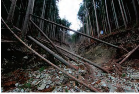
図 7.2.1-6 中坪上沢の溪流出口付近から上流方向
