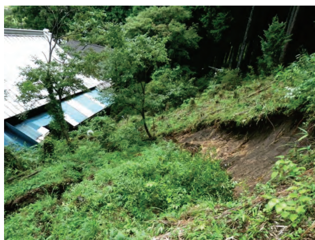
写真7.1-13 被災箇所の様子
