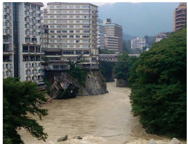
写真7.1-39 No.13: 河岸侵食による建物被害, 日光市鬼怒川温泉滝 (調査日 2015年9月11日).
