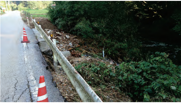
写真7.1-34 No.8: 道路のり面の被害, 日光市千本木 (調査日 2015年9月11日).
