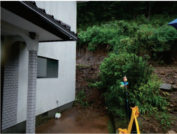
写真7.1-20 家屋被災の様子
