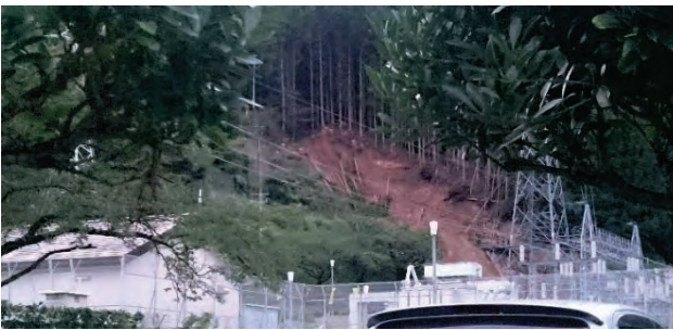
写真7.1-36 No.10: 斜面崩壊, 日光市鬼怒川温泉滝 (調査日 2015年9月19日)
