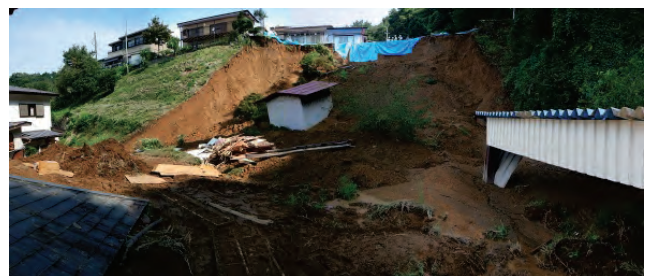
写真7.1-3 ①崩壊部全景
