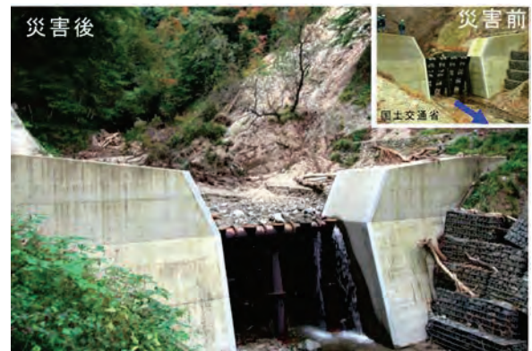
図 7.2.1-5 発生した土石流を捕捉した透過型堰堤の例 (芹沢地区の上流、田茂沢第2砂防堰堤)
