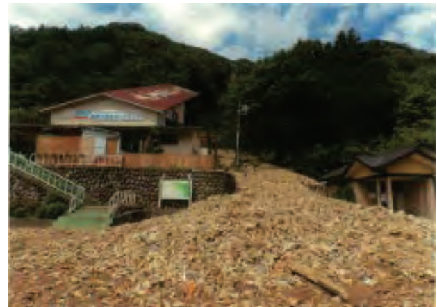
写真7.1-22 被災箇所の様子
