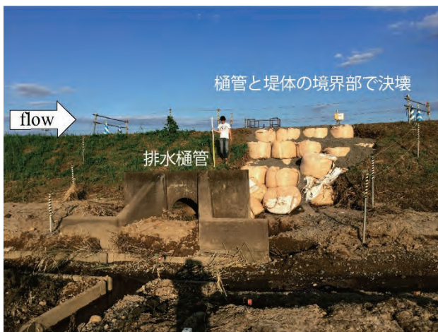
図5.1-6 飯沼川における決壊地点の状況
