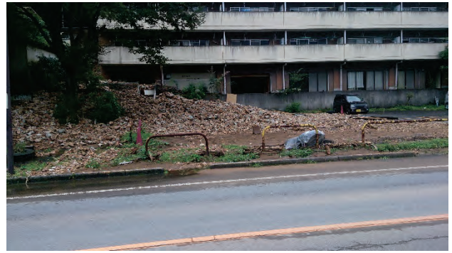
写真7.1-38 No.12: 風化岩斜面の崩壊先端部, 日光市鬼怒川温泉滝 (調査日 2015年9月19日).
