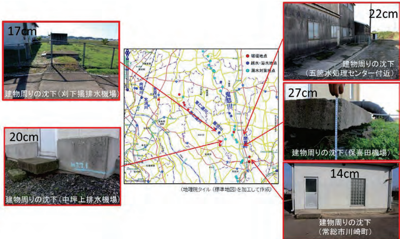
図 4.2-2 地盤沈下に伴う建物周りの沈下の様子
