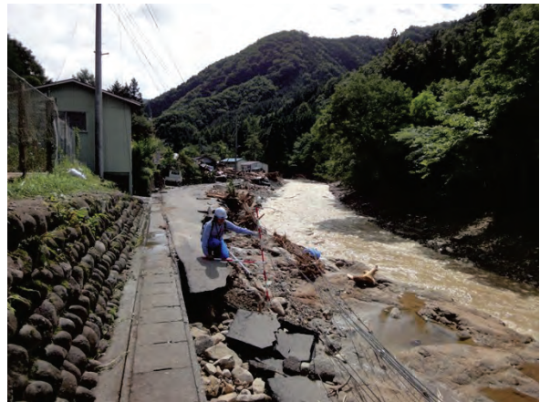
(b) 滝向沢から中坪下沢までの間の溪岸侵食
