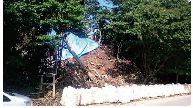
写真7.1-43 No.17: 斜面崩壊部の応急復旧状況, 日光市藤原 (調査日 2015年9月19日).
