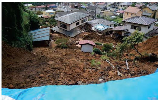
写真7.1-7 ⑤保全対象被災状況
