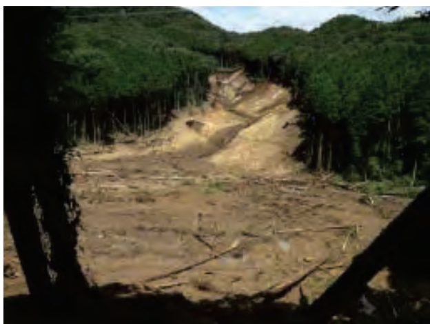
写真7.1-25 山腹崩壊地(図7.1-14中の㉒)
