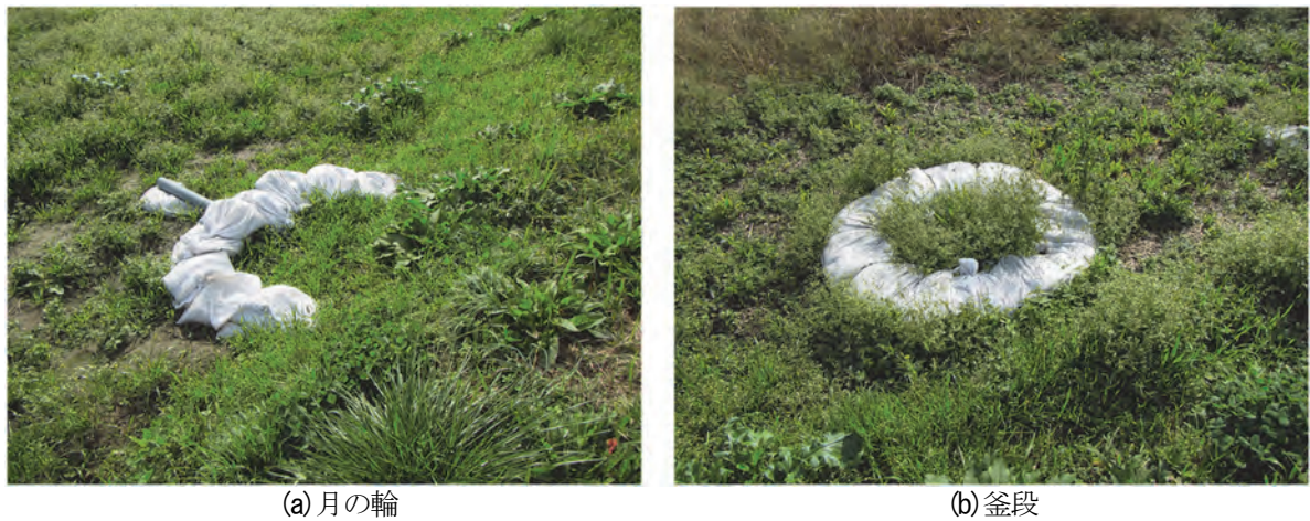
図 4.1-5 漏水対策 (20.15k 左岸)
