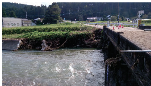
写真7.1-31 No.5 河川堤防の洗掘, 鹿沼市板荷(調査日 2015年9月11日)
