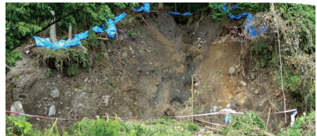
写真7.1-9 崩壊斜面の状況（終点側）
