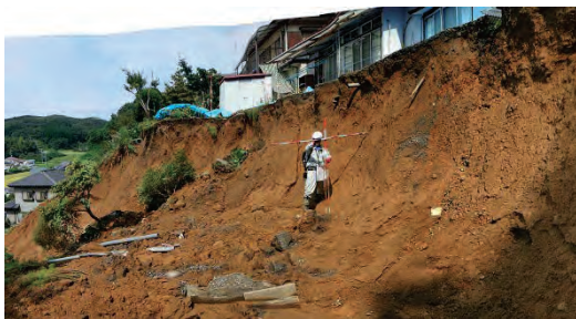
写真7.1-6 ④頭部状況
