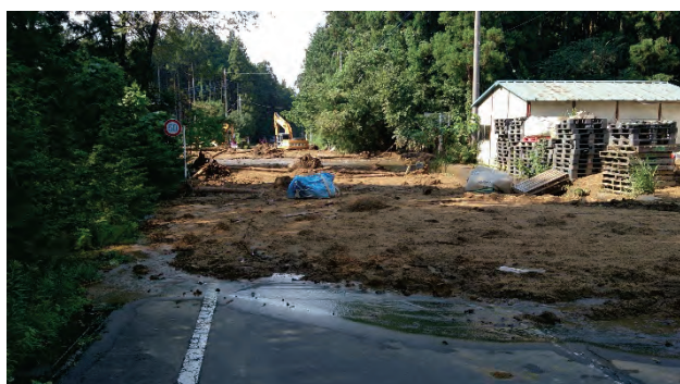
写真7.1-28 No.2: 土石流による道路の閉塞, 日光市岩崎(2015年9月11日)
