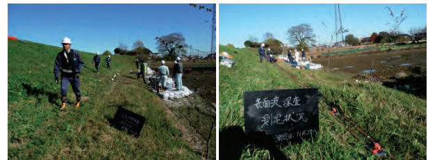
牽引式電気探査
