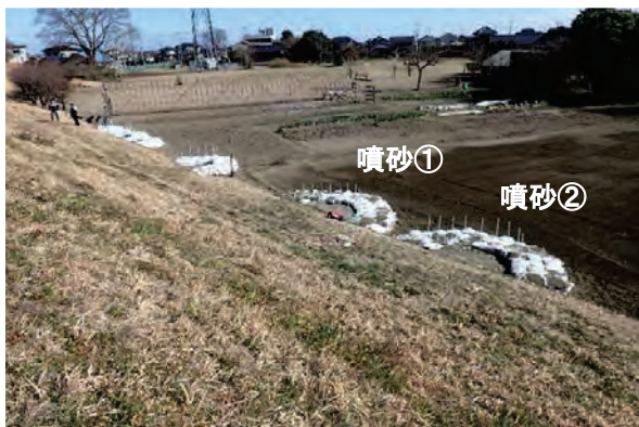
図4.4-2 漏水区間の月の輪（手前の2つは噴砂有り）
