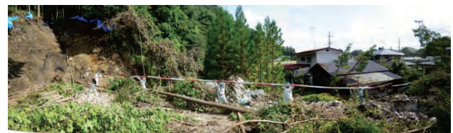
写真7.1-10 末端部の押し出し（終点側）
