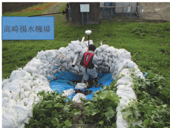
図 4.1-7 揚水機場近傍の月の輪 (37.5k 右岸)
