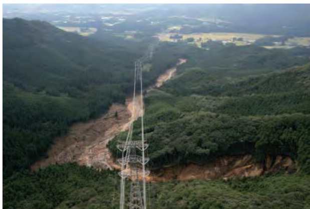
写真7.1-24 森林崩壊状況(図7.1-14中の㉑)
