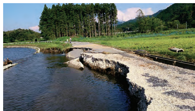
写真7.1-30 No.4: 道路及び河道の洗掘, 日光市岩崎(調査日 2015年9月11日)
