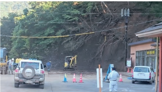
写真7.1-42 No.16: 斜面崩壊後の復旧状況, 道の駅湯西川付近 (調査日 2015年9月19日).
