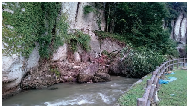
写真7.1-27 No.1: 岩盤の崩壊, 宇都宮大谷景観公園 (調査日 2015年9月12日)
