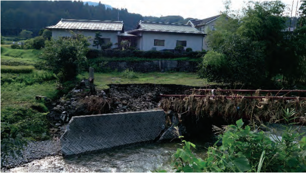
写真7.1-33 No.7: 河川堤防の洗掘, 鹿沼市板荷 (調査日 2015年9月11日)
