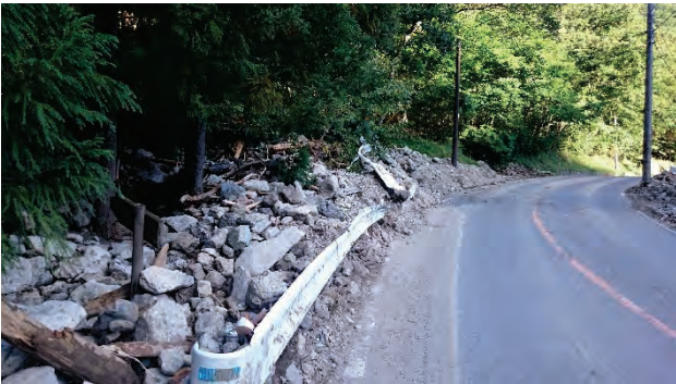
写真7.1-41 No.15: 斜面崩壊先端部, 川治ダム側道 (調査日 2015年9月19日).
