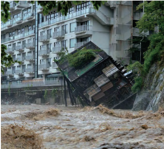
写真 5.2. (1)-1 鬼怒川 (ホテル施設崩落) 4)
