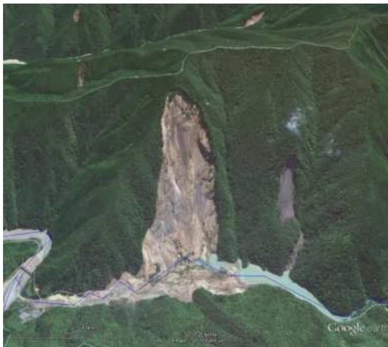
写真 4-1-2 赤谷地区崩壊全景（Google earth, 撮影日：2011.9.8）
