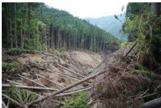
写真 7-4-3 せき止め部下流の崩壊状況
