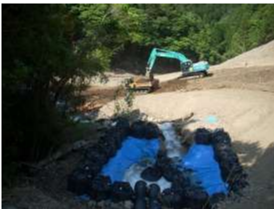
（栗平地区：排水部のシートの押えとしての利用）
