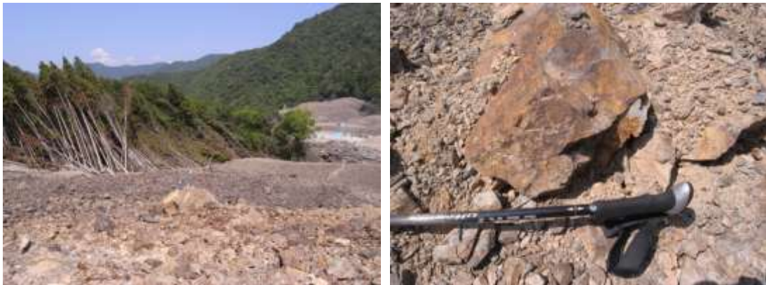
写真 6-2-2 左：崩積土と倒木群右：崩積土
