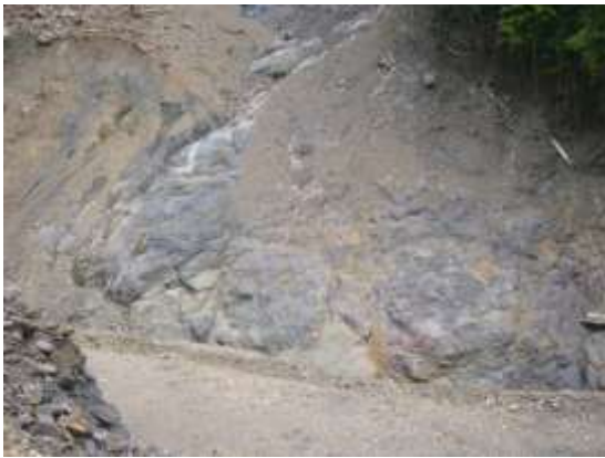
写真 7-2-3 崩壊斜面末端部の露岩
