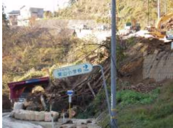
写真 8-2-1 発生土砂をフレコンバックに詰めて応急的押えにした例（新潟県中越地震）
