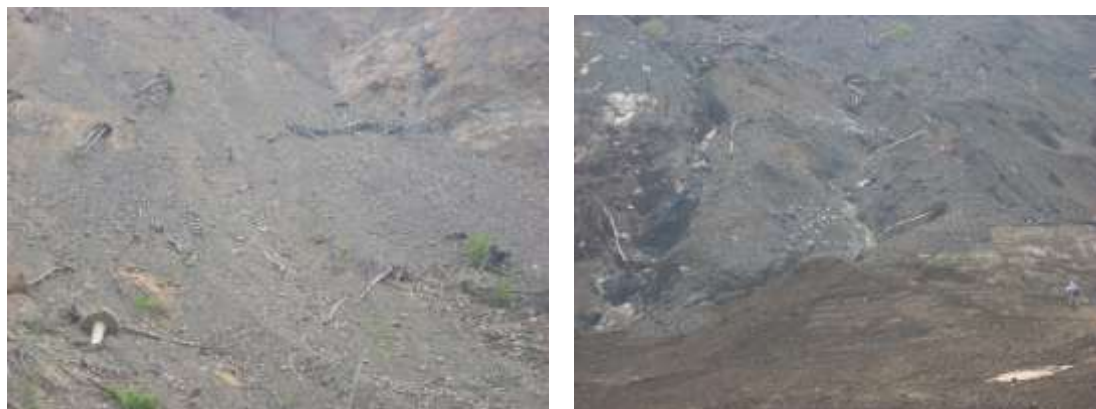
写真 8-1-1 倒木を含んだ災害発生土(左：長殿地区、右：赤谷地区)
