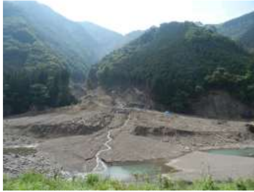
写真 7-1-1 小原沢からの土石流による土砂流出状況
