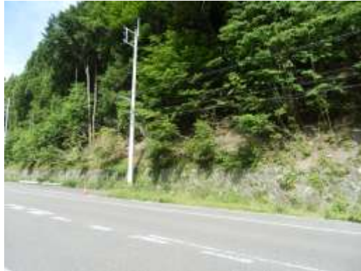
写真 7-1-3 国道 168 号の山側斜面にある洪水の流下痕跡
