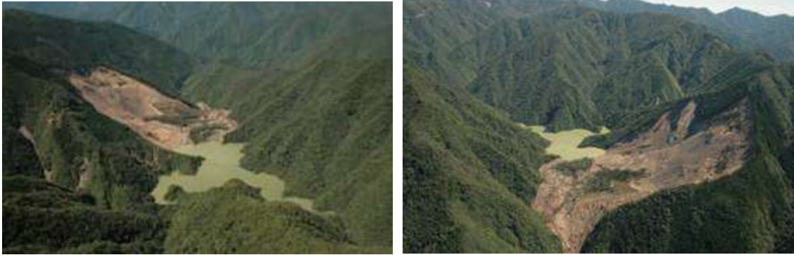
写真 6-1-2 栗平地区崩壊状況（国土交通省近畿地方整備局 12) より，平成 23 年 9 月 23 日撮影，左：上流，右：下流）
