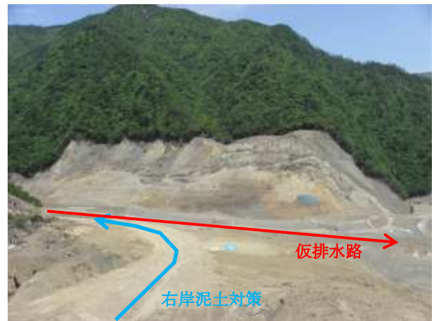
写真 4-3-2 崩壊地对岸遠景
