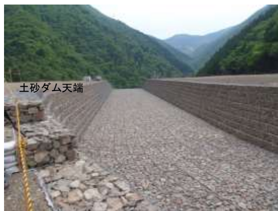
写真 5-1-5 土砂ダム(仮)排水路の上流側
