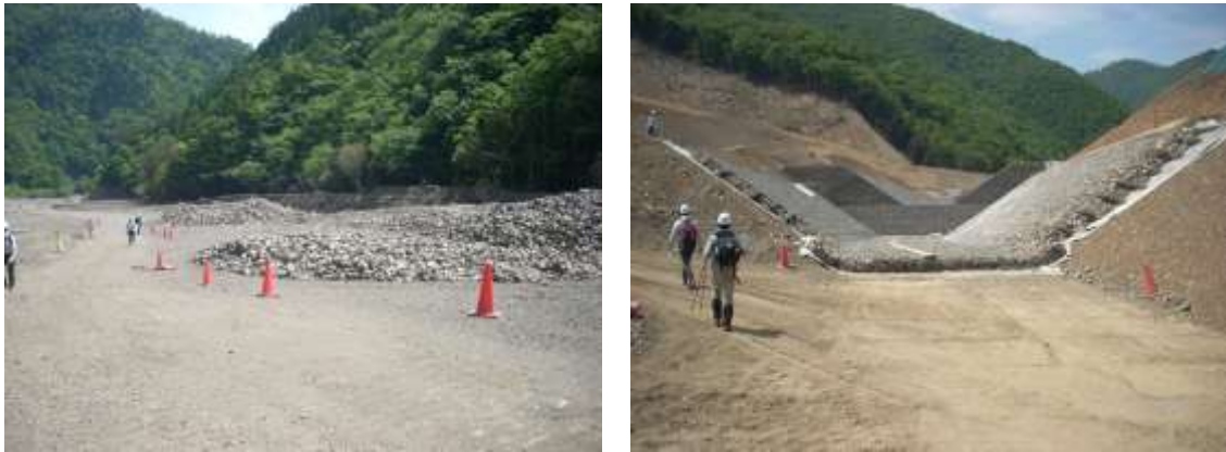
写真 8-3-4 数十 cm 以上の礫を分別仮置きしている状況(左)と数十 cm 以上の礫による蛇籠(右) (赤谷地区)
