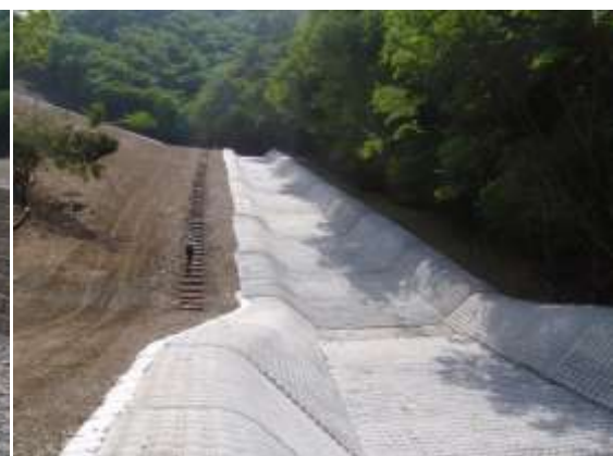
写真 5-1-6 土砂ダム(仮)排水路の下流側
