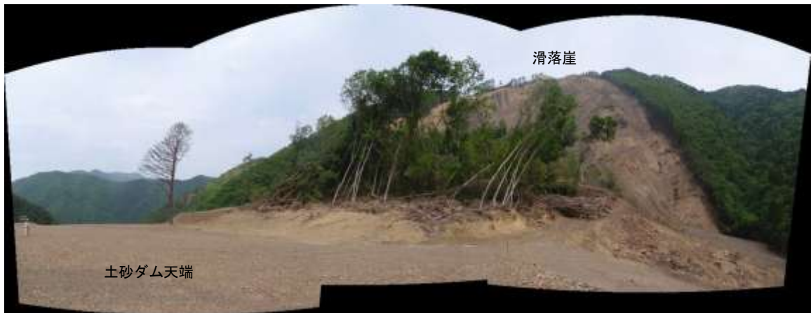
写真 5-1-2 土砂ダム天端
