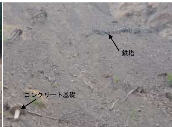
写真 5-1-4 大規模崩壊に巻き込まれた鉄塔の残骸
