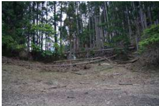
写真7-4-2 湖側からのせき止め部分で破堤していない
