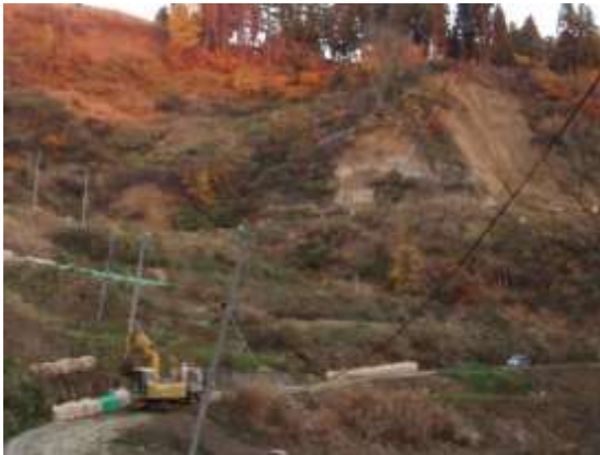
写真 8-2-1 発生土砂をフレコンバックに詰めて応急的押えにした例（新潟県中越地震）
