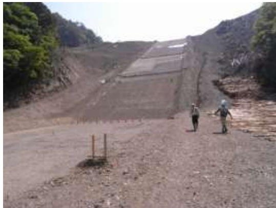
写真 6-4-1 仮排水路 (斜面部, 下方より)
