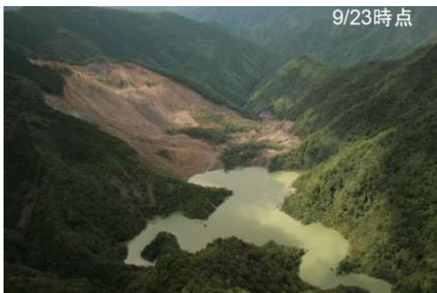
写真 6-1-1 栗平地区崩壊状況（土木研究所土砂管理グループ 13) より、平成 23 年 9 月 23 日撮影)
