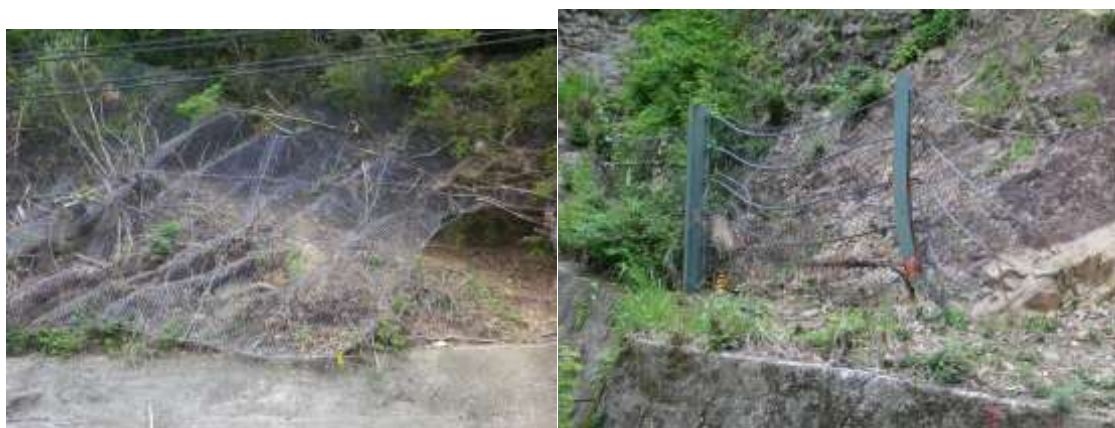
写真 7-3-2 発電所上方法面の対策工が上流側に流された跡がある（左側が上流側）
