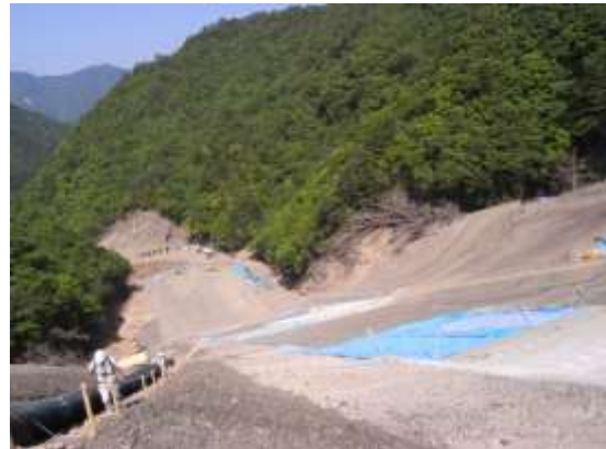
写真 6-4-2 仮排水路 (斜面部, 上方より)
