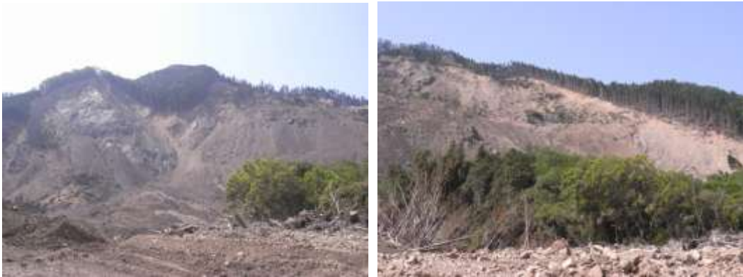
写真 6-2-1 滑落崖の状況（左：正面，右：向かって右側，平成 24 年 5 月 27 日撮影）
