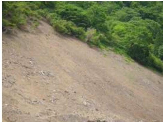
写真 7-2-5 対岸側の崩積土
