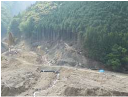
写真 7-1-2 小原沢左岸に乗り上げて堆積している土石流堆積物
