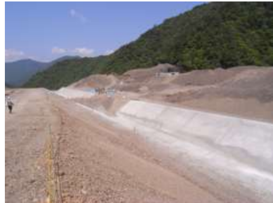
写真 6-4-4 仮排水路 (一般部)
