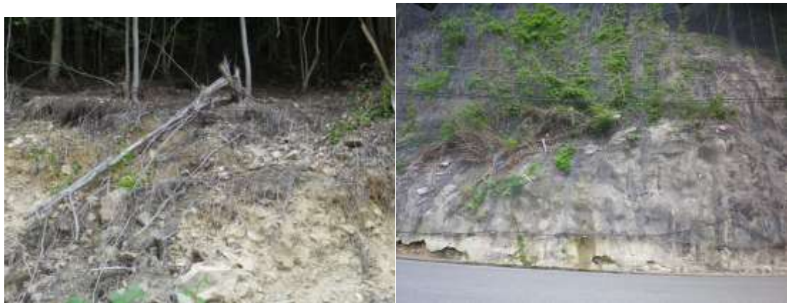
写真 7-3-3 発電所上方斜面の植生は上流側に流された跡がある（左側が上流側）
