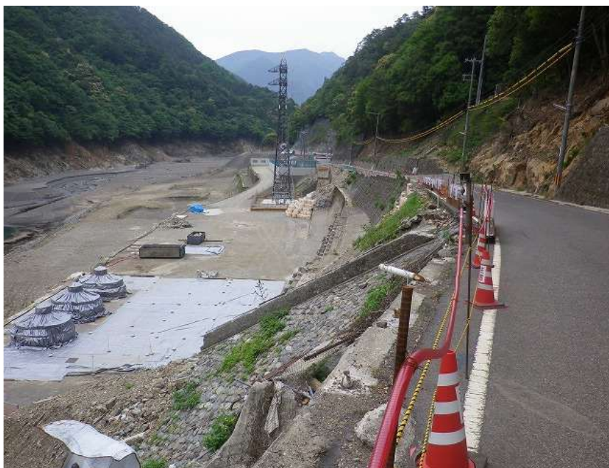
写真 7-3-1 復旧が進む長殿発電所
