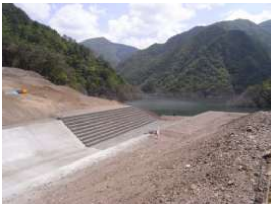
写真 6-4-3 仮排水路 (一般部)
