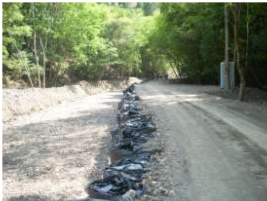
（長殿地区：フレコンバックでの流路確保）
