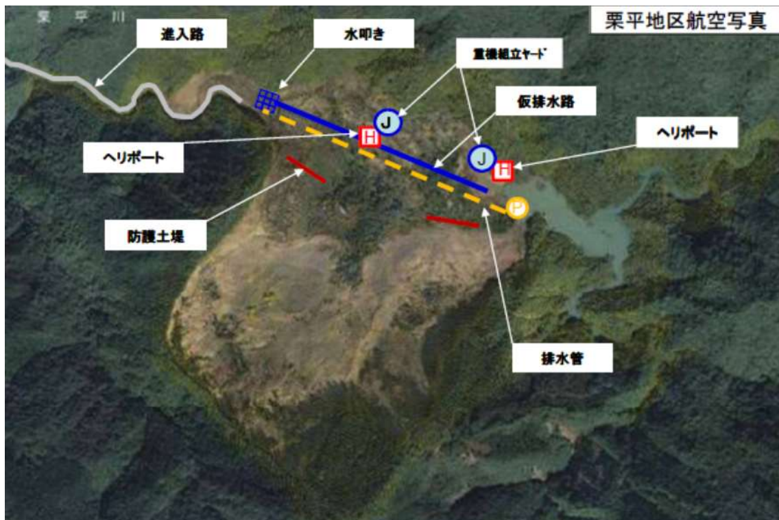
写真 6-1-3 栗平地区崩壊状況と復旧（国土交通省近畿地方整備局 12) より）
