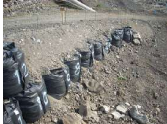
（野尻地区：仮設道路の法面の押えへの利用）
