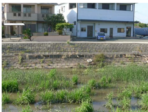
秋津川右岸の護岸崩落
