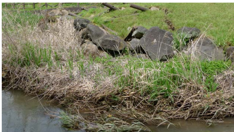
石積護岸の崩落
