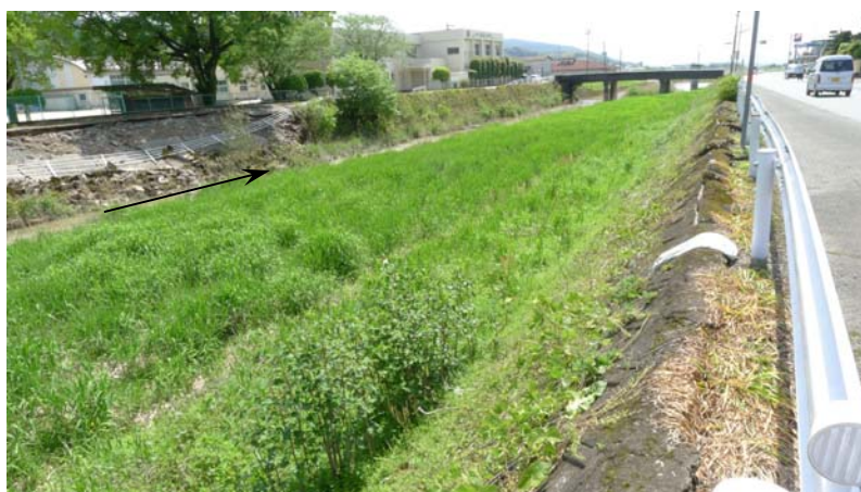
右岸護岸の目地ずれ
