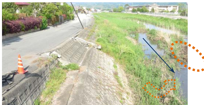
堤体の内部の液状化による護岸の崩落を示唆
