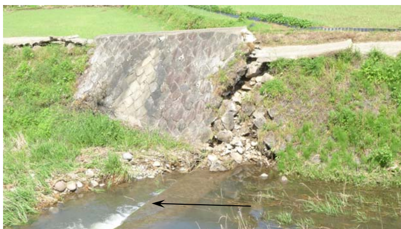
同位置における右岸の亀裂
