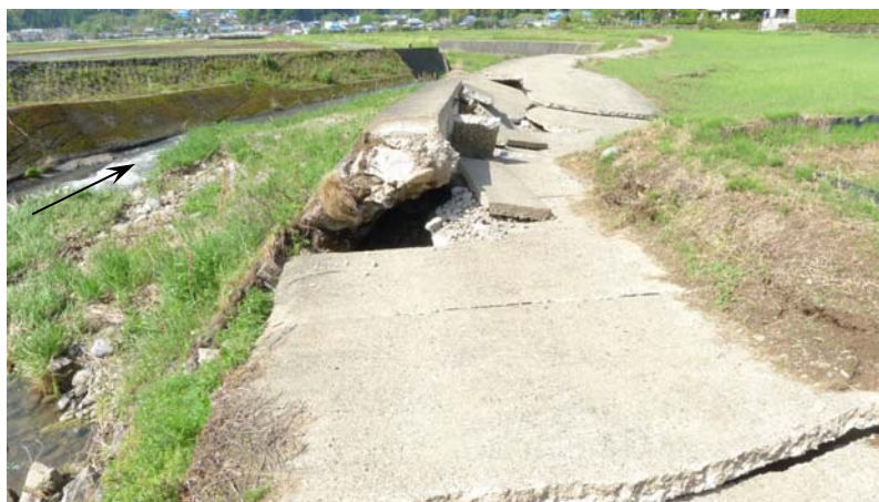
同位置における右岸天端の損壊
