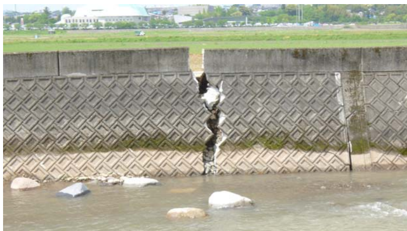
右岸側護岸の損壊状況
