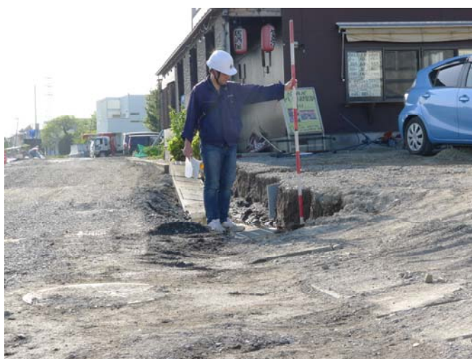
右岸天端は液状化により沈下
