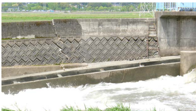
堰直下流の右岸側護岸の損壊状況
