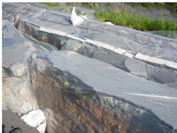
秋津川右岸の堤防天端の損壊
