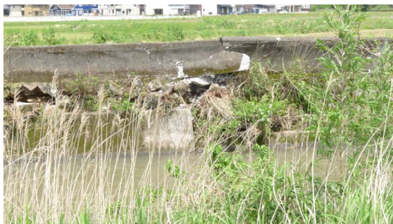
右岸側護岸の損壊状況
