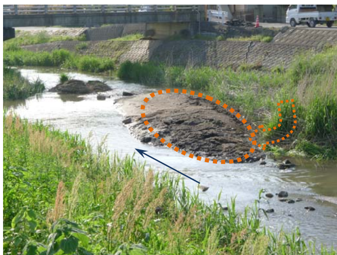
堤体の内部の土砂が流出し河道内に砂州を出現させたことを示唆
