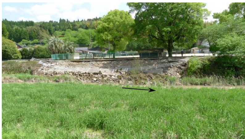
左岸側における長さ 45m に亘る護岸崩落
