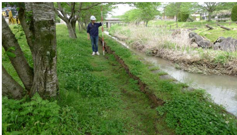
護岸と天端の段差
