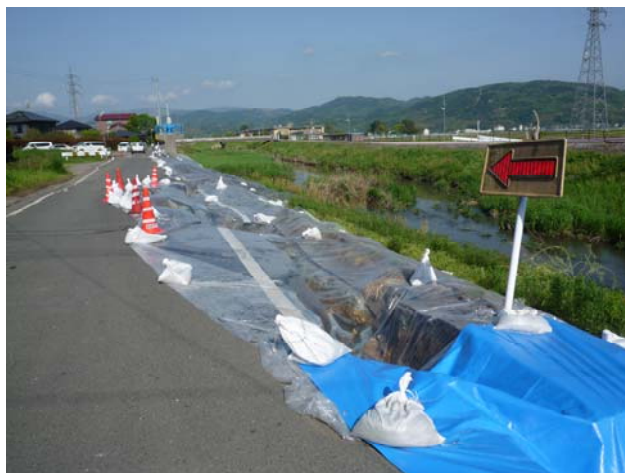
秋津川右岸の堤防天端の縦断亀裂
