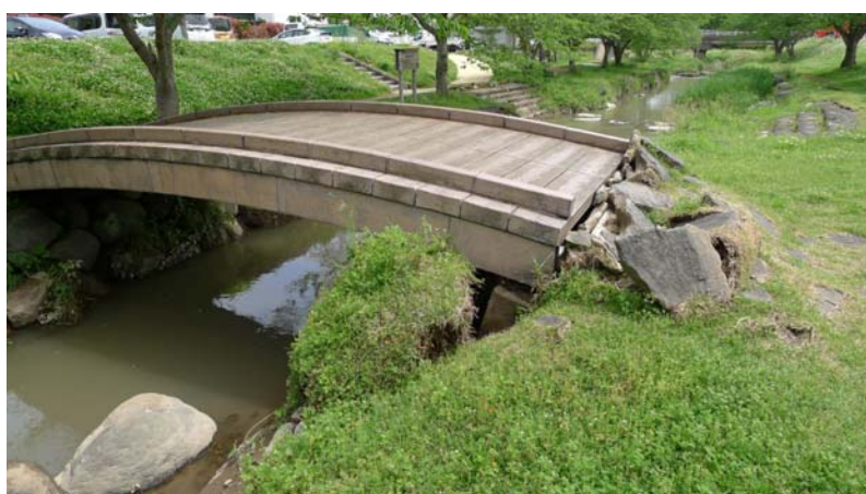
人道用アーチ橋の損壊
