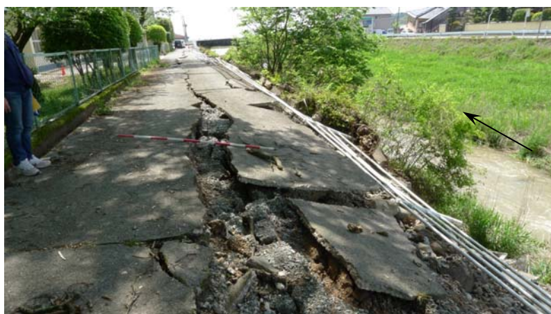
左岸天端において長さ 150m に亘る縦断亀裂の発生
