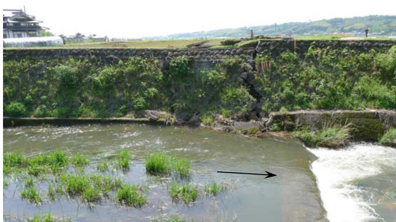
金山川下陳地先の左岸の亀裂
