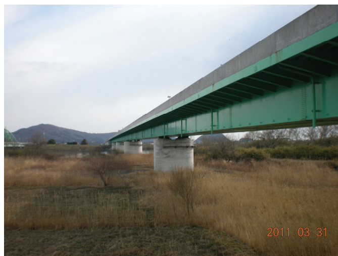
写真-9.2.1.2.7-1 新天王橋（三陸自動車道）
