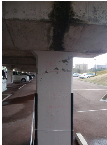
写真 9.2.2.2.3-11 ラーメン高架橋柱の損傷
