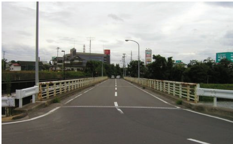
写真-9.2.1.2.3-2 宝堰橋車道橋の橋面（平成18年7月撮影、宮城県ホームページより）
