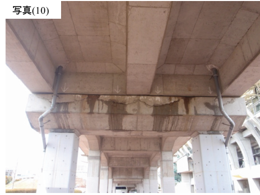
写真 9.2.2.2.3-10 桁受け梁部の損傷 (R8)
