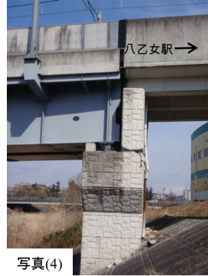
写真 9.2.2.2.3-4 パラペット部の損傷
