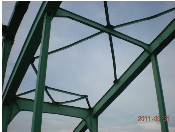
写真-9.2.1.2.6-2 トラス上横斜材の破断（1箇所目）
