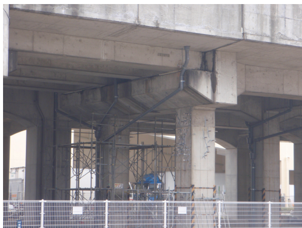
写真 9.2.2.1.1-4 せん断により損傷したかぶりコンクリートの補修（樹脂注入）
