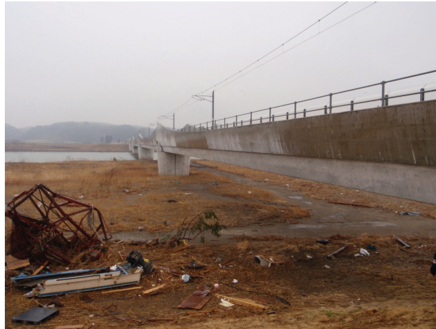
写真 9.2.2.2.1-1 鳴瀬側橋梁（左岸側より撮影）
