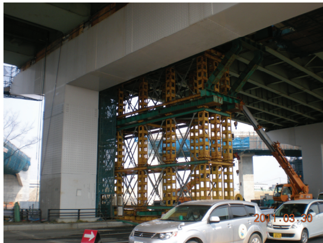
写真-9.2.1.1.2-3 積層ゴム支承が破断した P56 橋脚のベントによる仮支持
