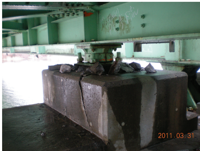
写真-9.2.1.2.6-5 固定側のピボット支承の沓座コンクリートの損傷
