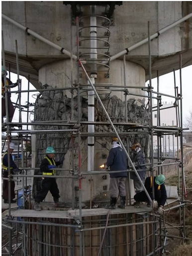
写真 9.2.2.1.2-2 段落し位置の損傷の様子（岩切線路橋 単柱式 RC 柱）（JR 東日本提供）
