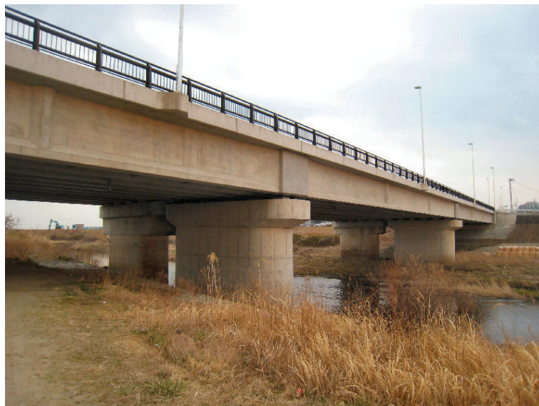
写真 9.2.1.5-1 城前大橋（左岸側から，手前が新橋）
