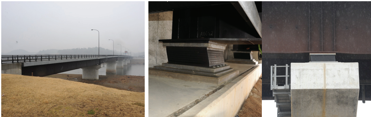
写真 9.2.1.1.3-1 東松島大橋の全景と橋台部と橋脚部の支承の残留変形
