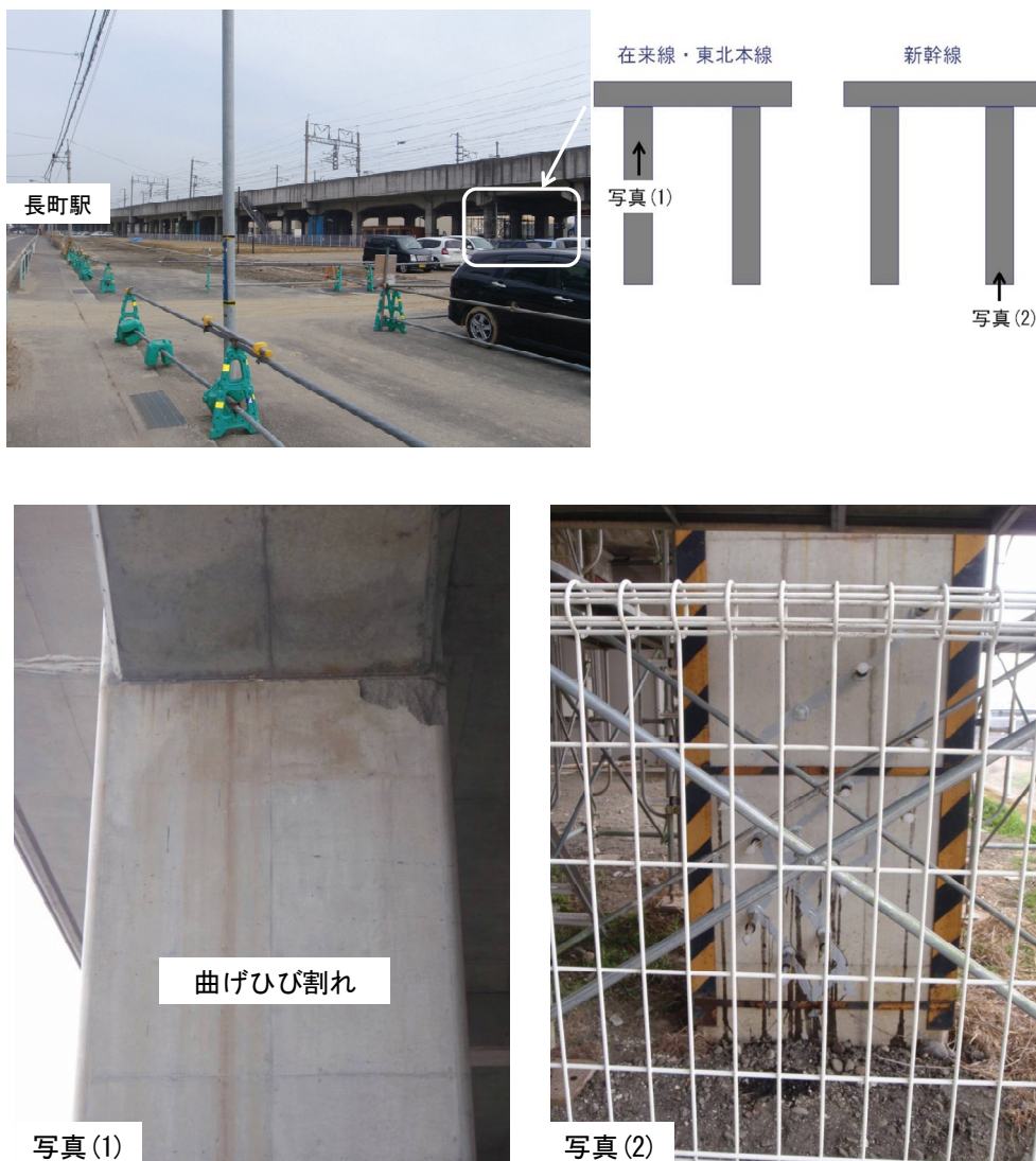
写真 9.2.2.2-1 東北新幹線と東北本線ラーメン高架橋の損傷状況の比較
