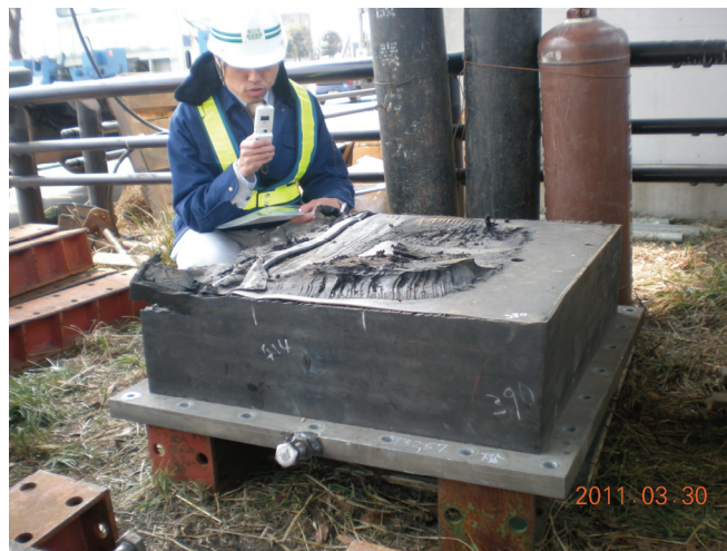
写真-9.2.1.1.2-6 積層ゴムの上部で破断(P52 橋脚)
