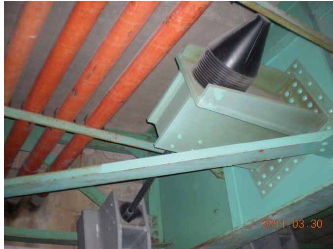
写真-9.2.1.2.3-3 耐震補強工事で設置された落橋防止構造 (PC ケーブル)
