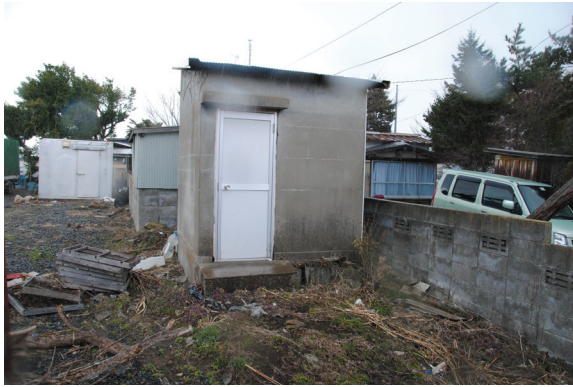
写真 9.2.1.2.5-3 地盤上の強震観測小屋
