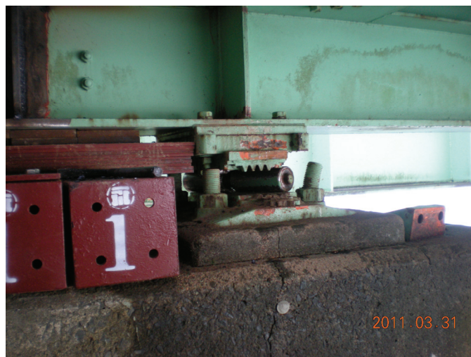
写真-9.2.1.2.6-6 可動側のローラー支承のローラーの逸脱
