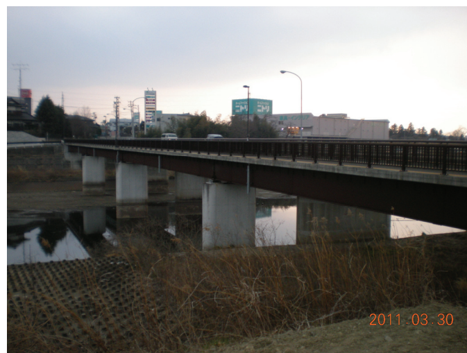
写真-9.2.1.2.3-5 宝堰橋歩道橋
