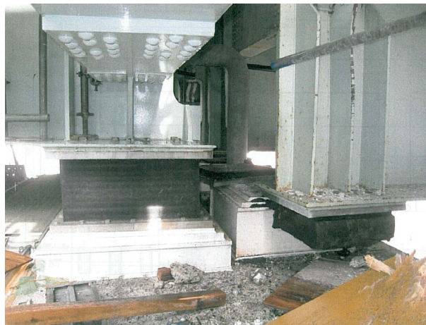
写真-9.2.1.1.2-1 積層ゴム支承の橋軸直角方向への破断(P56 橋脚,G8 桁)(NEXCO 東提供)
