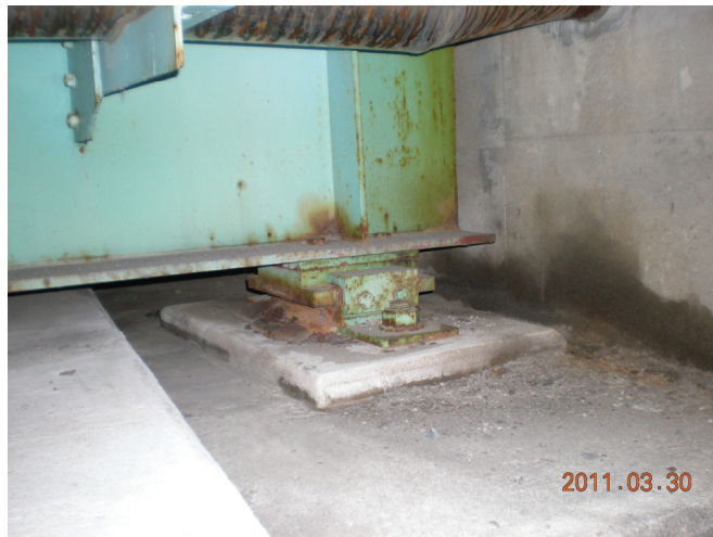
写真-9.2.1.2.3-4 建設時と考えられる支承板支承
