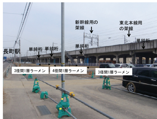
写真 9.2.2.1.1-1 長町駅南側にあるラーメン高架橋
