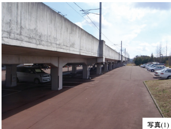
写真 9.2.2.2.3-1 1層 RC ラーメン高架橋
