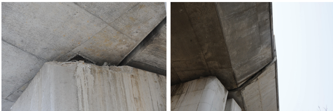
写真 9.2.1.1.1-1 支承取り付け部の損傷と橋桁の橋軸直角方向への移動
