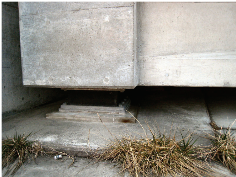
写真 9.2.1.5-3 支承の状況 (左岸側)
