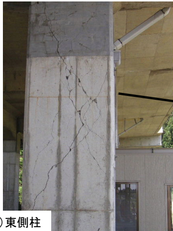
写真 9.2.2.1.4-2 第 5 猪鼻高架橋の損傷の様子 (R15)
