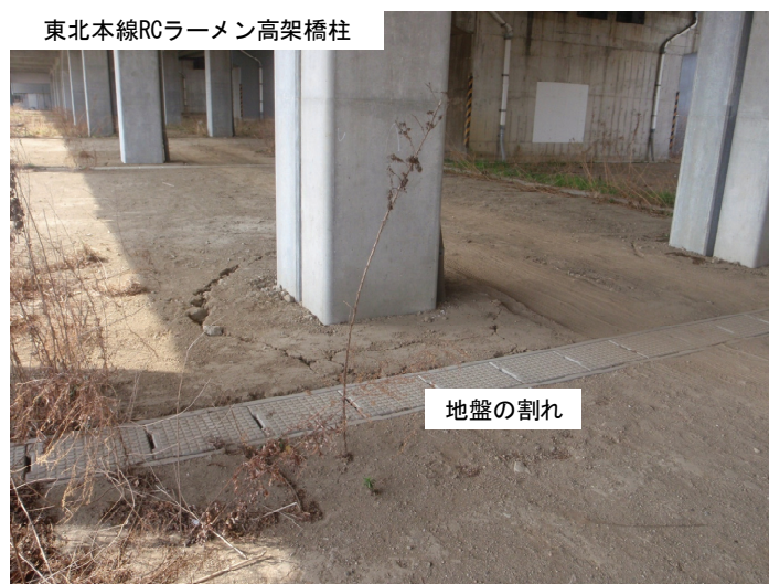
写真 9.2.2.2.2 東北本線 RC ラーメン高架橋柱周辺地盤に生じた割れの様子
