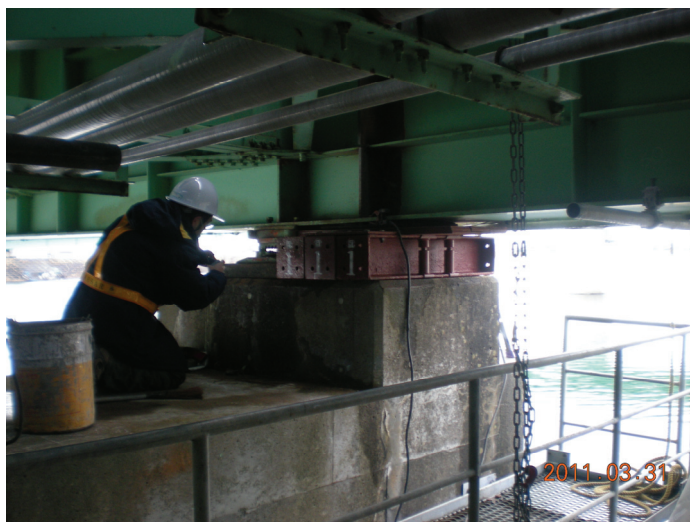
写真-9.2.1.2.6-7 ローラー支承のサンドルによる仮支持
