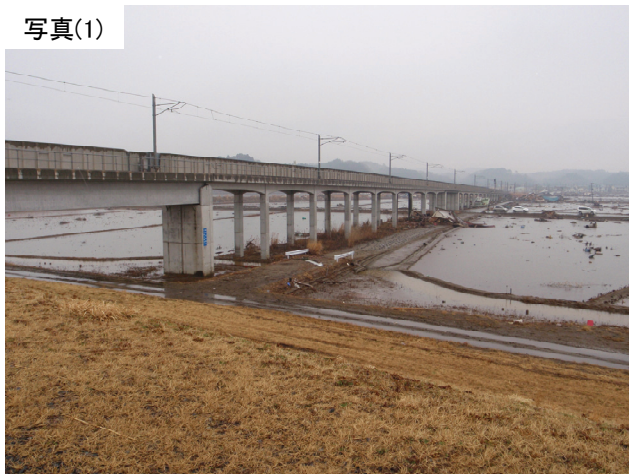
写真 9.2.2.2.1-2 ラーメン高架橋全景
