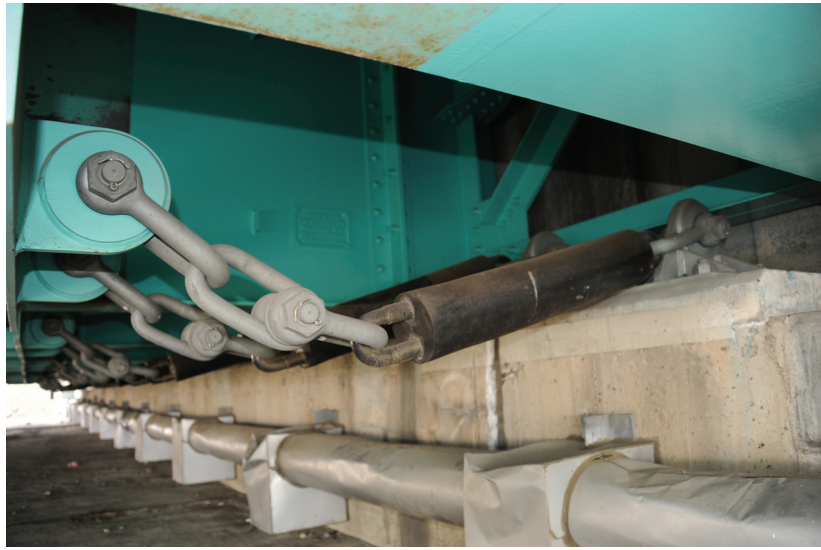
写真 9.2.1.2.1-4 落橋防止構造
