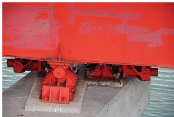
写真 9.2.1.2.5-2 オイルダンパー
