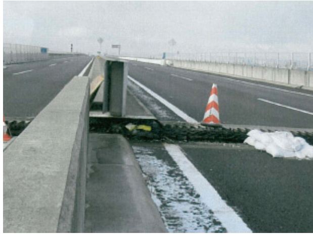
写真-9.2.1.1.2-2 路面上フィンガージョイント部(P56 橋脚)の段差(NEXCO 東提供)
