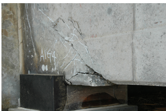
写真 9.2.1.2.2 閑上大橋の全景と橋脚基部と橋台部の支承および支間中央のヒンジ部
