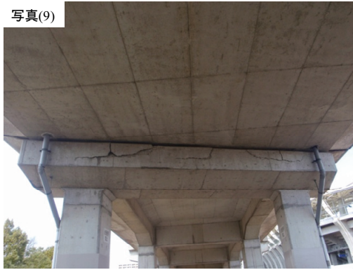
写真 9.2.2.2.3-9 桁受け梁部の損傷 (R7)
