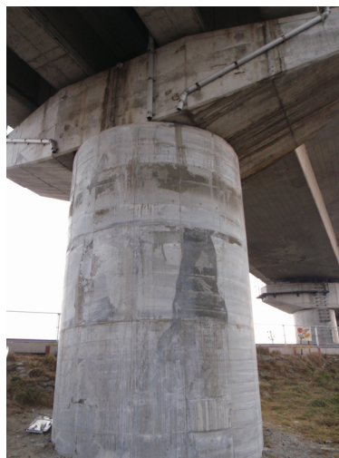
写真 9.2.2.1.2-3 段落し位置で損傷した RC 柱の補修後の様子
