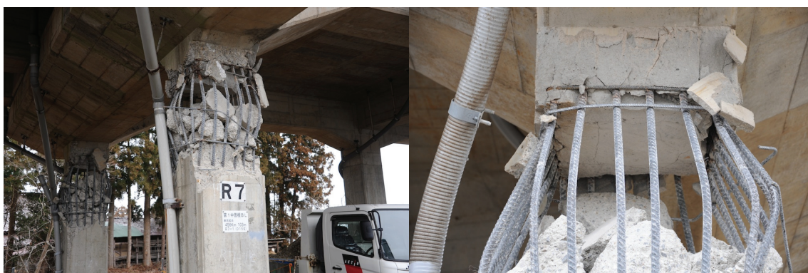
写真 9.2.2.1.3-2 第 1 中曽根高架橋 R7 における端部柱上部の破壊状況
