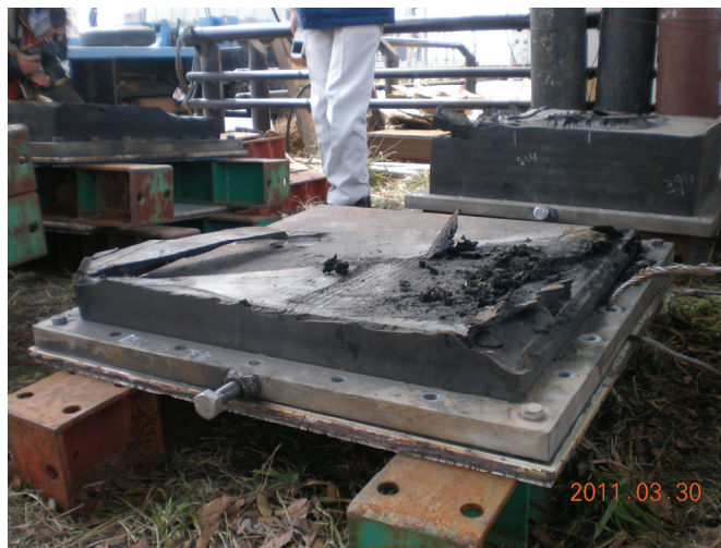
写真-9.2.1.1.2-7 積層ゴムの中段で破断(P52 橋脚)
