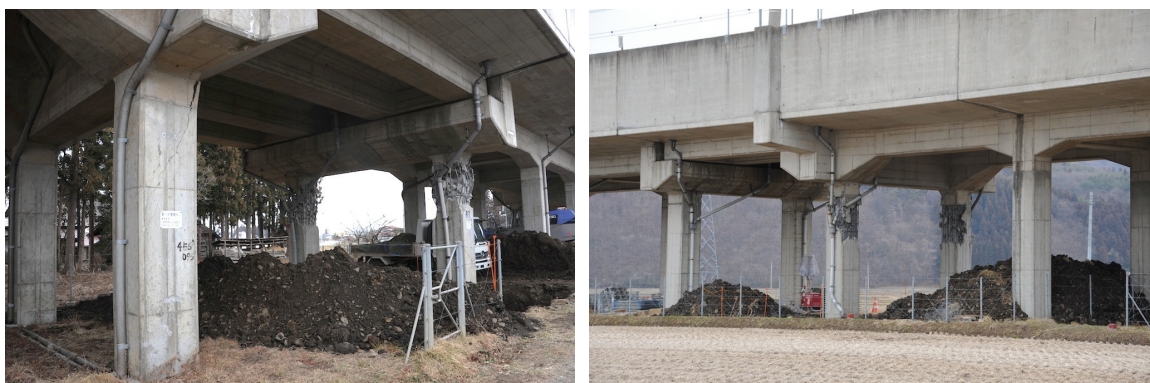
写真 9.2.2.1.3-1 第 1 中曽根高架橋における端部柱の破壊
