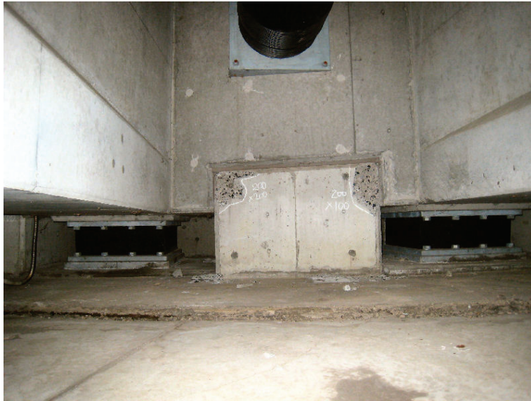
写真 9.2.1.5-2 直角方向の固定装置に生じたはく離 (左岸側)
