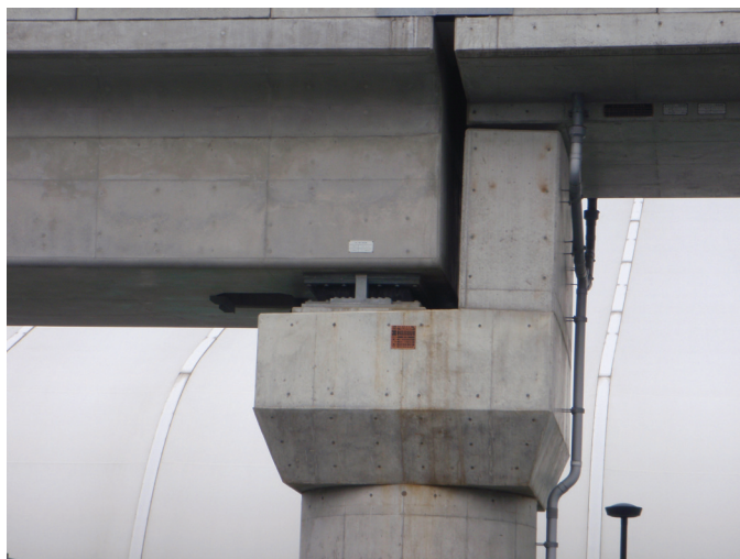
写真 9.2.2.2.2-4 積層ゴム支承のせん断変形
