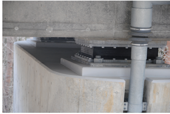
写真 9.2.1.1.4-2 橋脚上の支承
