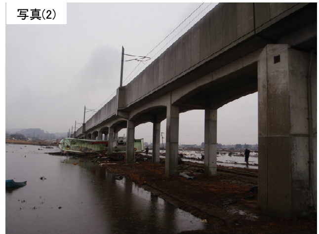
写真 9.2.2.2.1-3 4径間ラーメン高架橋
