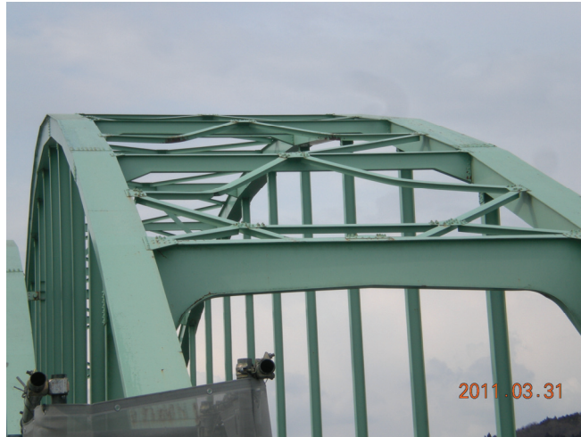
写真-9.2.1.2.6-4 トラス上横斜材の座屈
