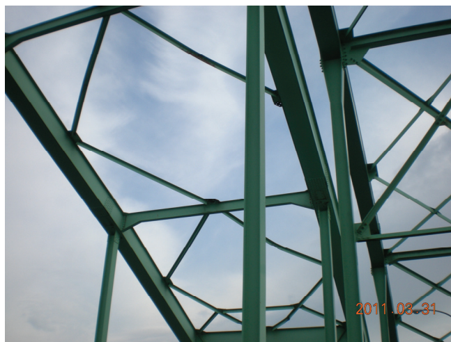
写真-9.2.1.2.6-3 トラス上横斜材の破断（2箇所目）
