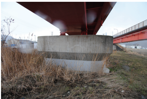
写真 9.2.1.2.5-5 鋼板巻き立てで耐震補強された P3
