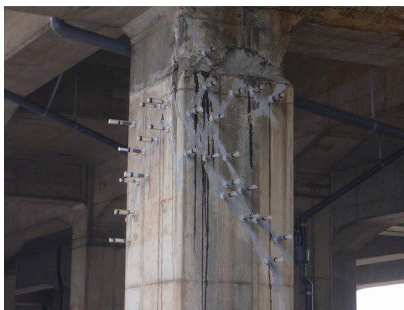
写真 9.2.2.1.1-4 せん断により損傷したかぶりコンクリートの補修（樹脂注入）
