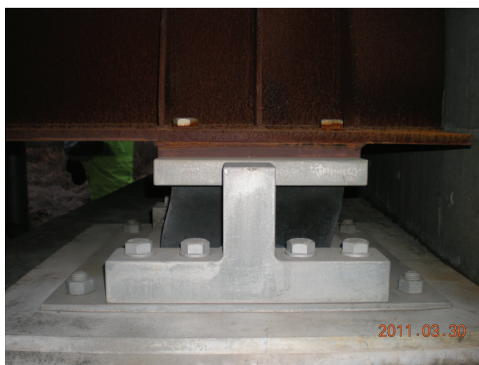
写真-9.2.1.2.3-7 宝堰橋歩道橋に設置されていた積層ゴム支承
