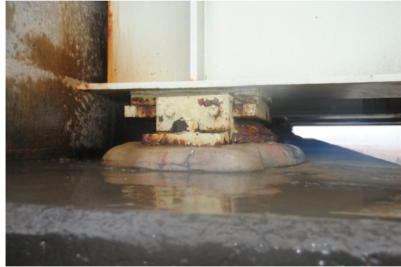
写真 9.2.1.2.4-2 橋台上支承部
