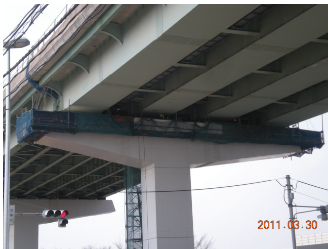
写真-9.2.1.1.2-4 積層ゴム支承が破断した P52 橋脚
