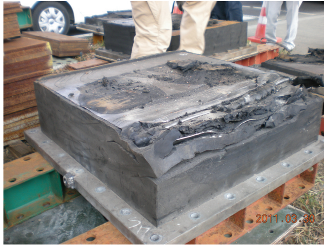
写真-9.2.1.1.2-8 内部鋼板の一部が大きく塑性変形した積層ゴム支承(P52 橋脚)
