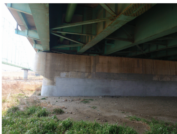
写真 9.2.1.2.1-2 橋脚の補強
