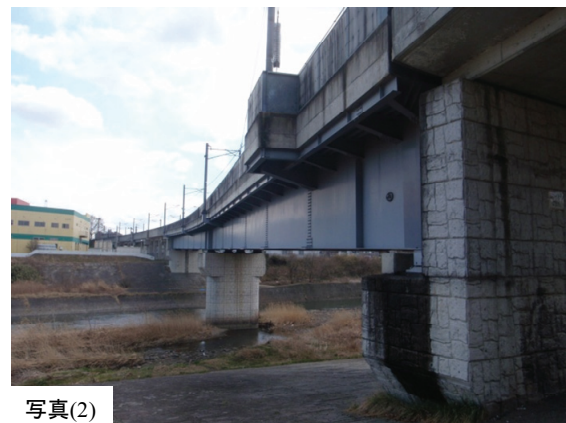
写真 9.2.2.2.3-1 2径間鋼箱桁橋
