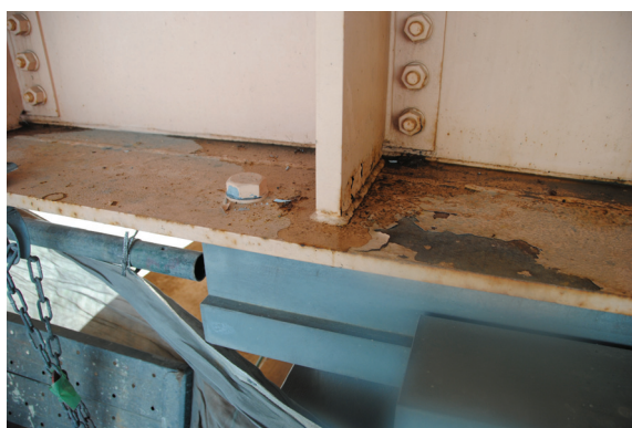
写真 9.2.1.2.8-4 支承と桁のセットボルトのゆるみ
