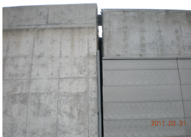
写真-9.2.1.2.7-3 橋台と擁壁の境界部の目開き
