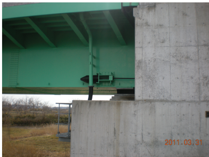
写真-9.2.1.2.7-2 積層ゴム支承及び落橋防止構造
