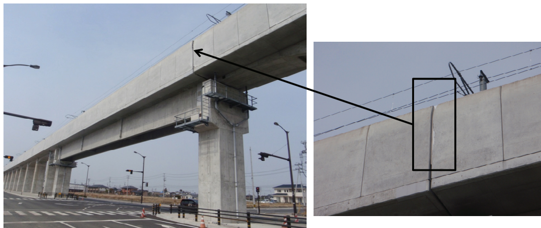
写真 9.2.2.2.2-4 防音壁部の損傷
