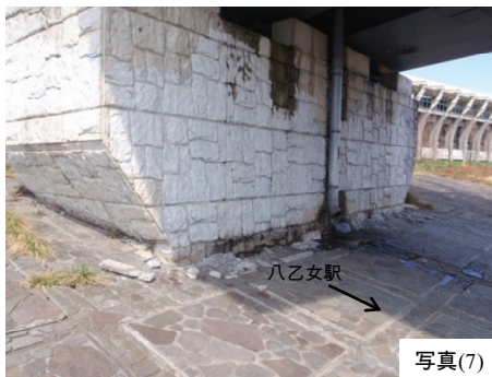
写真 9.2.2.2.3-7 橋台全面の岸壁の損傷
