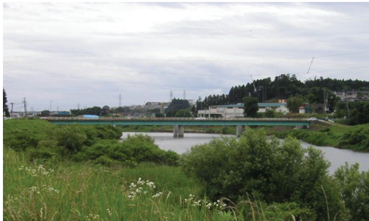
写真-9.2.1.2.3-1 宝堰橋車道橋（平成18年7月撮影、宮城県ホームページより）
