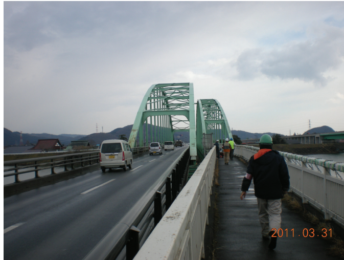
写真-9.2.1.2.6-1 天王橋（国道 45 号）の車道橋と歩道橋
