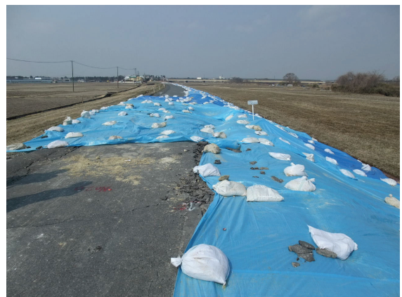
写真 7-4 江合川 30.2km の被災状況
