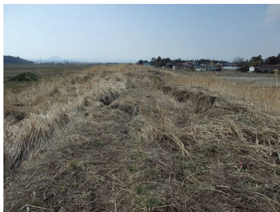
写真 7-1 鳴瀬川左岸国土交通省管轄区間より上流 0.6km の被害
