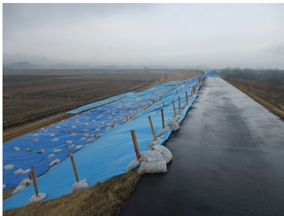
写真7-10 吉田川16.8kmの被災状況
