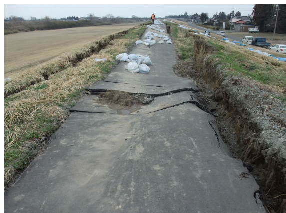
写真 7-5 江合川左岸 21km～21.2km の被災状況
