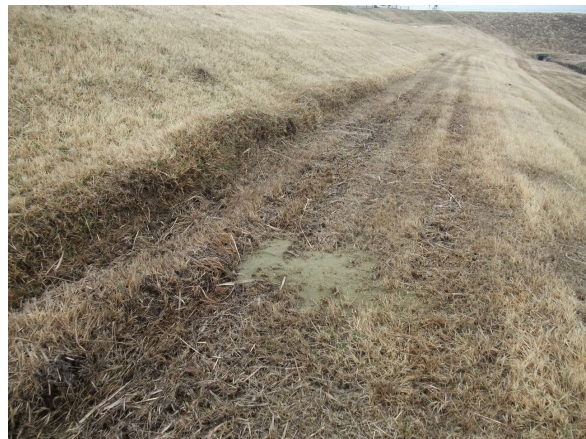
写真7-11 吉田川16.8kmの小段で見られた噴砂
