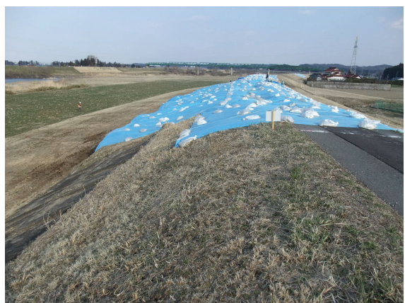
写真 7-2 鳴瀬川左岸 40.06km の被害
