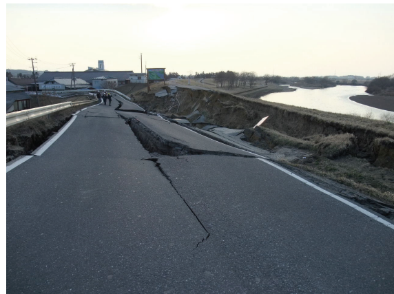
写真 7-3 志田橋右岸取付け盛土の被害
